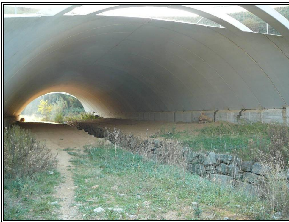
Nº 3.- Vista interior de la estructura.
