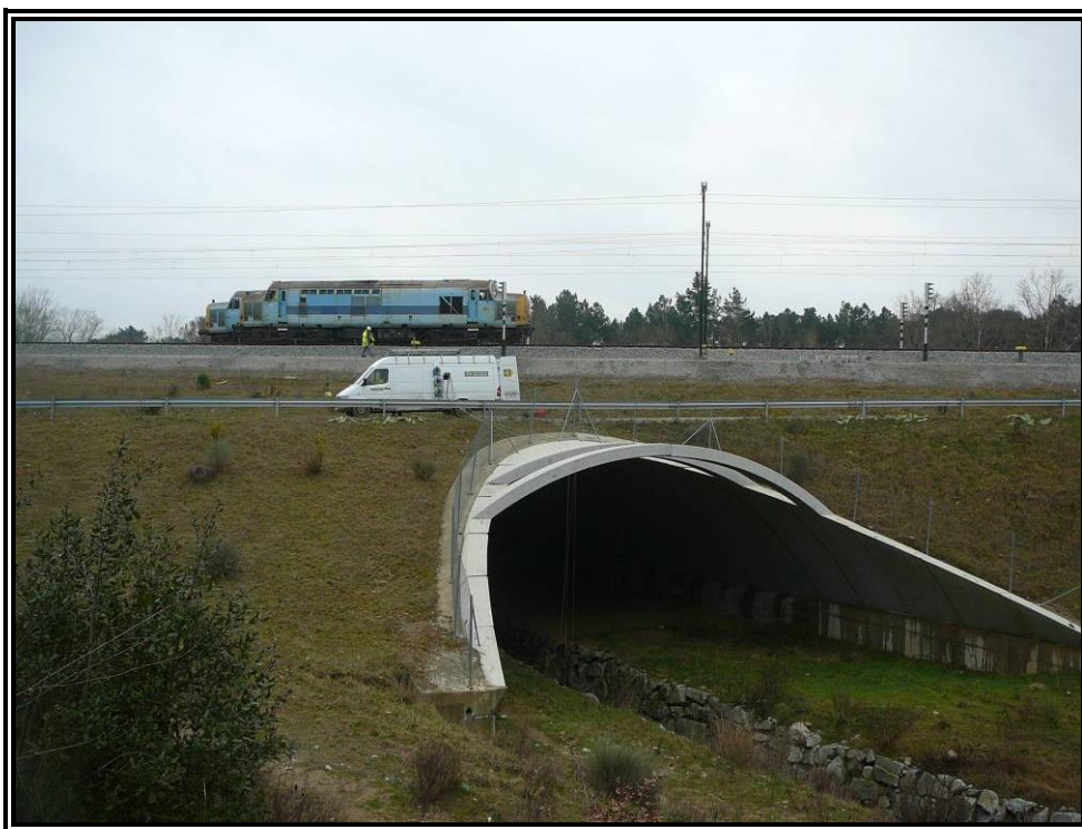
Nº 7.- Realización de prueba estática.
