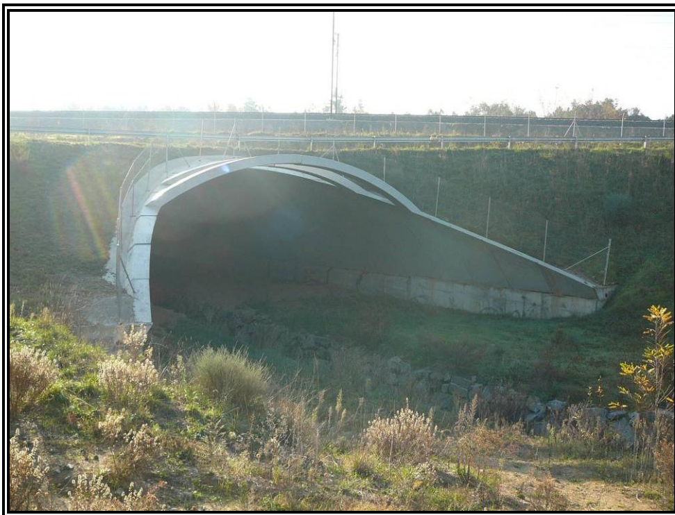
Nº 2.- Alzado izquierdo de la estructura.
