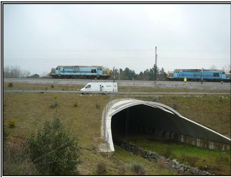
Nº 8.- Realización de prueba dinámica.
