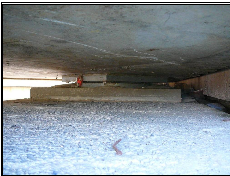
Nº 5.-Detalle de apoyo.
