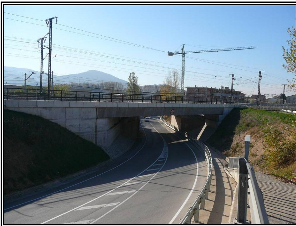
Nº 2.- Alzado izquierdo de la estructura.
