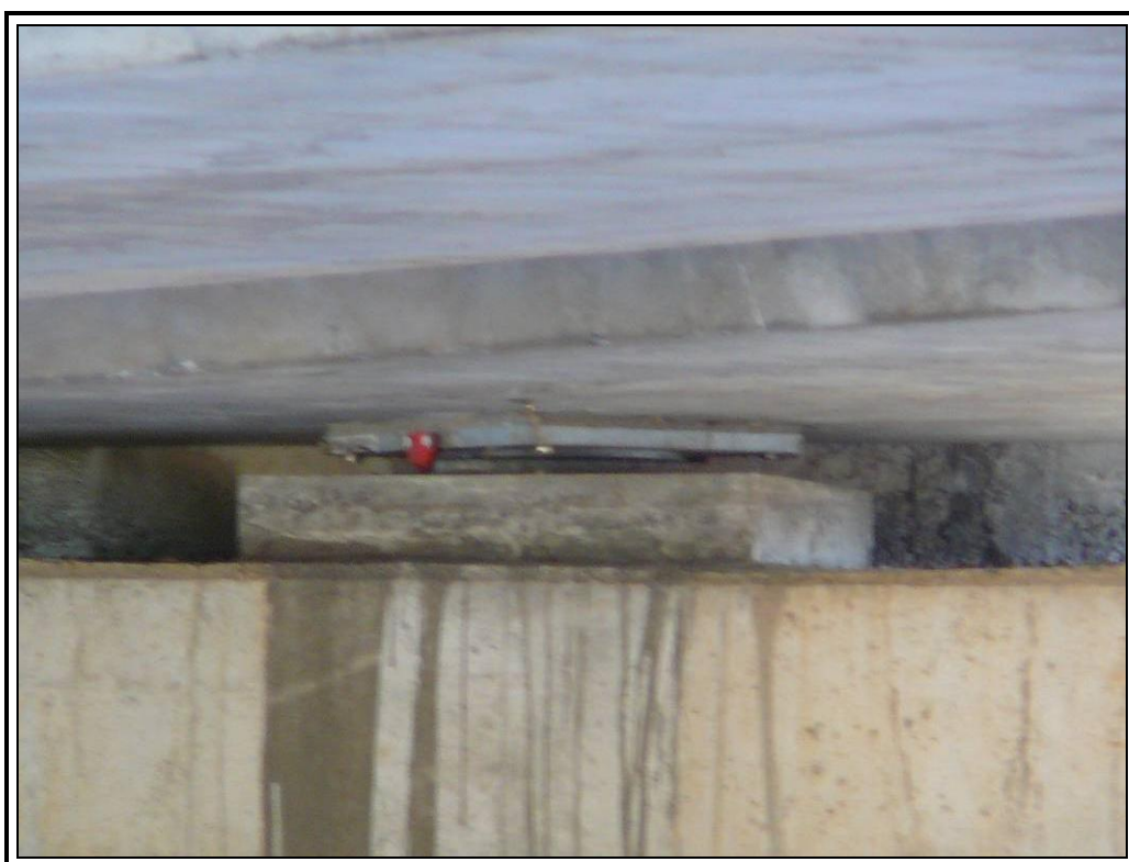
Apoyo E2 bajo viga 3
