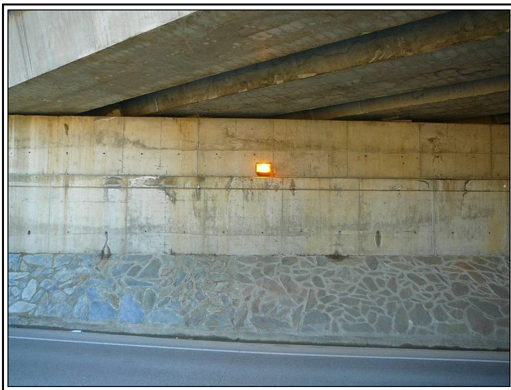
Estribo de salida
