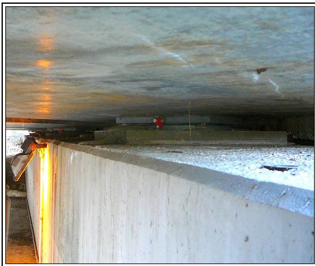
Apoyo E1 bajo viga 1
