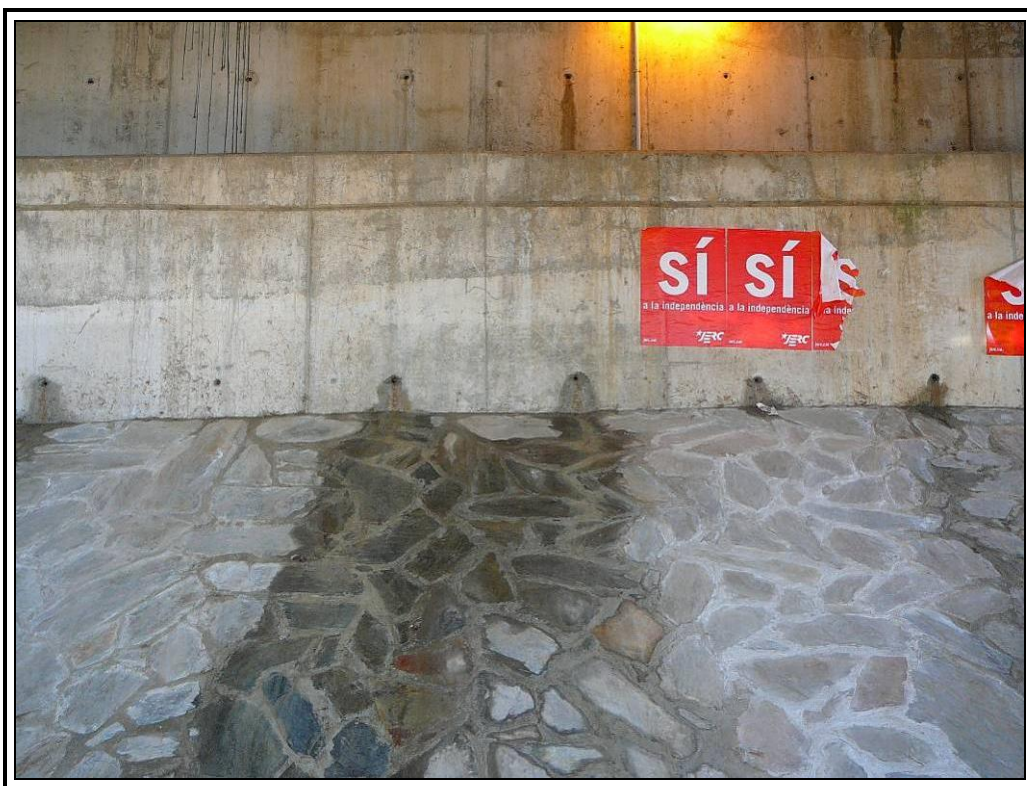
Estribo de entrada
