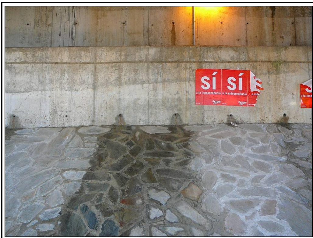
Estribo de entrada
