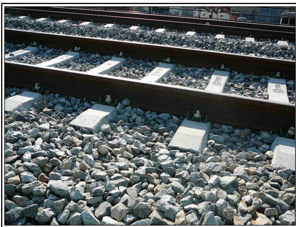
Material de vía
