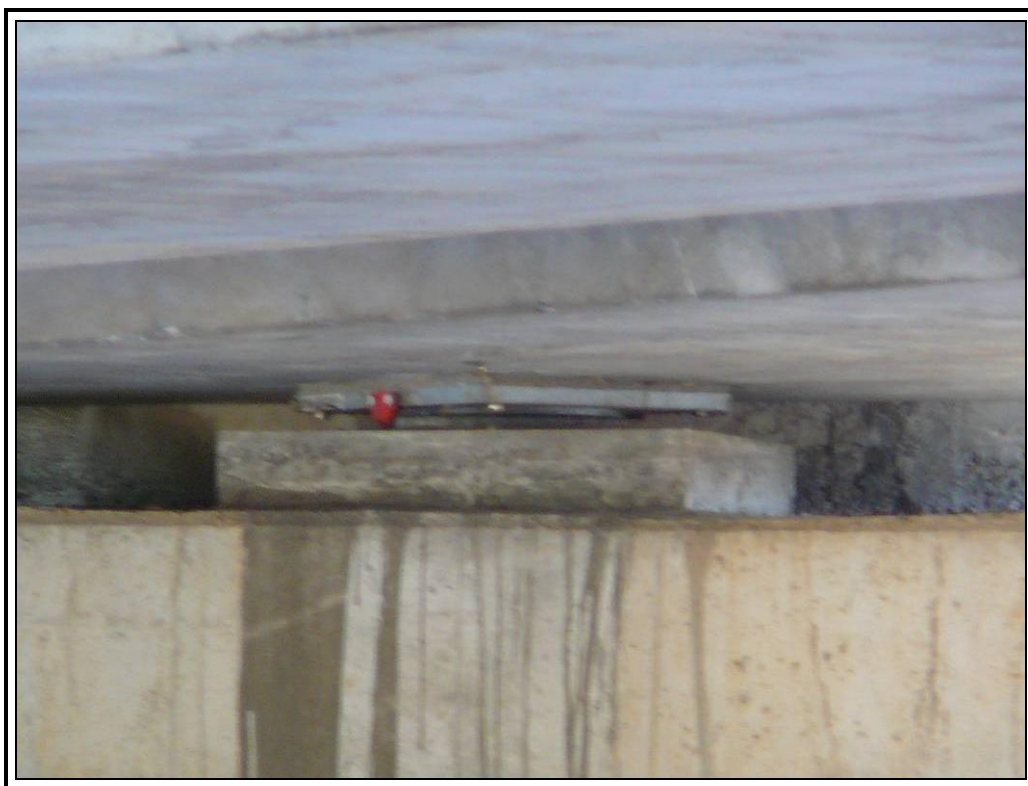
Apoyo E2 bajo viga 3
