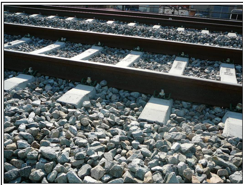
Material de vía
