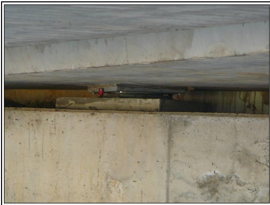
Apoyo E2 bajo viga 2
