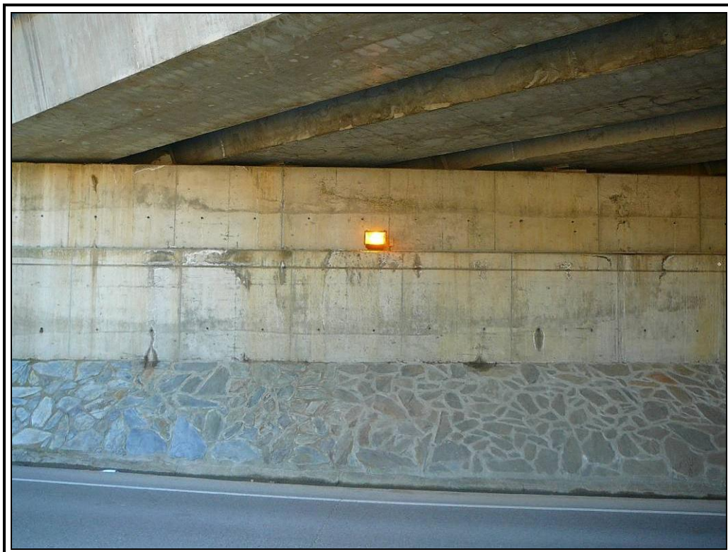
Estribo de salida
