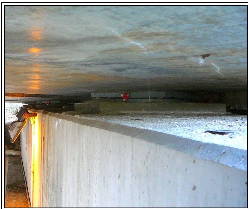
Apoyo E1 bajo viga 1
