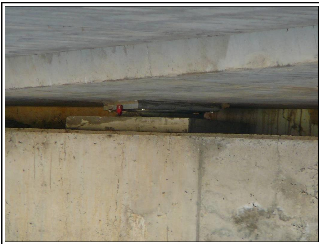
Apoyo E2 bajo viga 2
