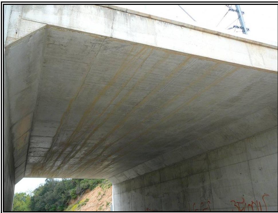
Nº 4.-Vista inferior de la estructura.
