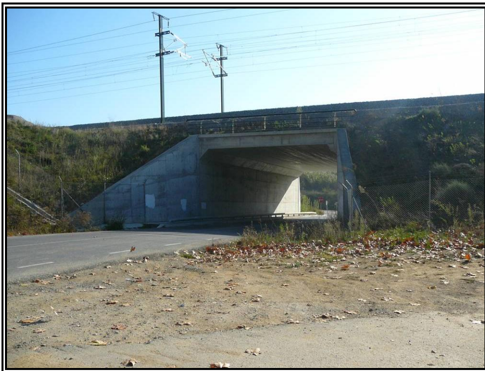
Nº 2.- Alzado izquierdo de la estructura.
