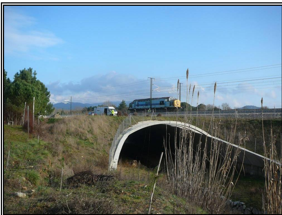
Nº 8.- Realización de prueba dinámica.
