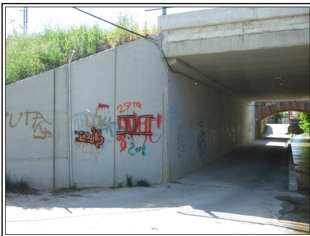
Estribo de salida
