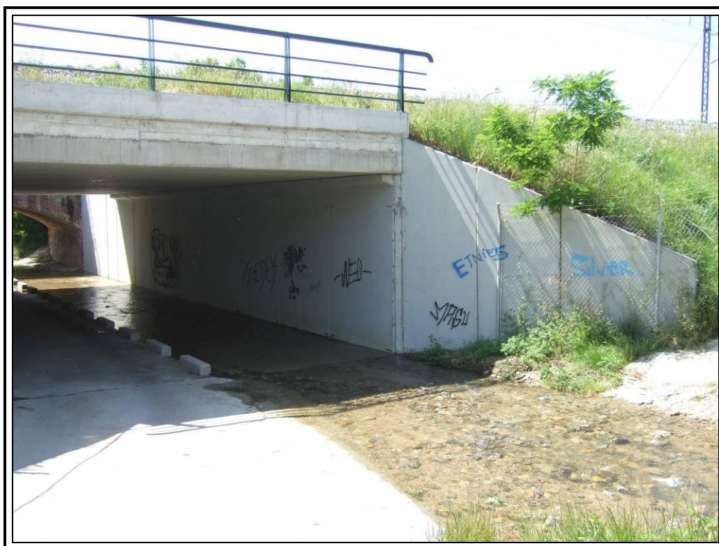
Estribo de entrada
