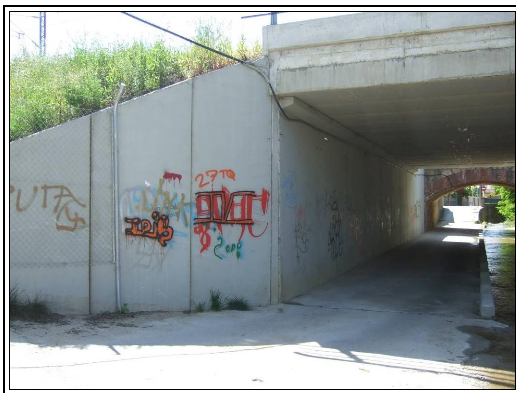
Estribo de salida
