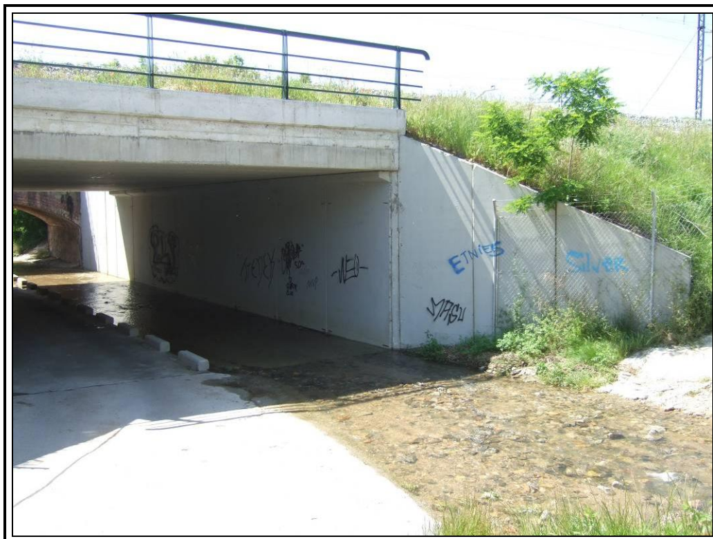
Estribo de entrada
