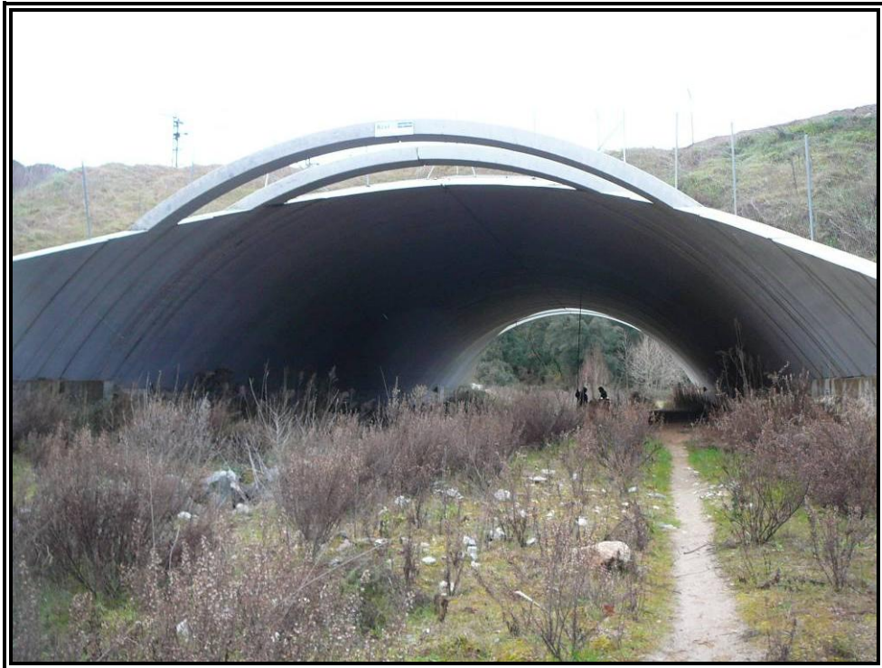
Nº 5.-Colocación de instrumentación.
