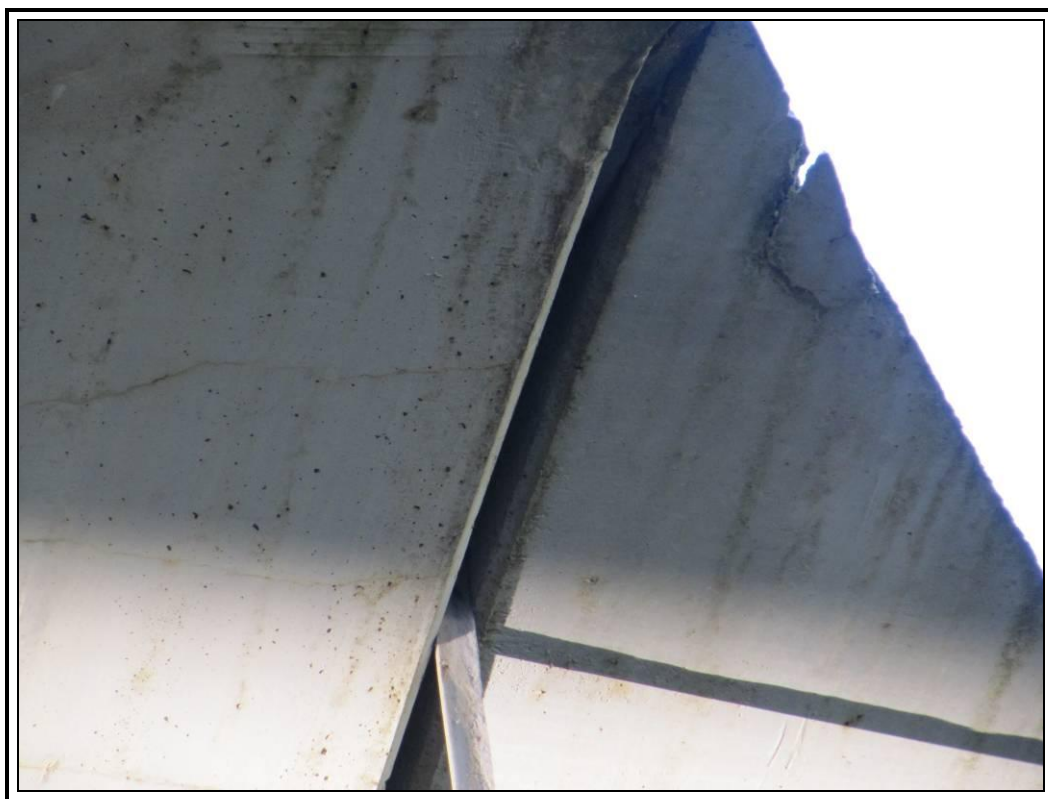
Desconchón en elemento de la flauta lado derecho.
