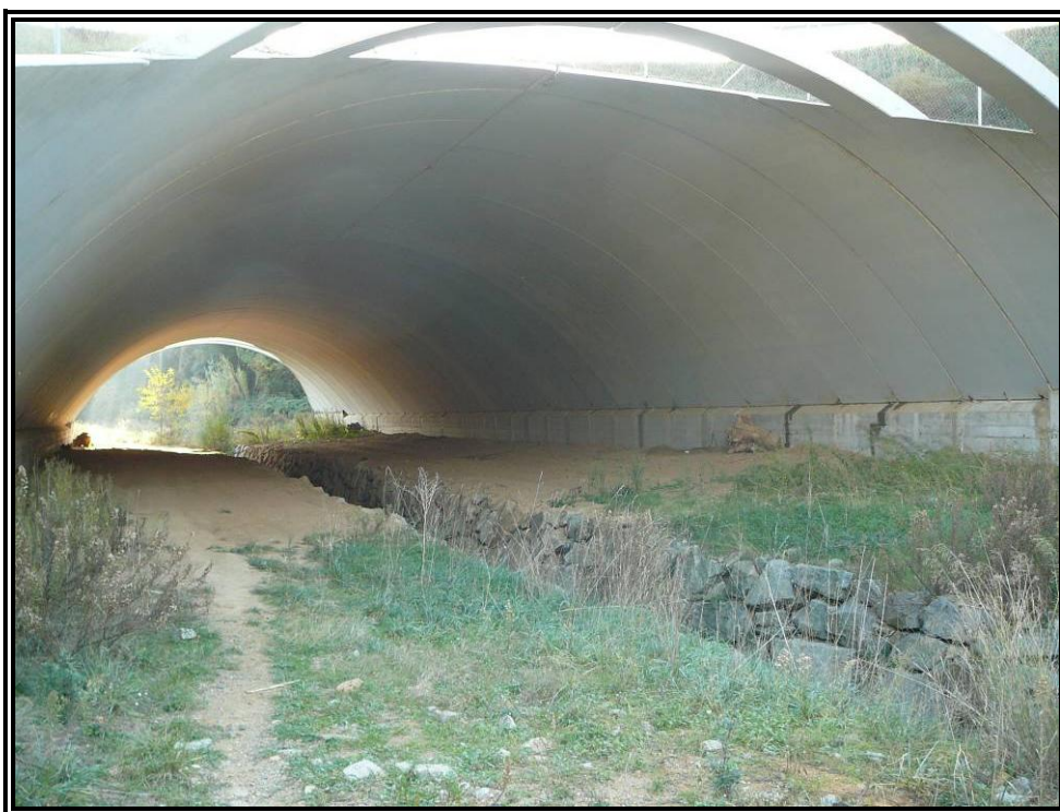
Nº 3.- Vista interior de la estructura.
