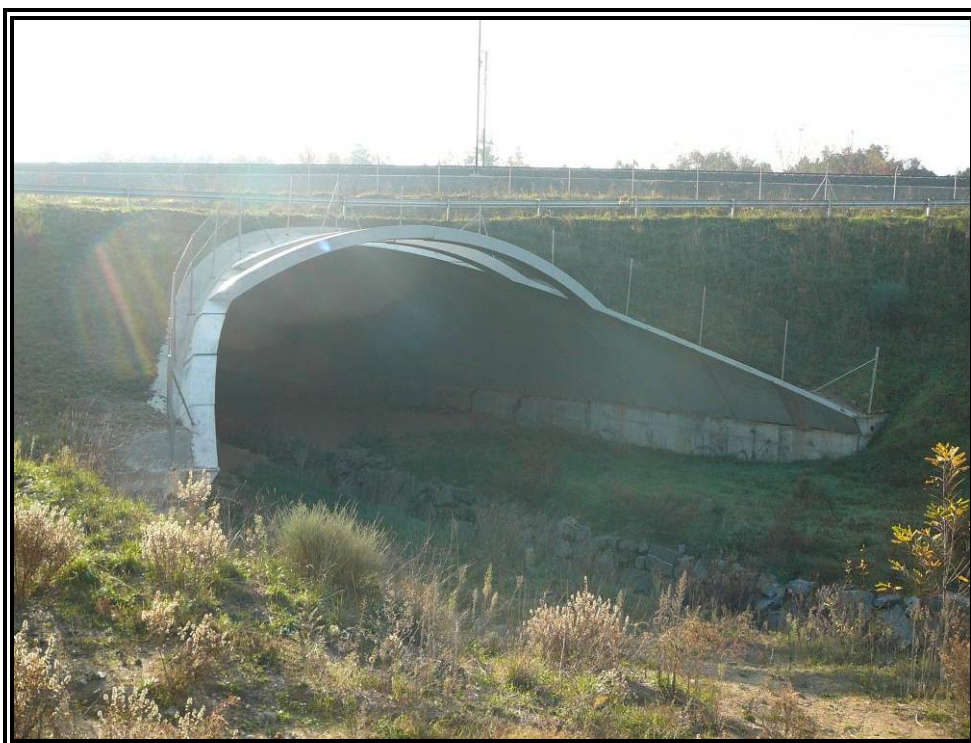
Nº 2.- Alzado izquierdo de la estructura.
