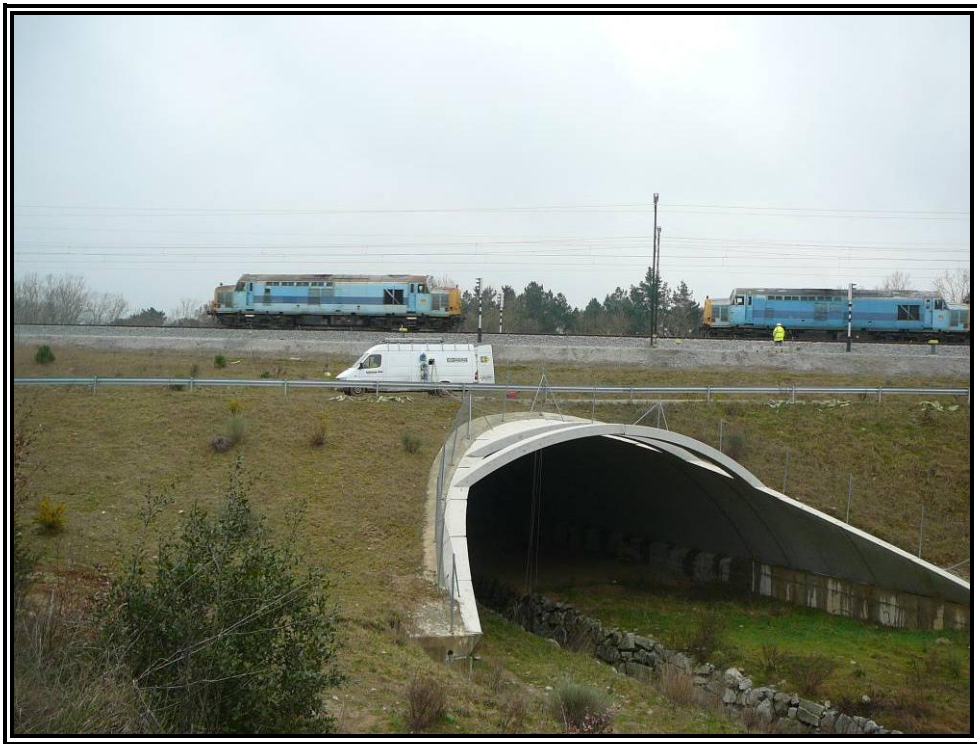
Nº 8.- Realización de prueba dinámica.
