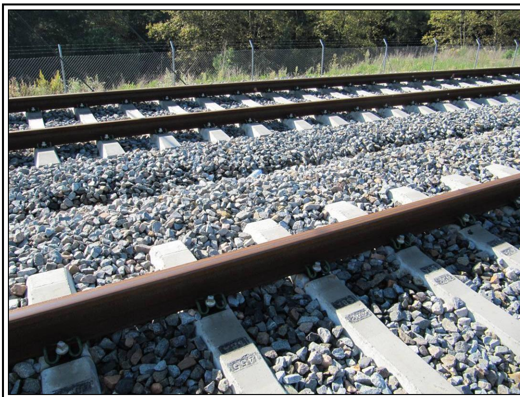
Material de vía.
