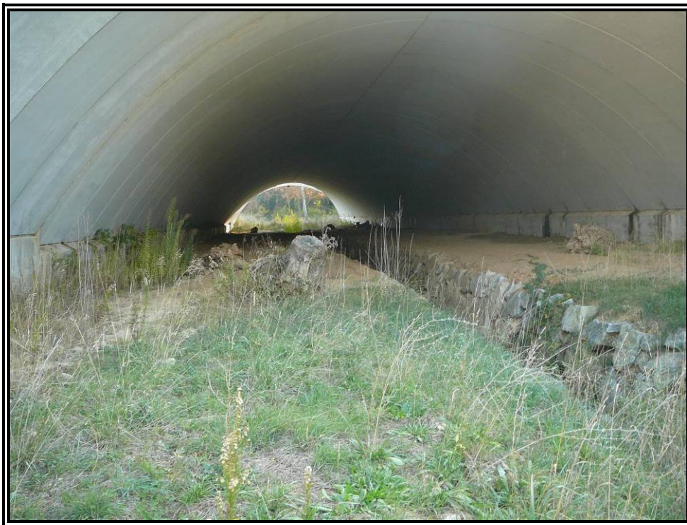
Nº 3.- Vista interior de la estructura.
