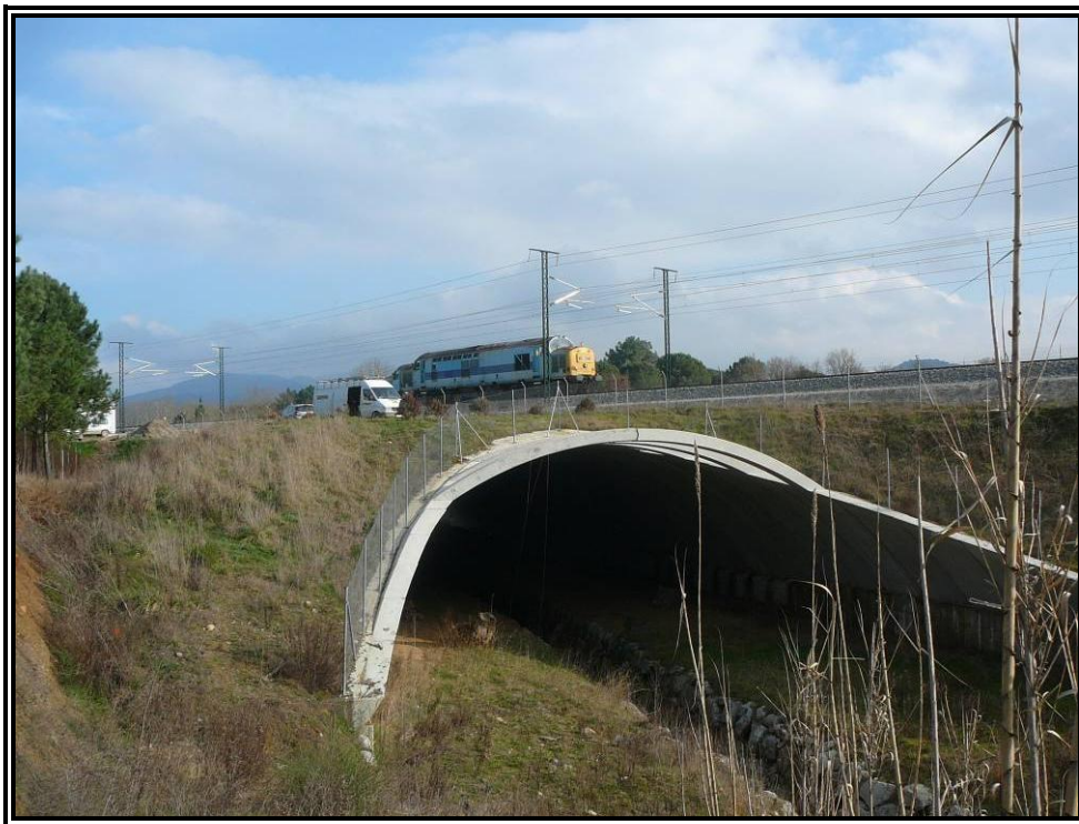
Nº 7.- Realización de prueba estática.
