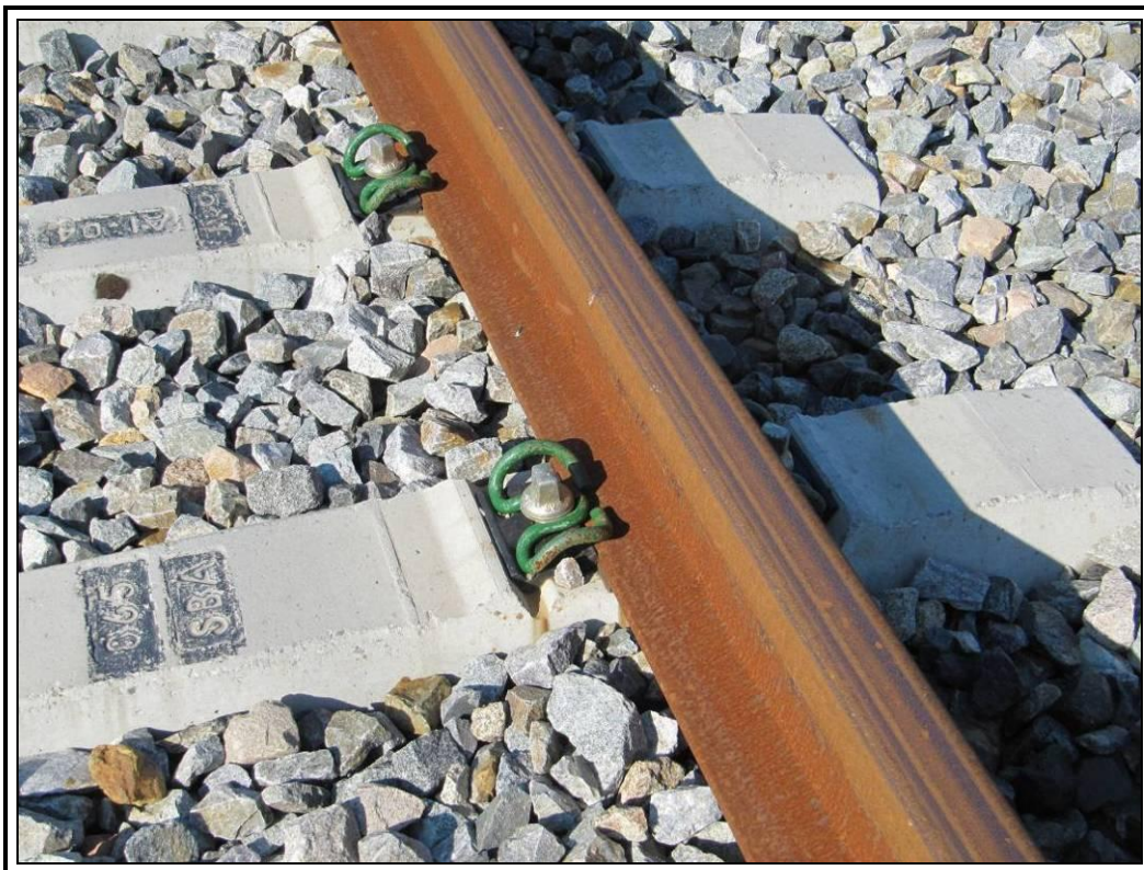
Material de vía.
