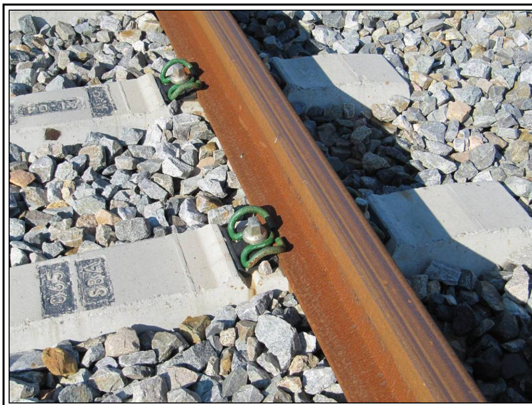
Material de vía.
