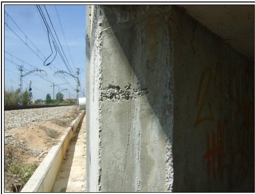
Nido de grava en extremo derecho de hastial uno
