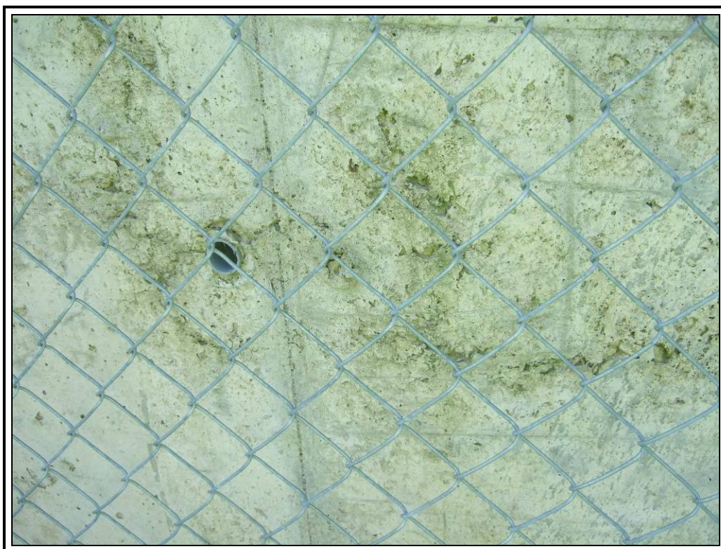
Rozadura en paramento de hastial dos
