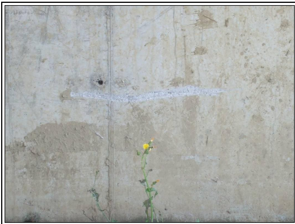
Rozadura en paramento de hastial dos
