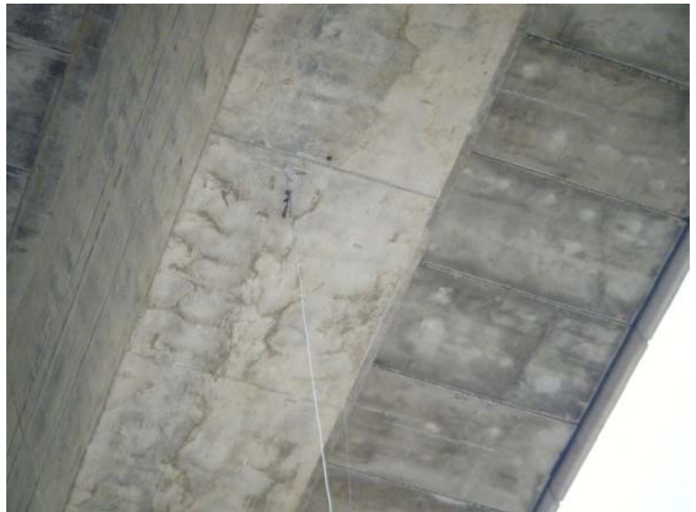
Fotografía N°16: Banda extensiométrica en vano 3
