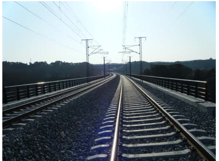
Fotografía N°7: Vista desde Estribo 2
