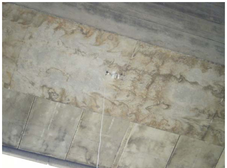
Fotografía N°17: Banda extensiométrica en vano 4
