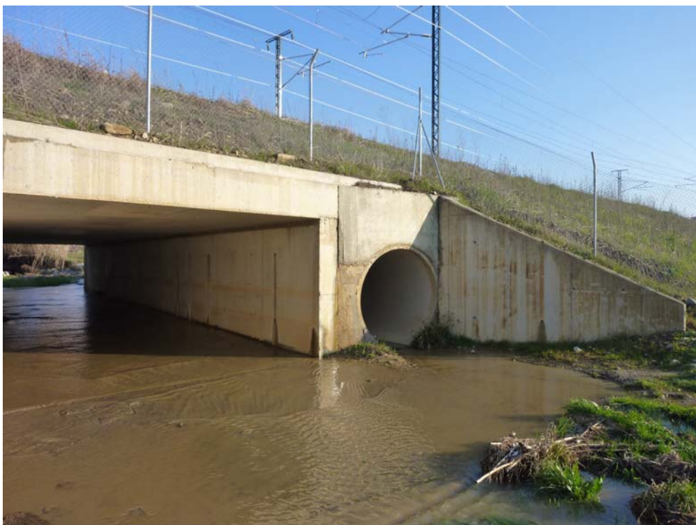
Fotografía 25: estribo de salida
