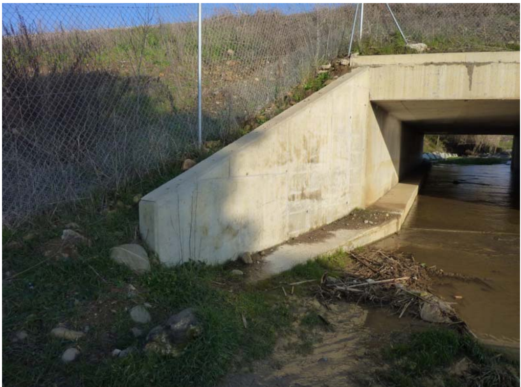
Fotografía 24: Estribo de entrada
