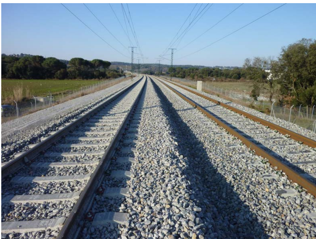
Fotografía 50: Vista desde E2 hacia E1
