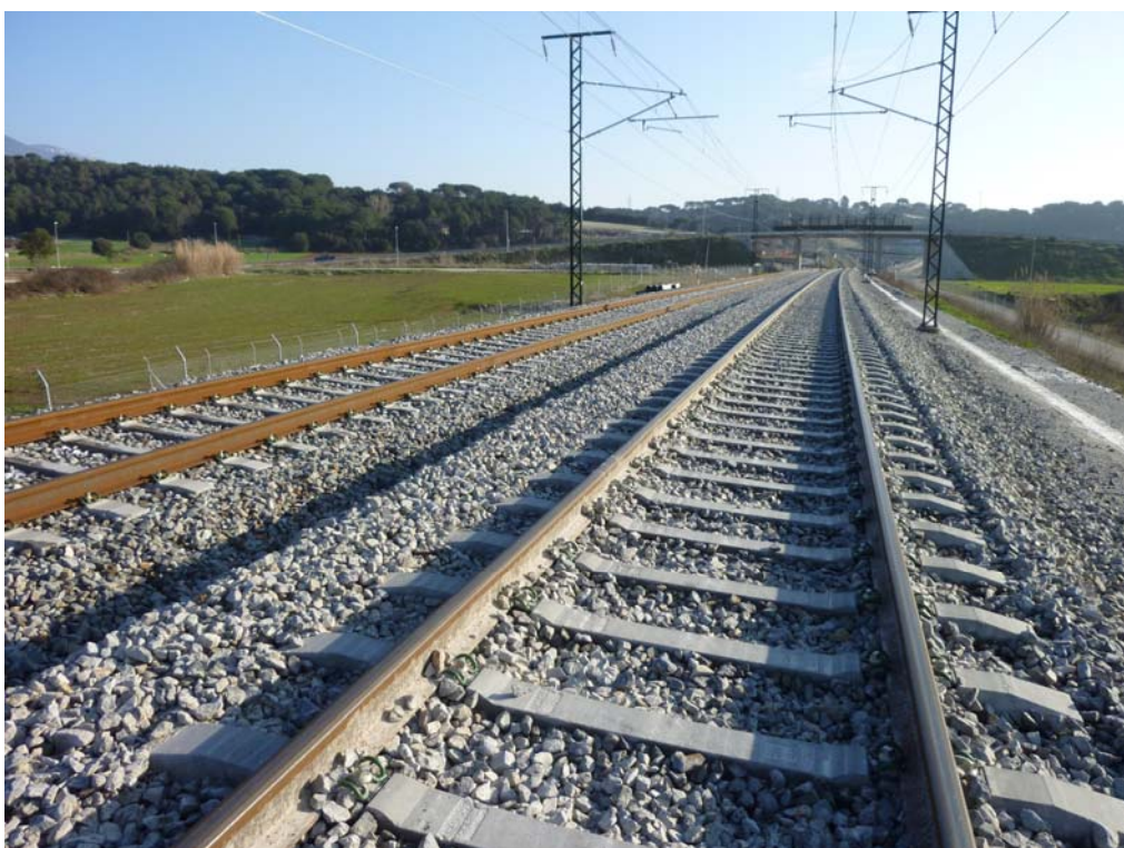
Fotografía 49: Material de vía
