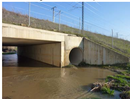
Fotografía nº 6. Estribo de salida
