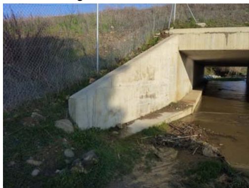
Fotografía nº 5. Estribo de entrada
