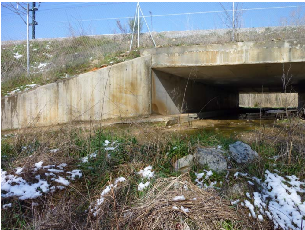
Fotografía 95: Estribo de entrada
