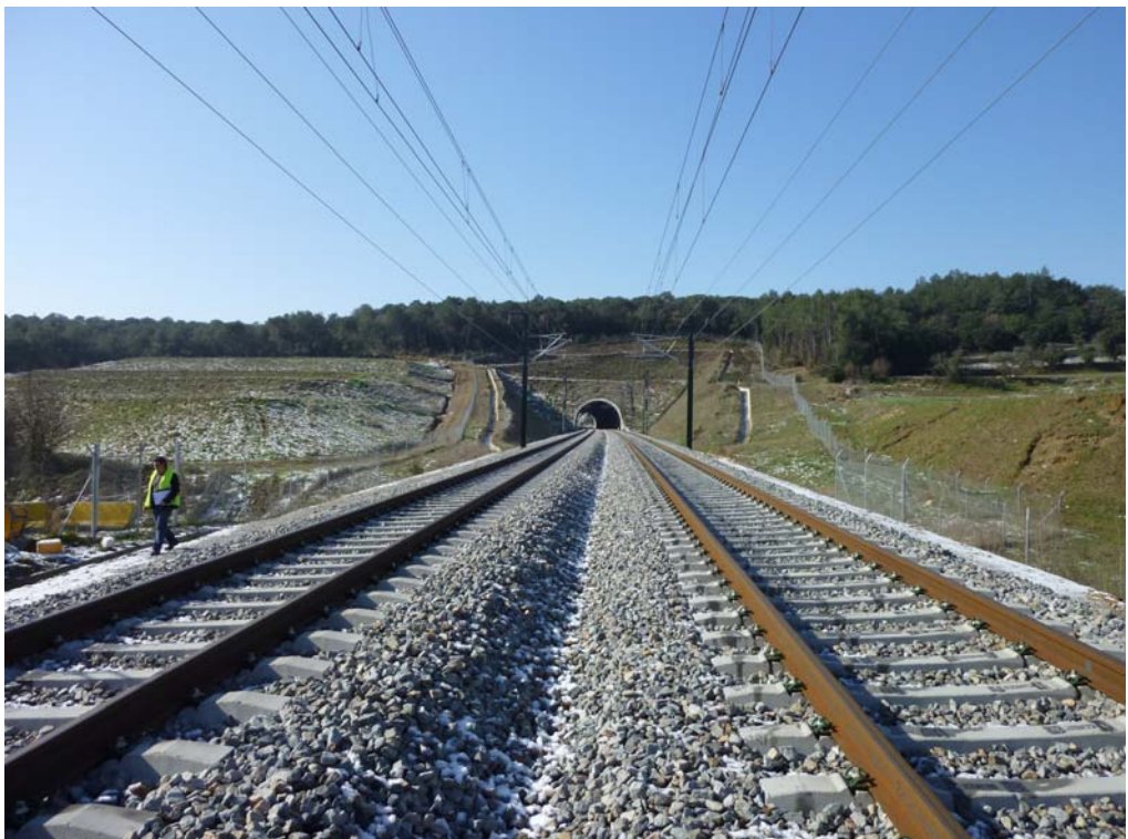
Fotografía 111: Vista desde E2
