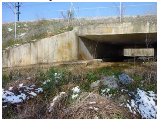
Fotografía nº 5. Estribo de entrada
