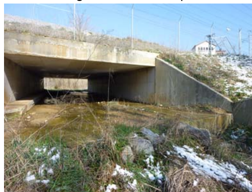
Fotografía nº 6. Estribo de salida
