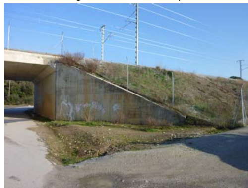
Fotografía nº 6. Estribo de salida
