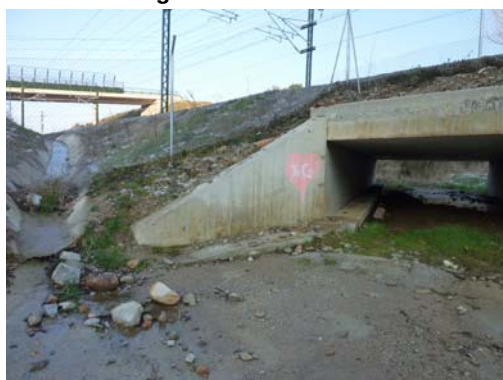
Fotografía nº 5. Estribo de entrada
