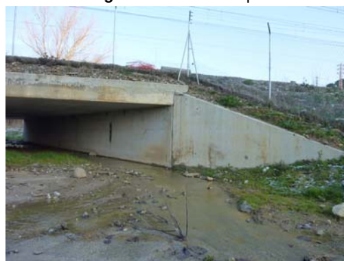
Fotografía nº 6. Estribo de salida
