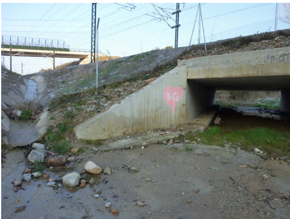
Fotografía 2: Estribo de entrada
