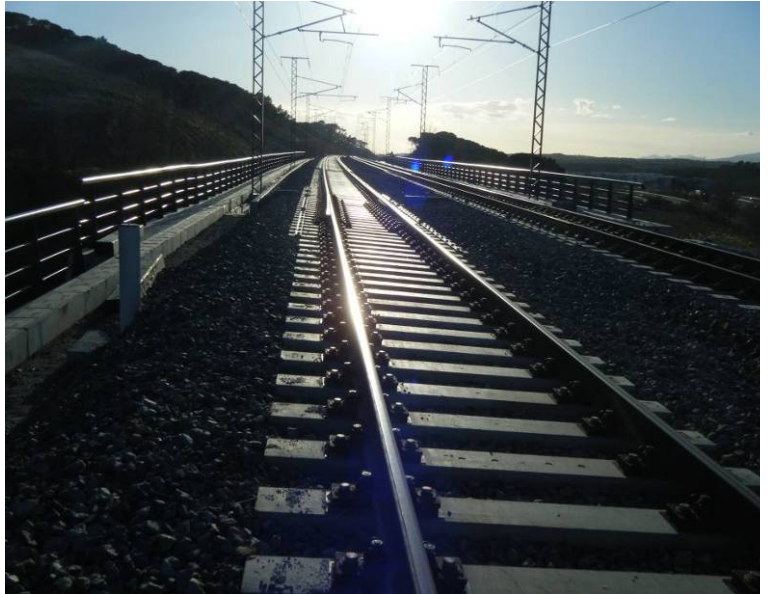
Fotografía Nº7: Vista desde el estribo 2.
