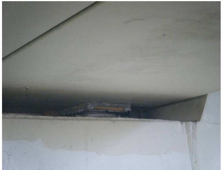
Fotografía N°13: Detalle del apoyo en el estribo 1.
