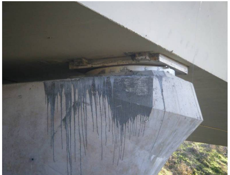
Fotografía N°14: Detalle del apoyo en la pila 2.
