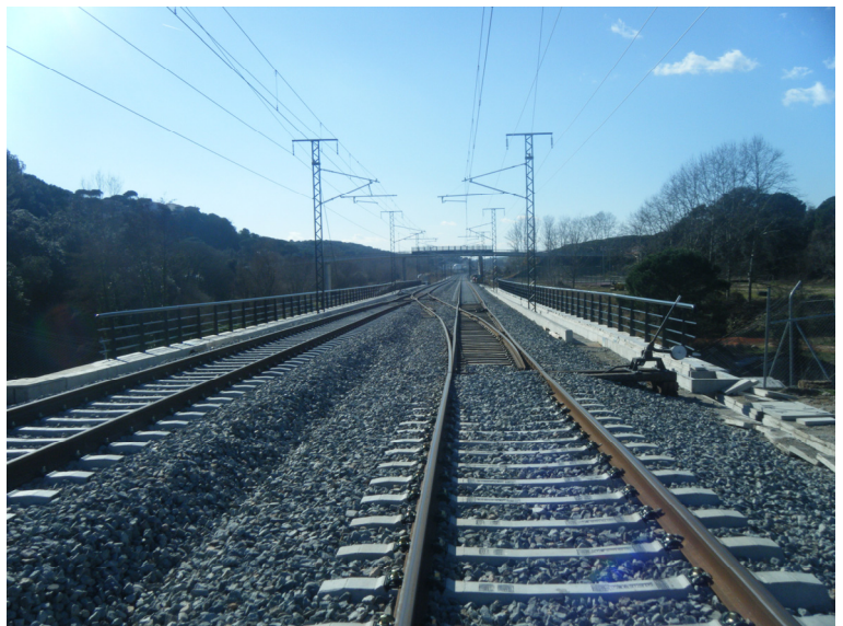
Fotografía N°2: Vista superior del tablero dirección Barcelona.
