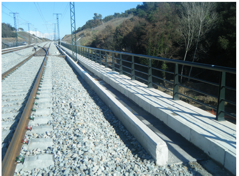
Fotografía N°8: Vista del lado derecho de la plataforma.
