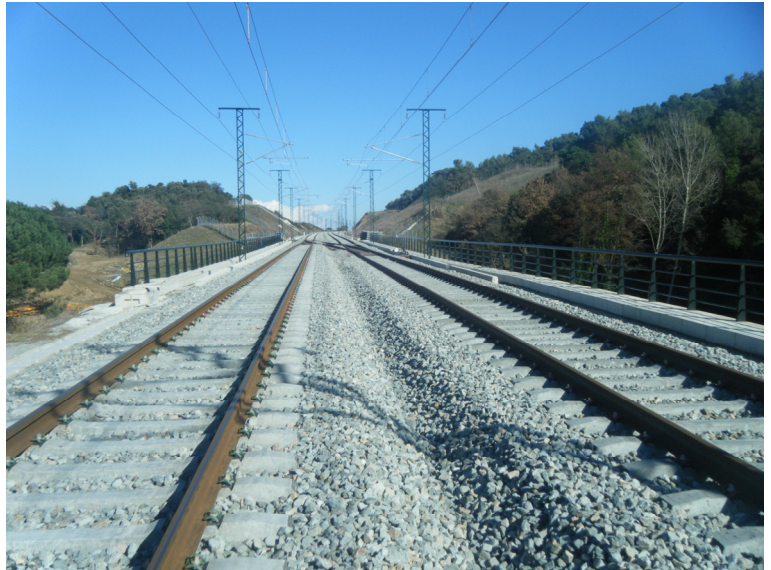
Fotografía N°1: Vista superior del tablero dirección Riudellots.
