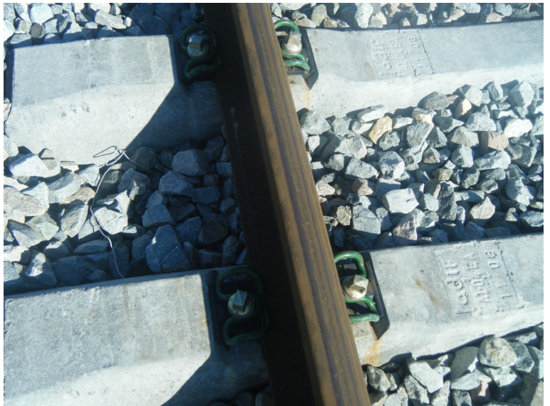
Fotografía N°7: Detalle de sujeción del carril.
