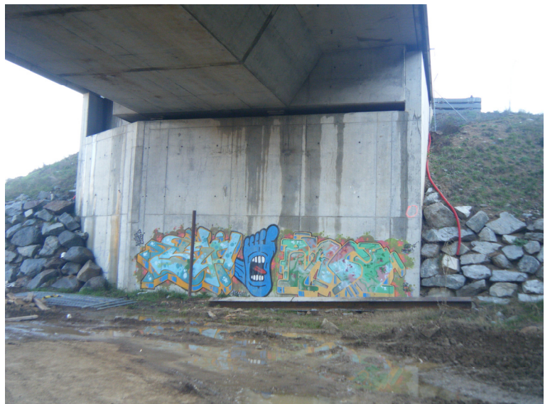
Fotografía N°11: Vista del estribo de salida.
