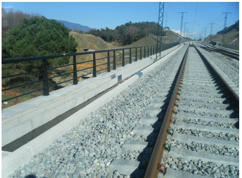
Fotografía N°9: Vista del lado izquierdo de la plataforma.
