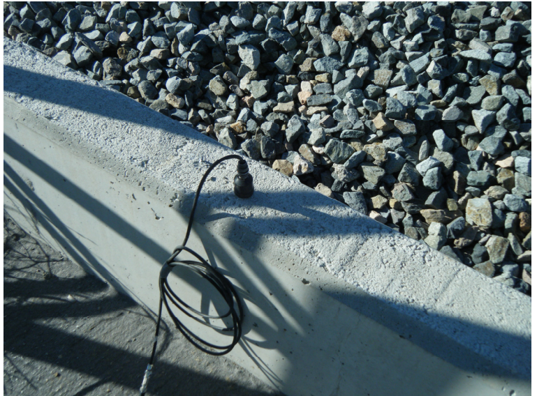
Fotografía N°10: Acelerómetro en vano 1.
