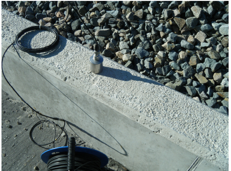
Fotografía N°11: Acelerómetro en vano 2.
