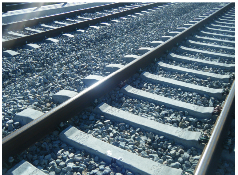
Fotografía N°6: Vista del material de vía.
