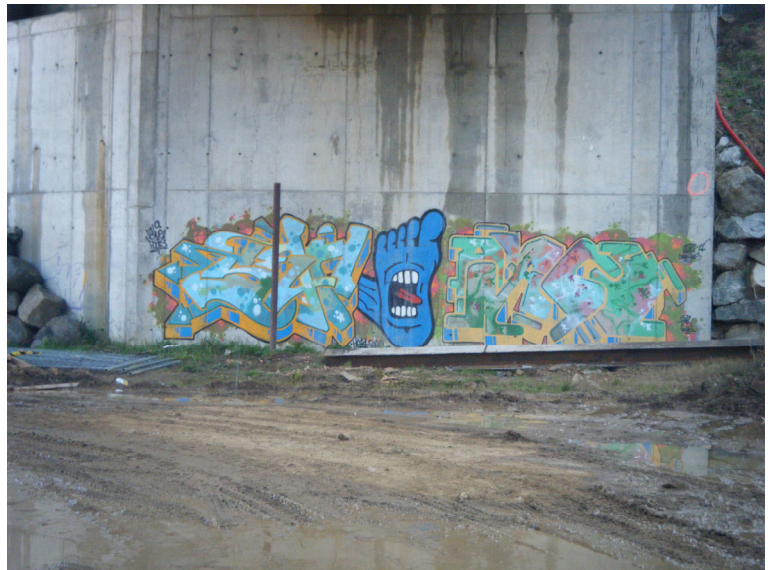
Fotografía N°13: Pintadas en el estribo 2.
