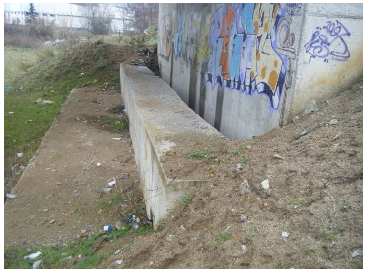
Fotografía N°15: Protección del hormigón
