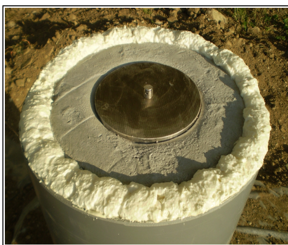
Tubo exterior de PVC de 400 milímetros de diámetro separados del central por medio de poliuretano expandido
