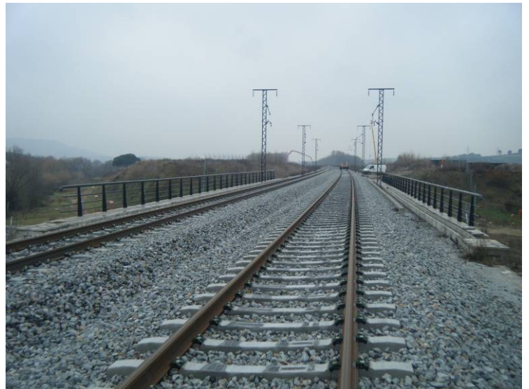
Fotografía N°7: Vista superior del tablero dirección Barcelona
