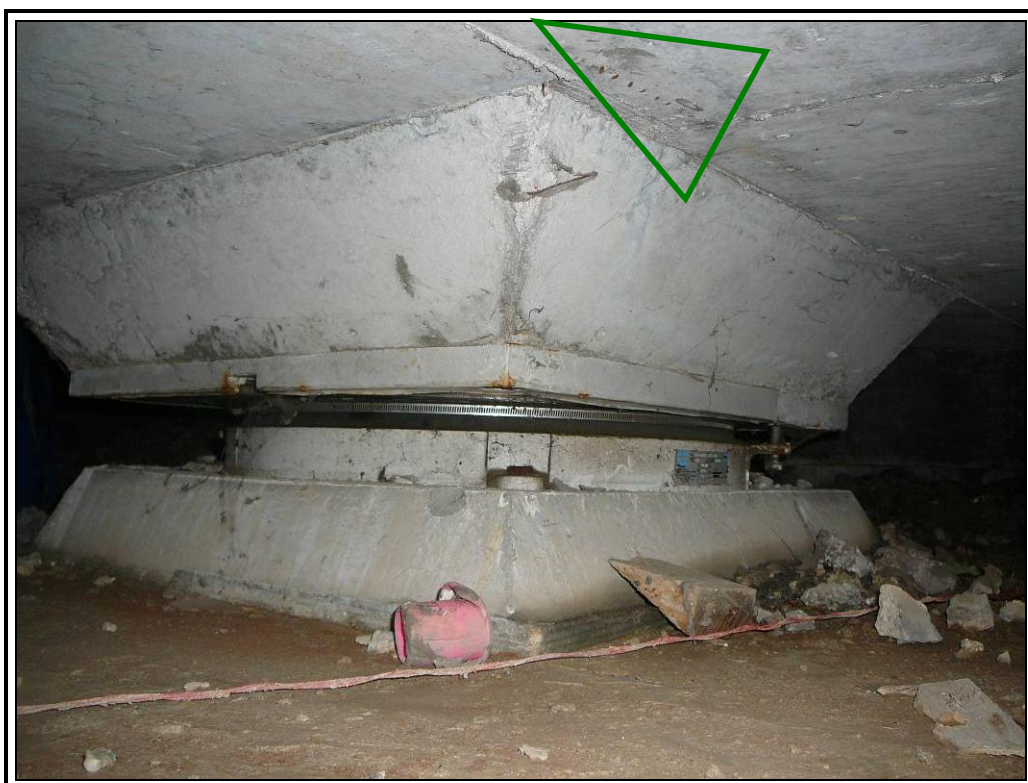
Fisura de retracción en hastial dos
