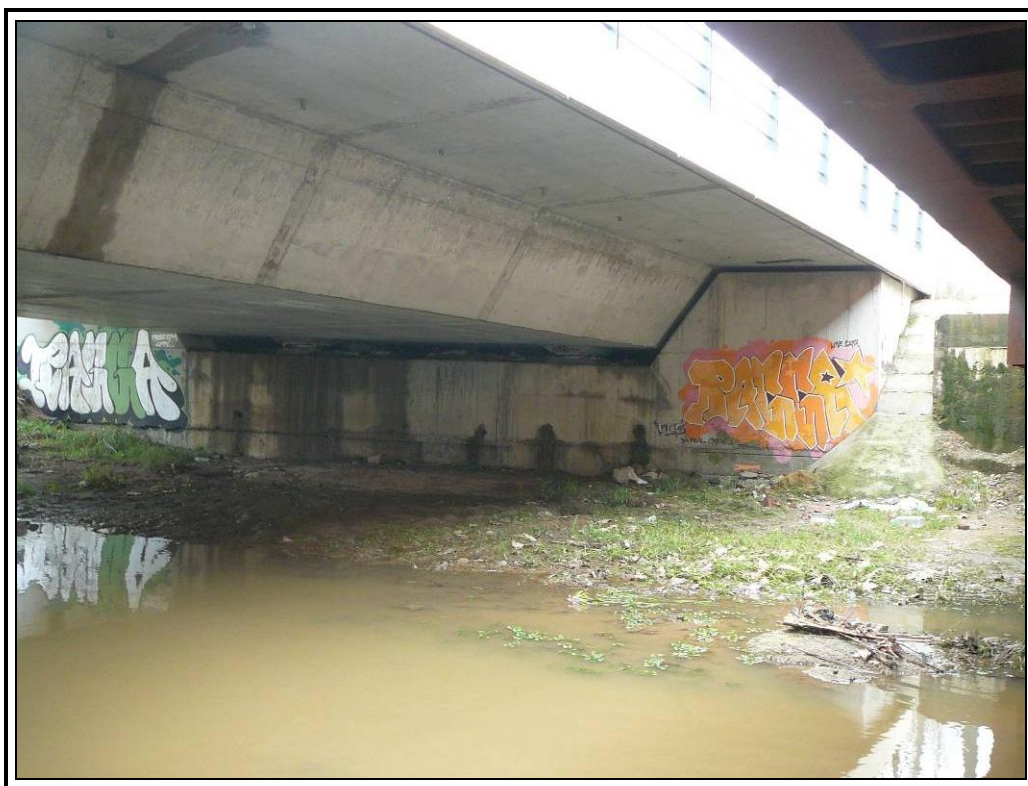
Estribo de entrada
