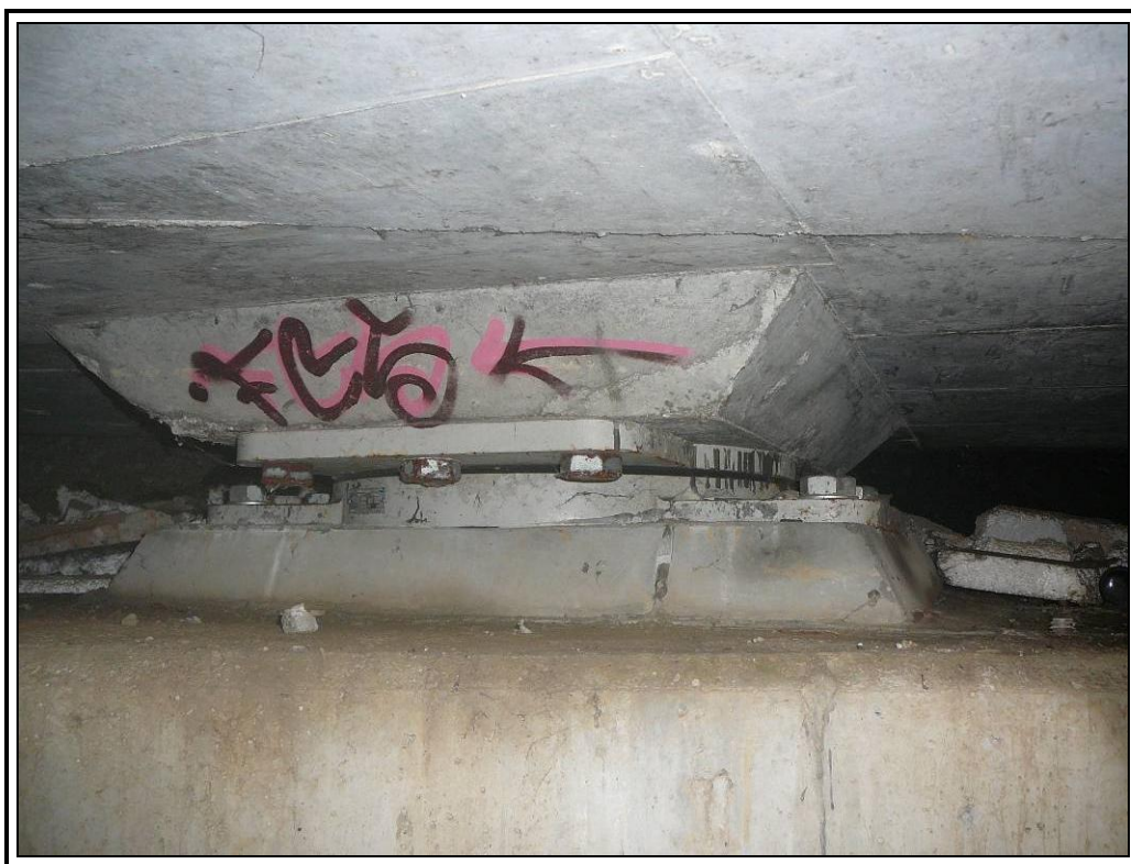
Apoyo izquierdo de estribo uno
