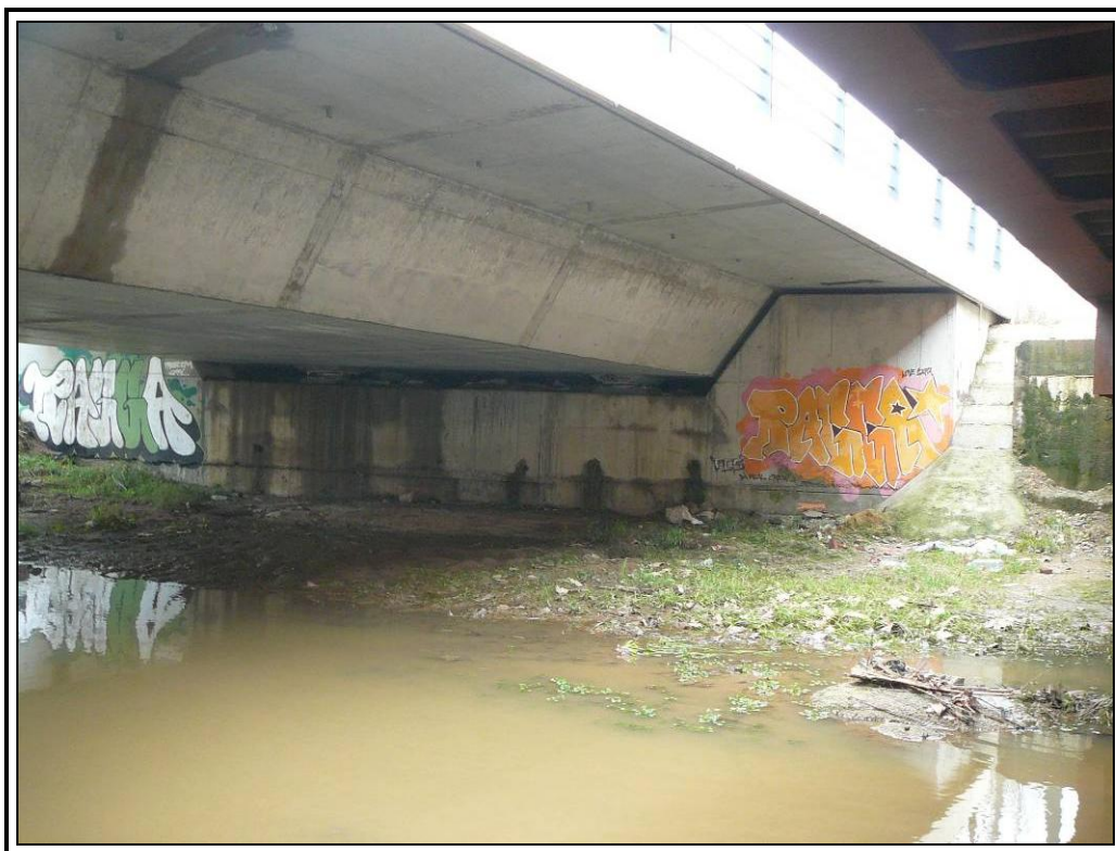
Estribo de entrada
