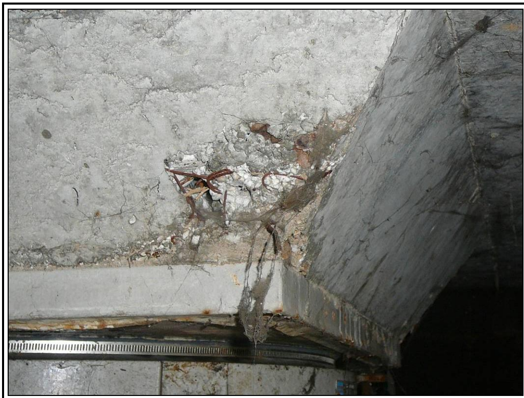
Fisura de retracción en hastial dos
