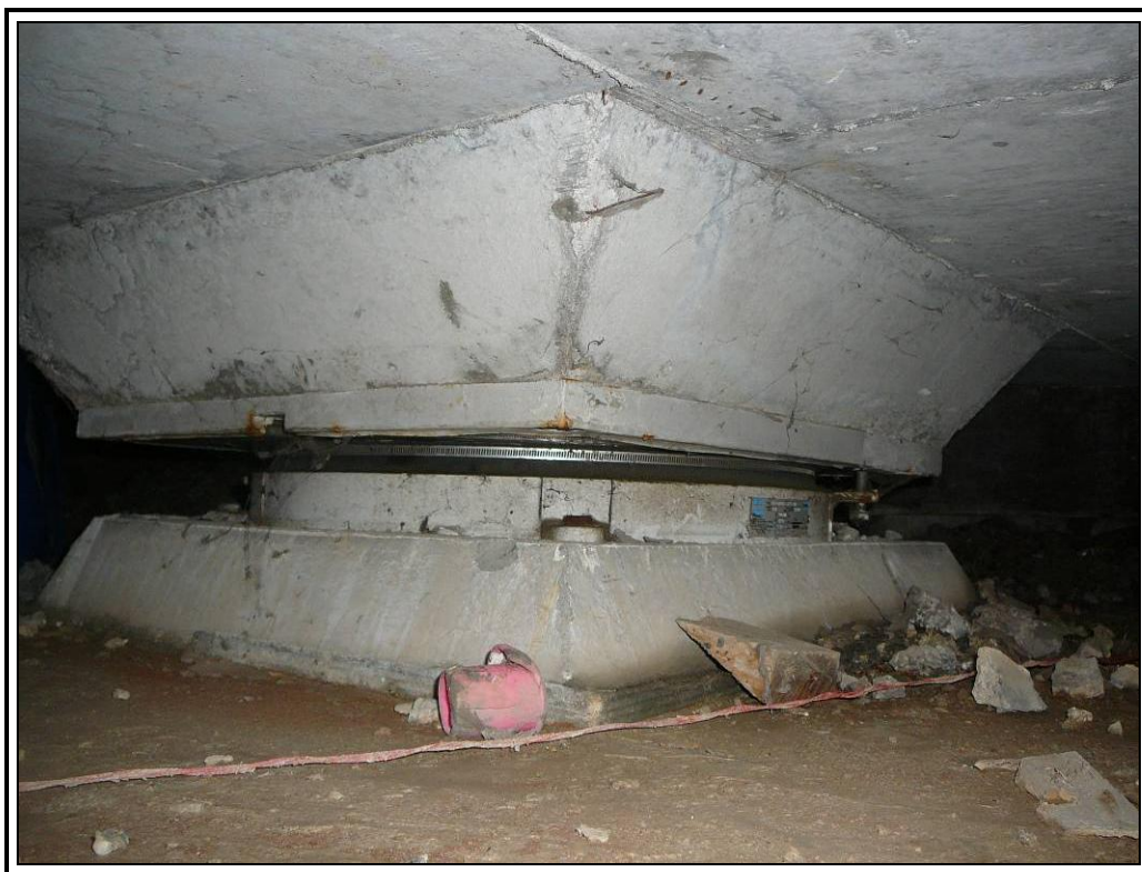
Apoyo derecho de estribo 2
