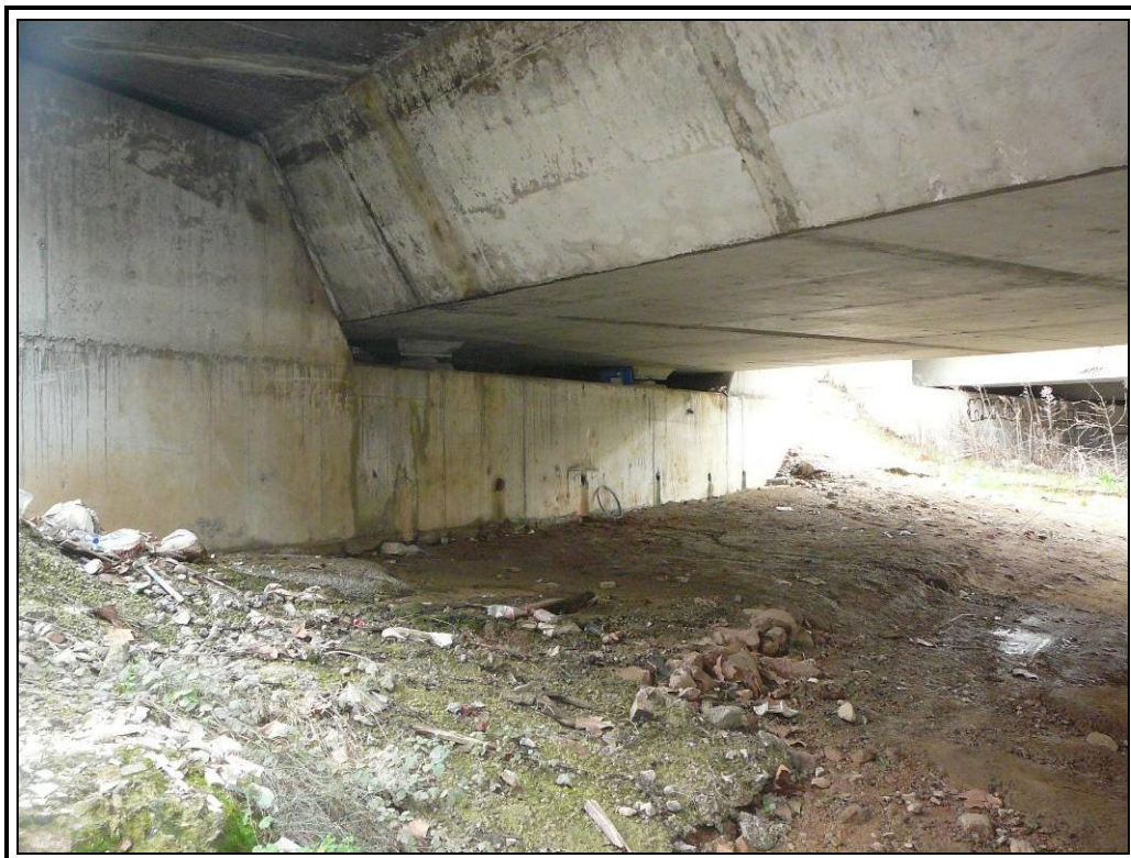
Muro lateral izquierdo
