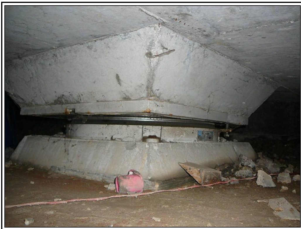
Apoyo derecho de estribo 2
