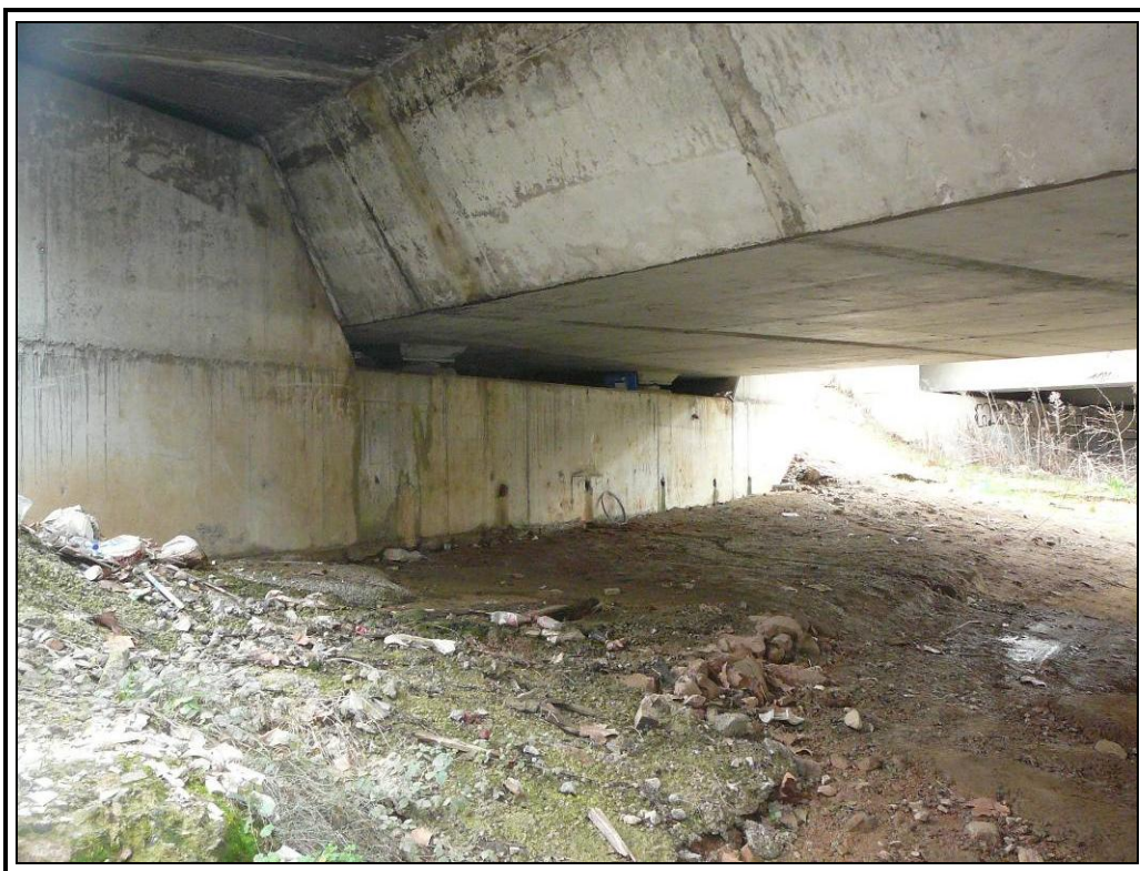
Muro lateral izquierdo
