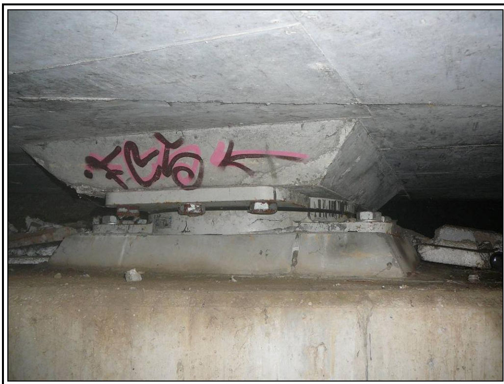
Apoyo izquierdo de estribo uno
