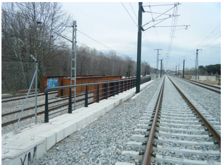
Fotografía N°9: Vista del lado izquierdo de la plataforma.
