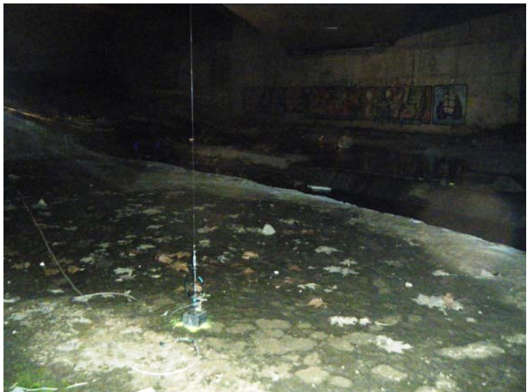
Fotografía N°5: Anillos dispuestos en centro de vano.
