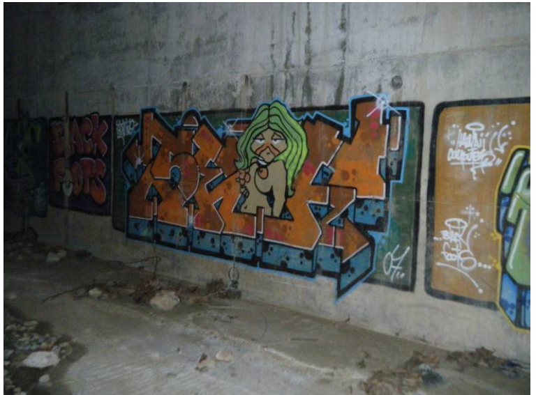
Fotografía N°4: Anillo dispuesto en el estribo 2.
