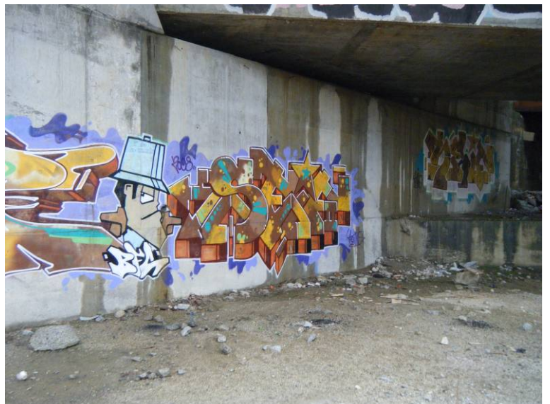
Fotografía N°15: Humedades en el estribo de entrada.
