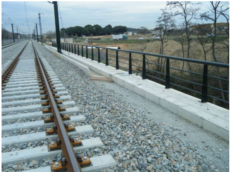
Fotografía N°8: Vista del lado derecho de la plataforma.
