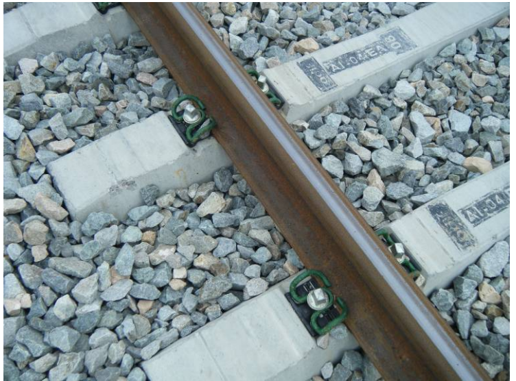
Fotografía N°7: Detalle de sujeción del carril.
