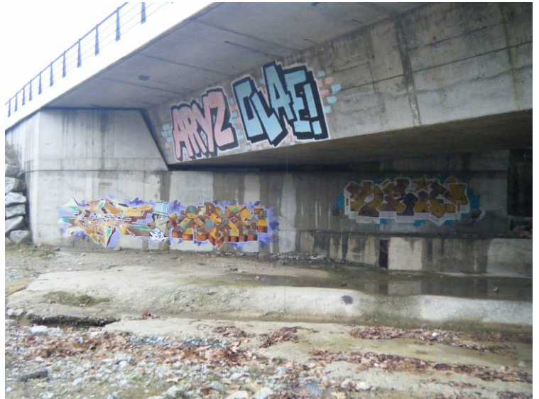
Fotografía N°10: Vista del estribo de entrada.
