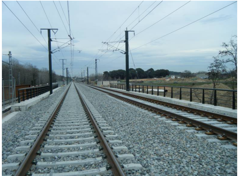
Fotografía Nº1: Vista superior del tablero dirección Girona.
