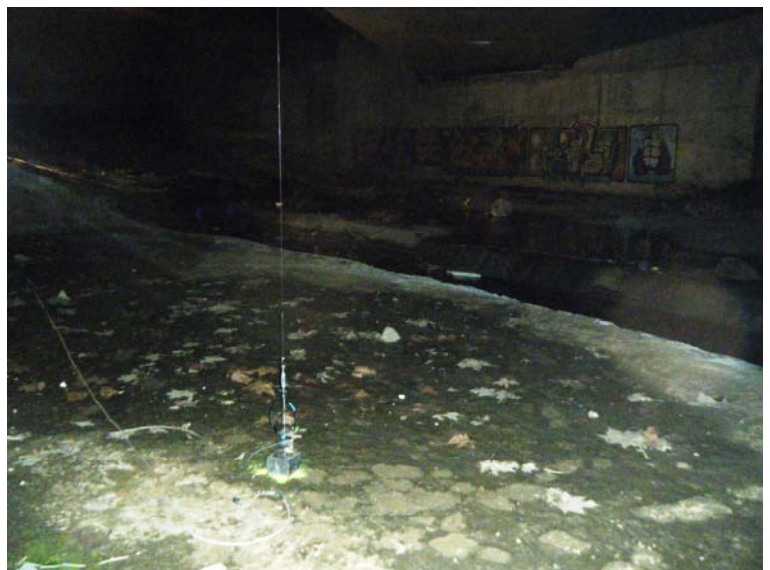
Fotografía N°5: Anillos dispuestos en centro de vano.
