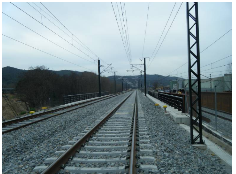
Fotografía Nº2: Vista superior del tablero dirección Barcelona.
