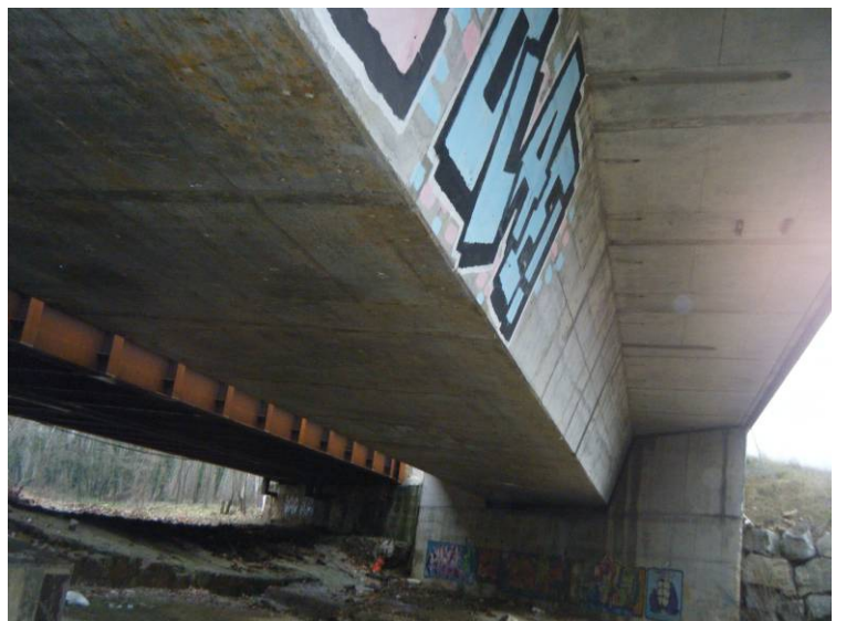
Fotografía Nº3: Vista inferior del tablero.
