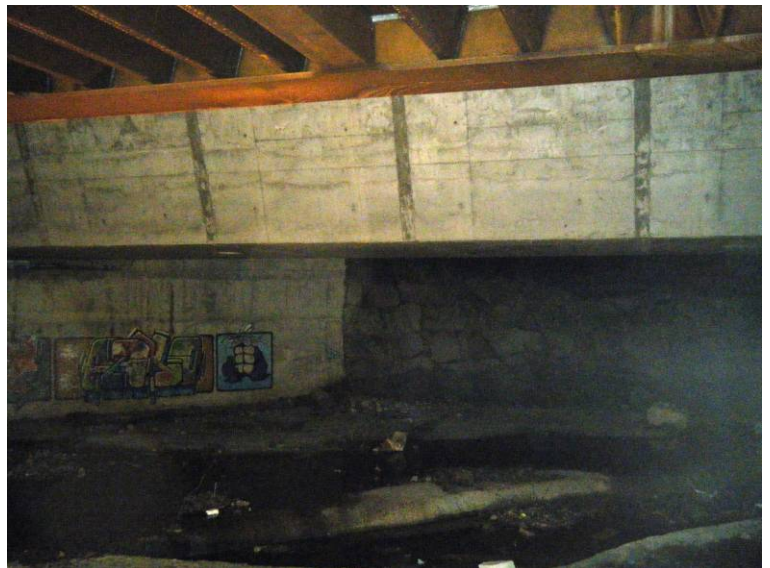
Fotografía N°14: Vista general de la estructu- ra.
