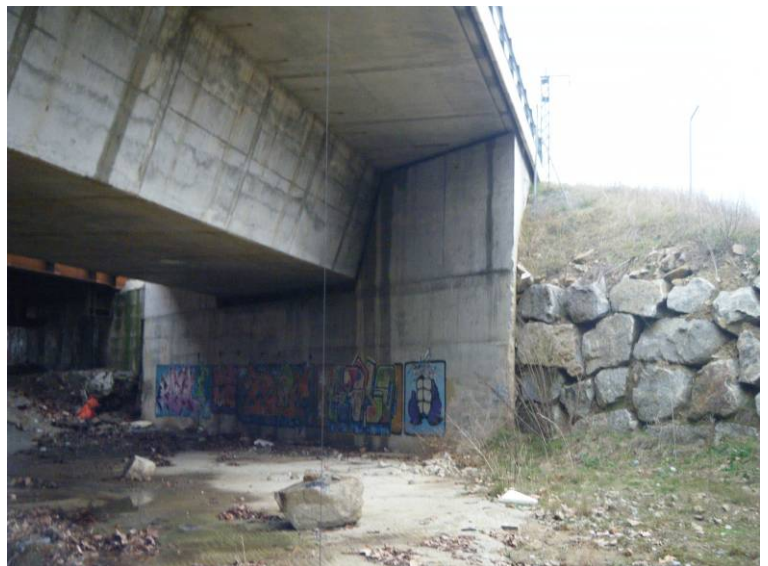
Fotografía N°11: Vista del estribo de salida.
