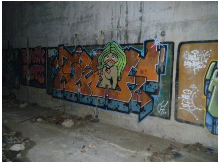
Fotografía N°4: Anillo dispuesto en el estribo 2.
