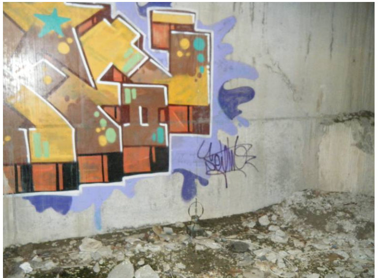
Fotografía N°3: Anillo dispuesto en el estribo 1.
