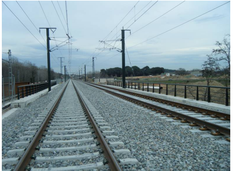
Fotografía Nº1: Vista superior del tablero dirección Girona.
