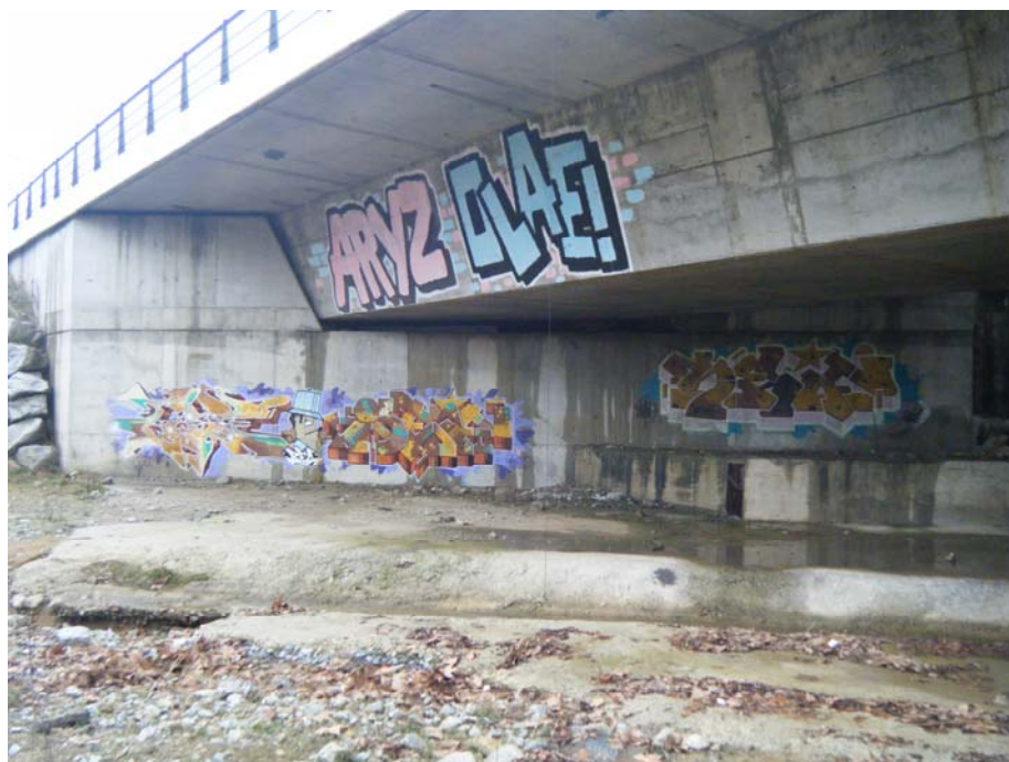
FOTOGRAFIA N° 10: Vista del estribo de entrada
