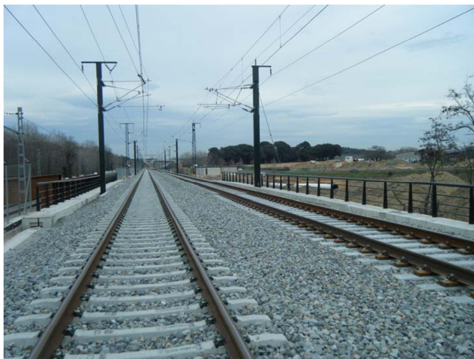
FOTOGRAFIA N° 1: Vista Superior del tablero dirección Girona
