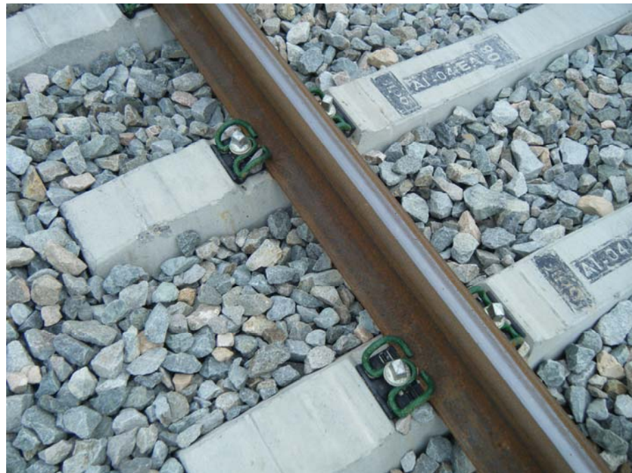
FOTOGRAFIA N° 7: Detalle de sujeción del carril
