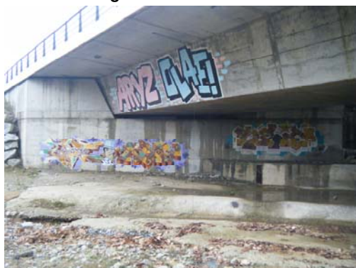
Fotografía nº 5. Estribo de entrada
