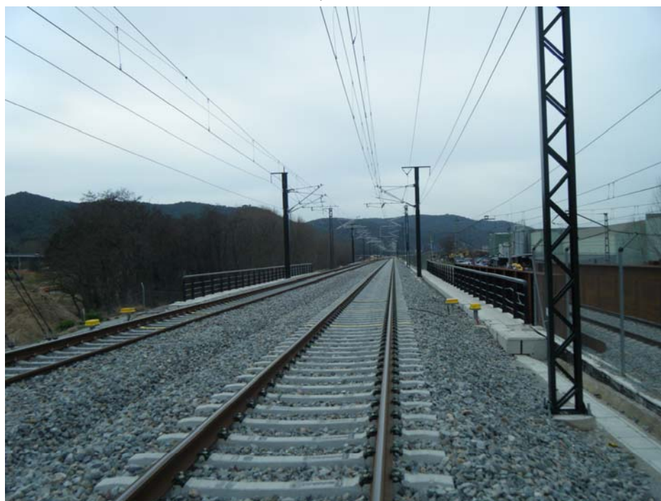
FOTOGRAFIA N° 2: Vista superior del tablero dirección Barcelona
