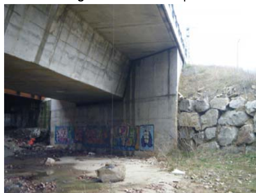
Fotografía nº 6. Estribo de salida
