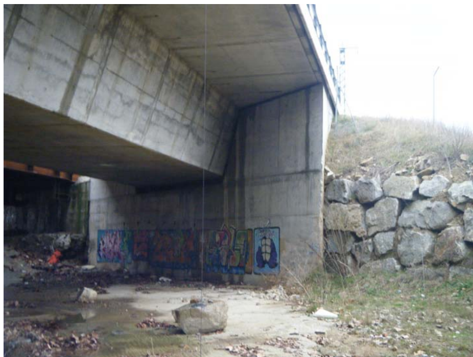
FOTOGRAFIA N° 11: Vista del estribo de salida
