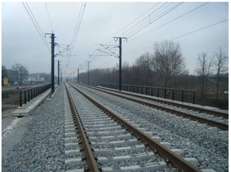
Fotografía N°5: Vista desde el estribo 1
