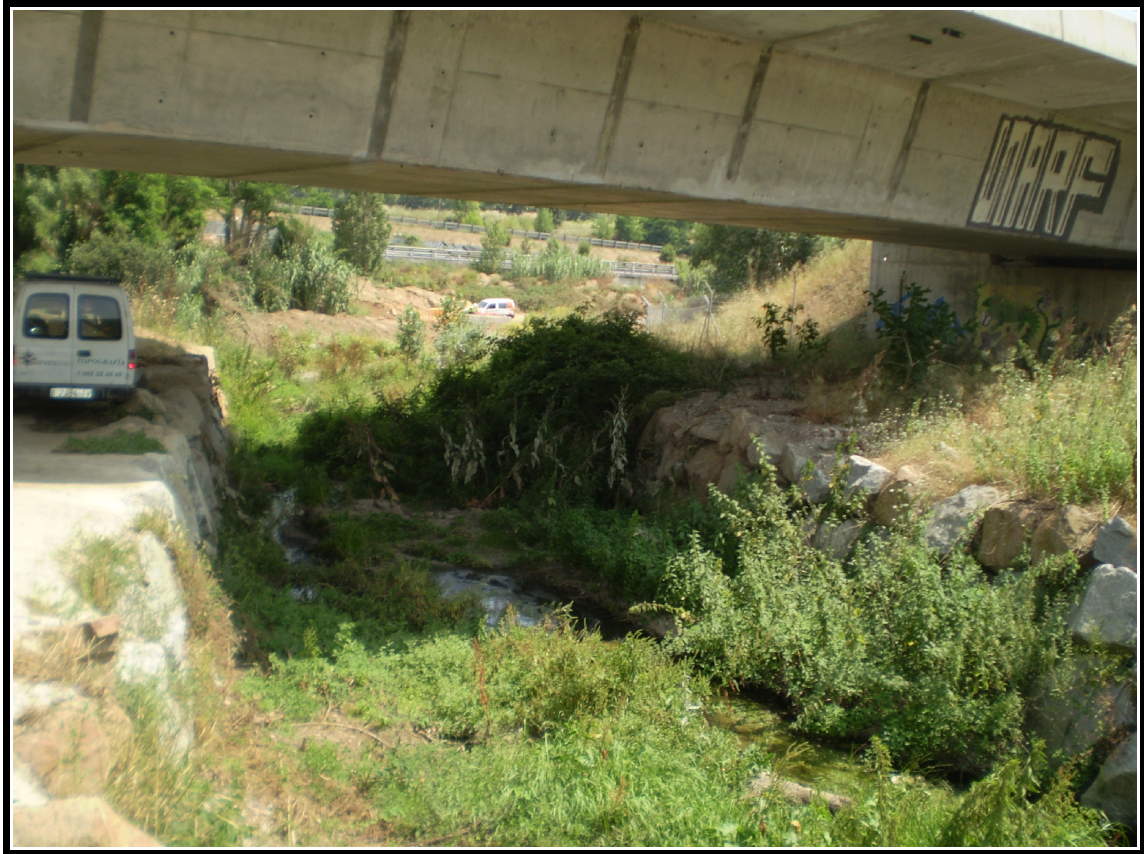
Vista desde lado vía 2
