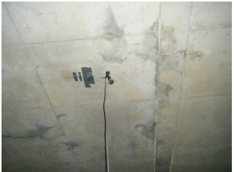
Fotografía N°9: Banda extensométrica en el centro de vano
