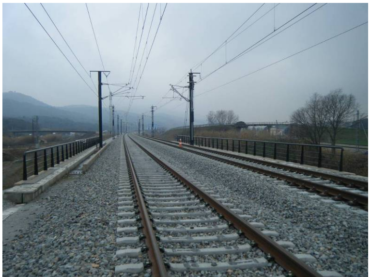
Fotografía N°6: Vista desde el estribo 2
