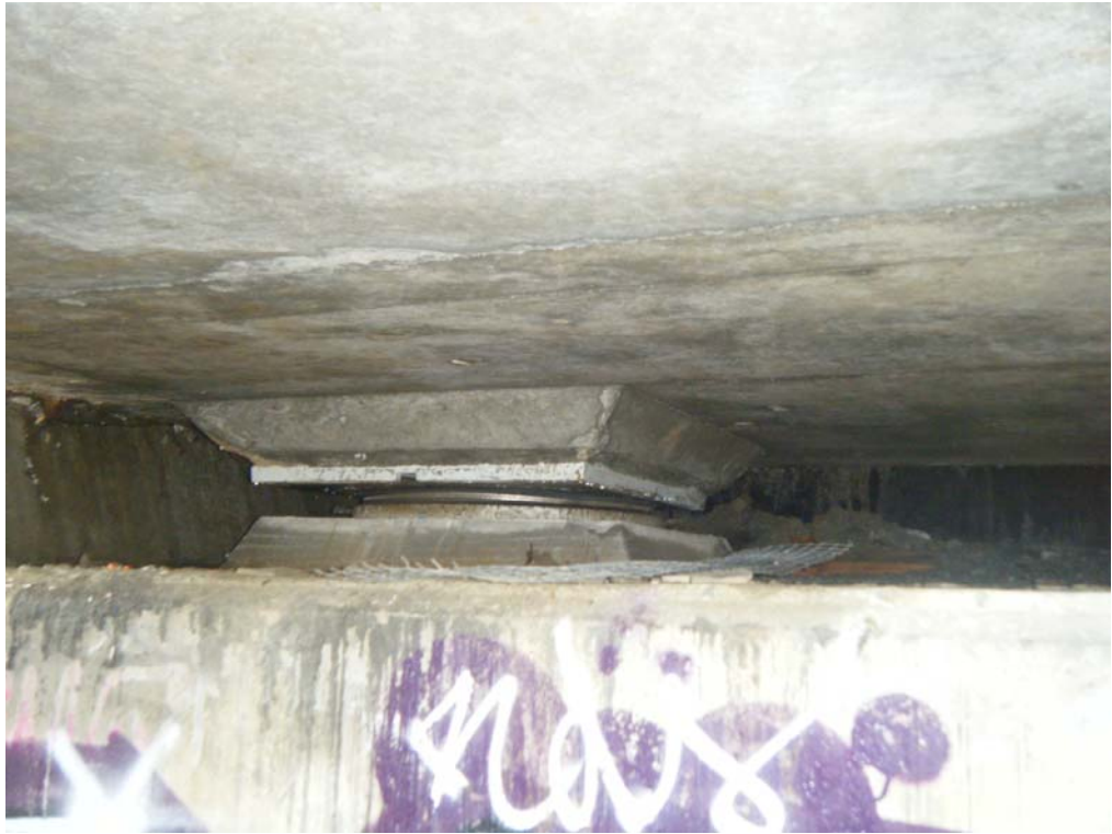
Fotografía n° 7: detalle de apoyo
