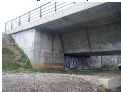
Fotografía nº 6. Estribo de salida
