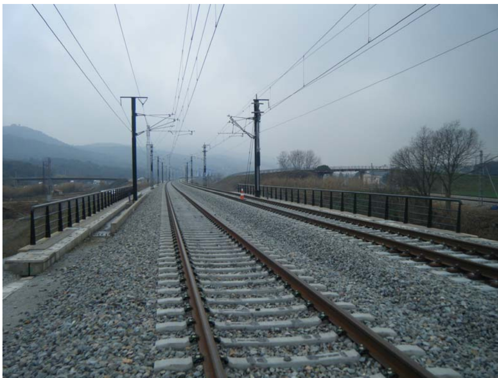
Fotografía n° 23: Vista superior desde el estribo de salida
