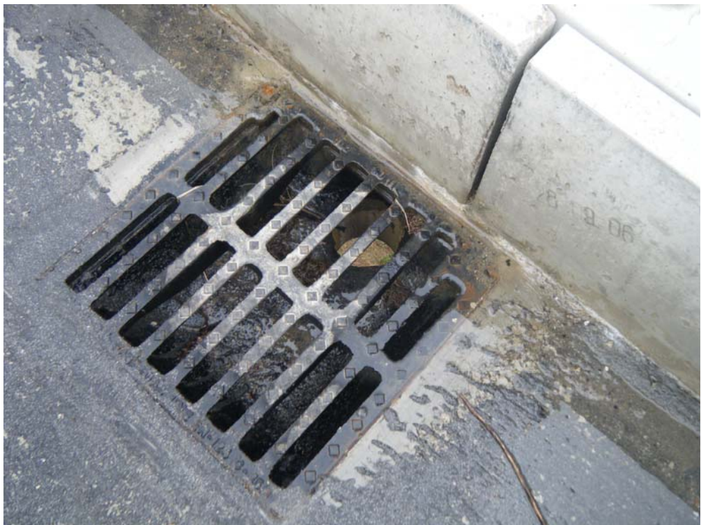
Fotografía n° 22: Detalle de rejilla de imbornal
