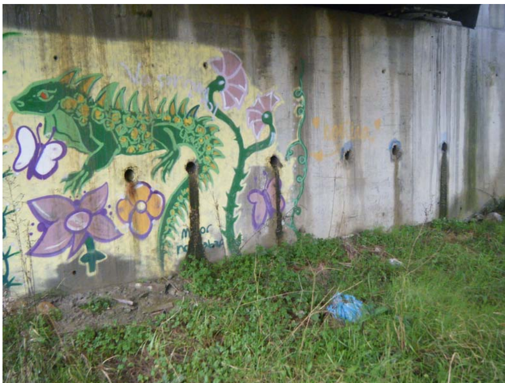
Fotografía n° 25: Drenaje en muro de frente del estribo de entrada
