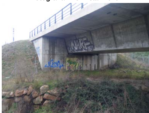
Fotografía nº 5. Estribo de entrada
