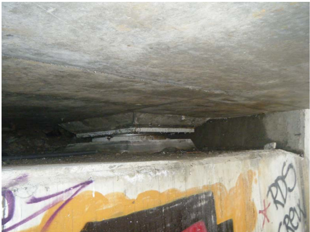
Fotografía n° 8: detalle apoyo (I)
