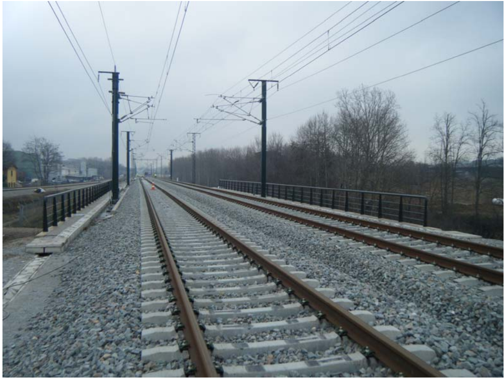
Fotografía nº 17: Vista desde estribo de entrada
