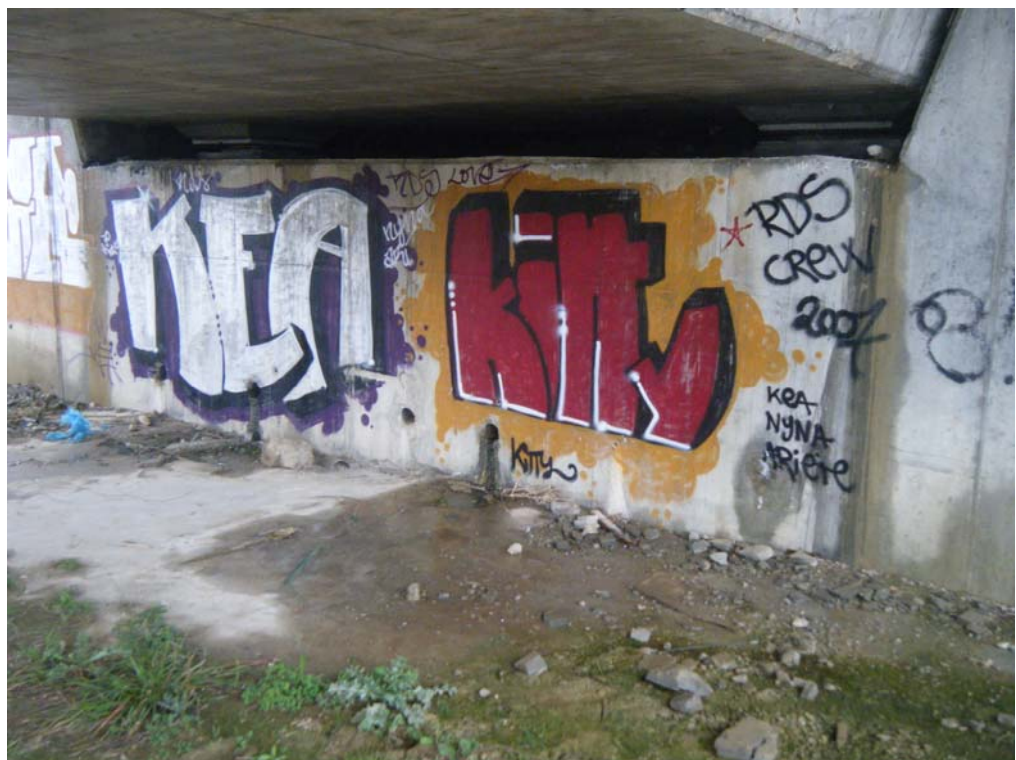
Fotografía nº 10: Humedades en muro de frente. E-2
