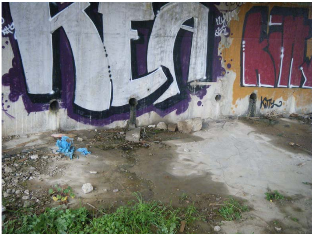
Fotografía n° 12: Drenaje muro de frente E-2
