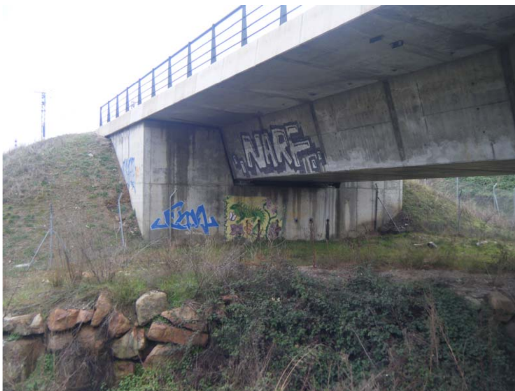
Fotografía n° 3: Estribo de entrada
