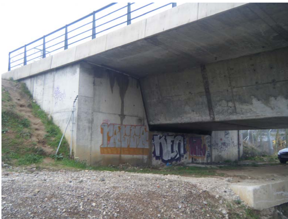
Fotografía n° 4: Estribo de salida
