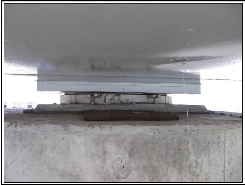
Apoyo izquierdo de pila 4
