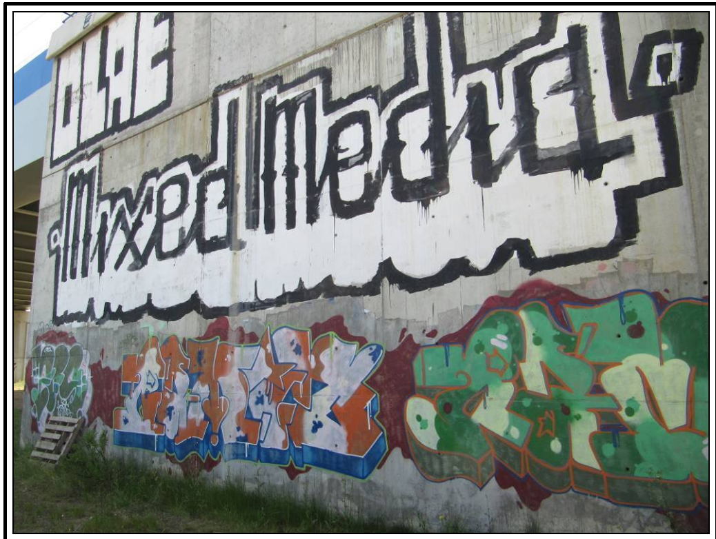
Muro lateral izquierdo
