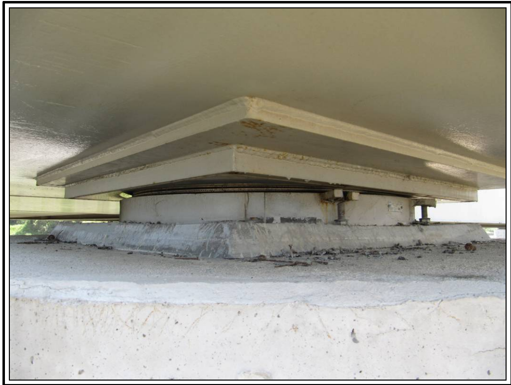
Apoyo izquierdo pila 3
