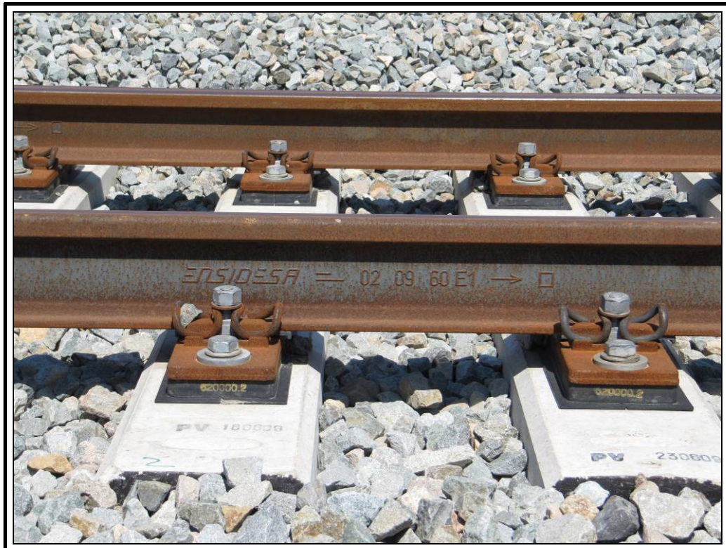
Material de vía
