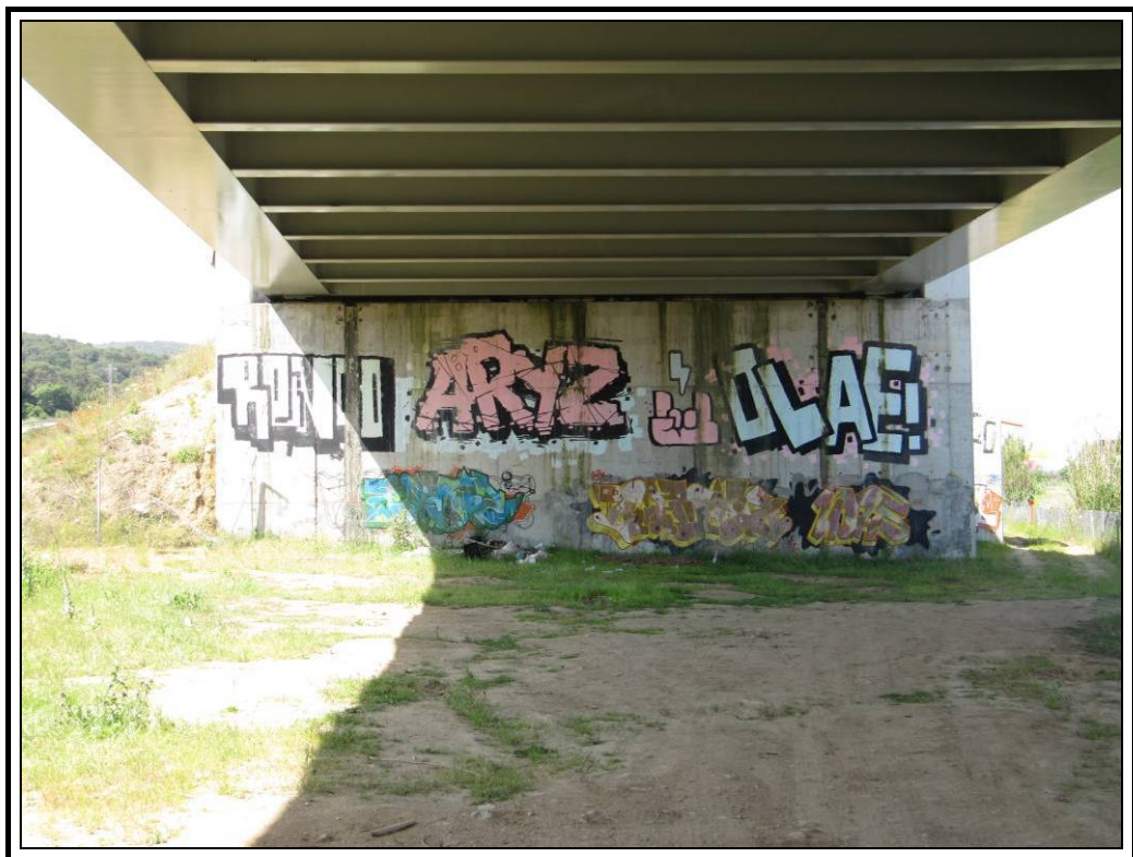
Estribo de entrada
