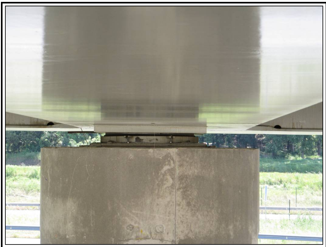
Apoyo derecho de pila 4 (vista lateral)
