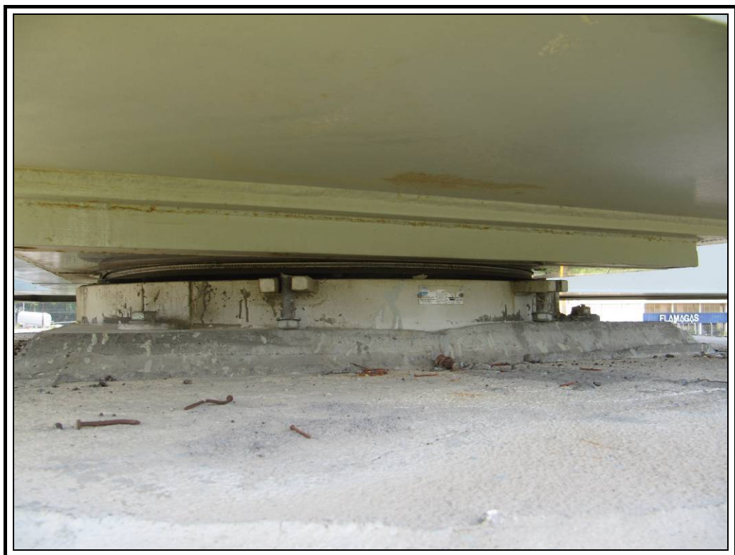
Apoyo derecho pila 2
