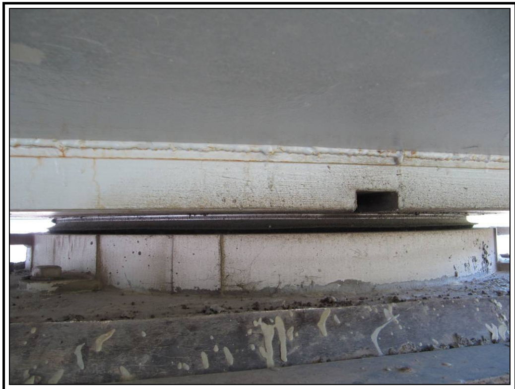
Apoyo derecho pila 1
