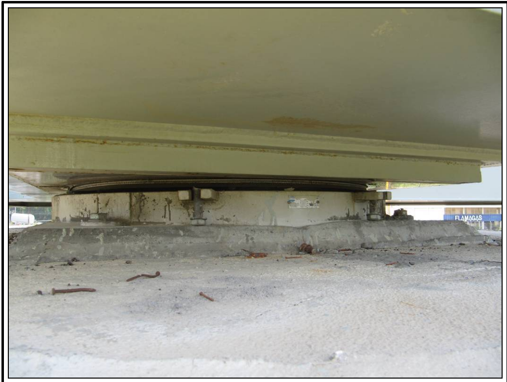
Apoyo derecho pila 2
