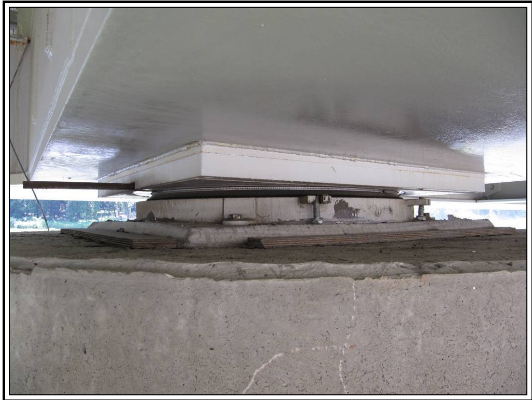
Apoyo derecho de pila 4
