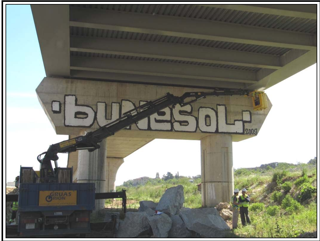
Estribo-Pila de salida (conexión con Vto. AP7 hormigón)
