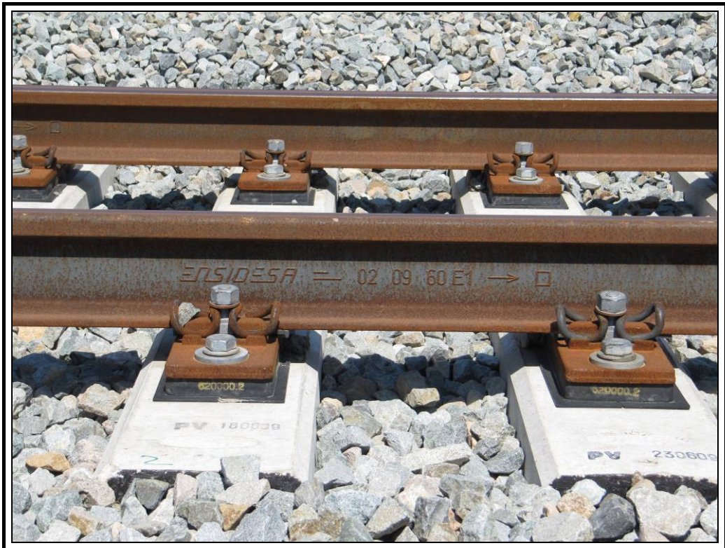
Material de vía
