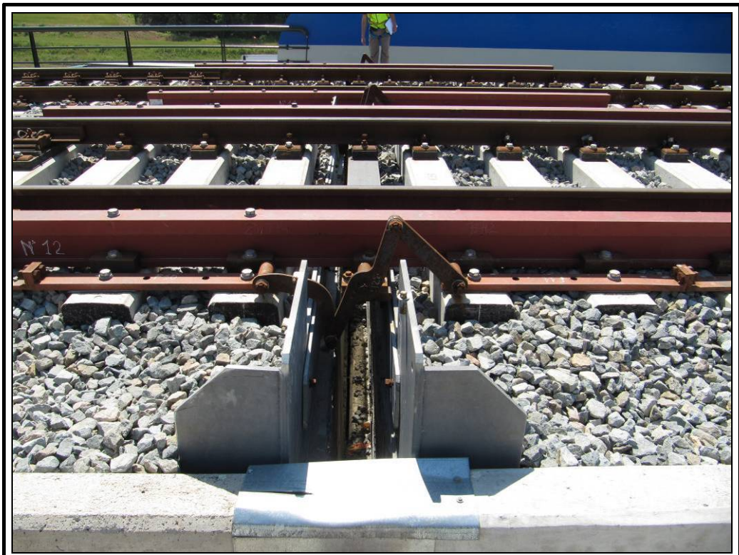
Junta y aparato de dilatación en estribo dos
