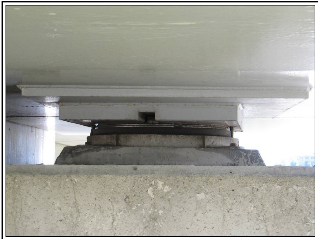
Apoyo derecho de la pila-estribo 2 (conexión con AP7 Hormigón)
