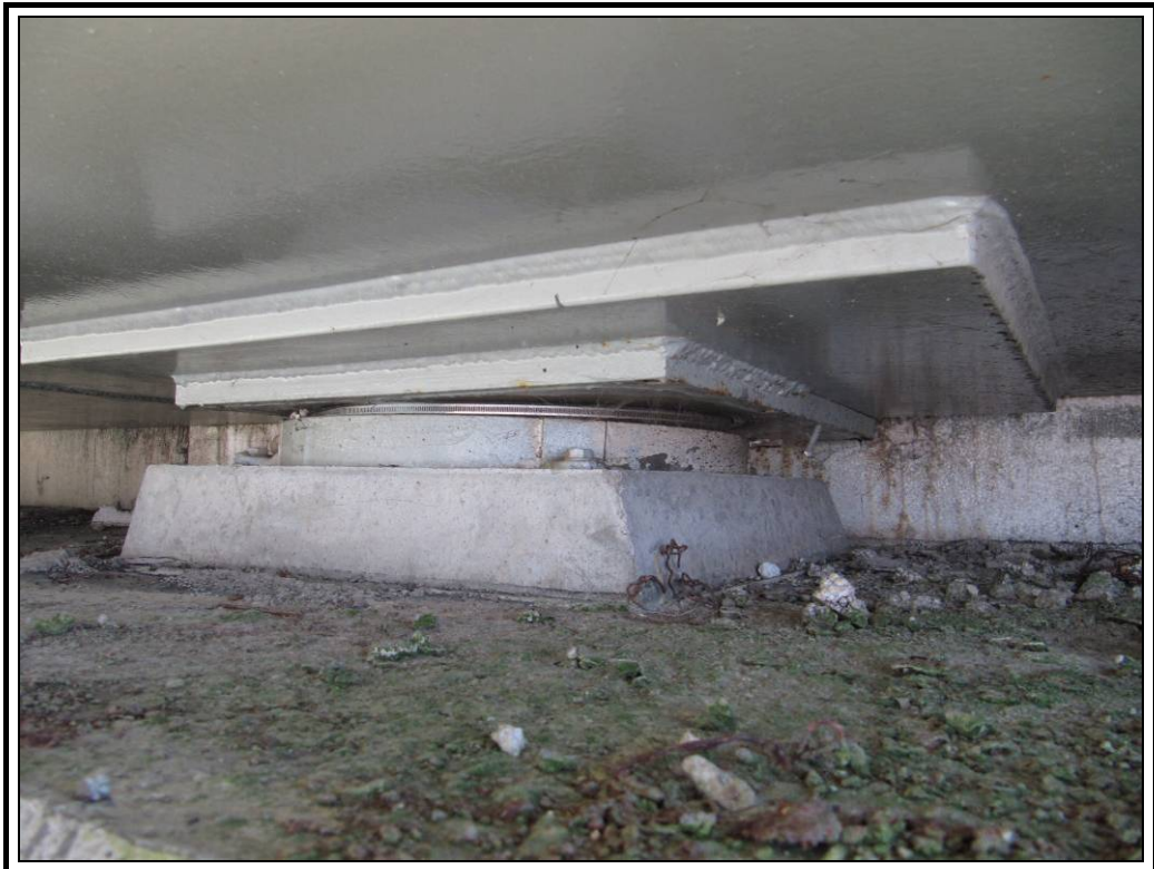
Apoyo izquierdo de estribo uno
