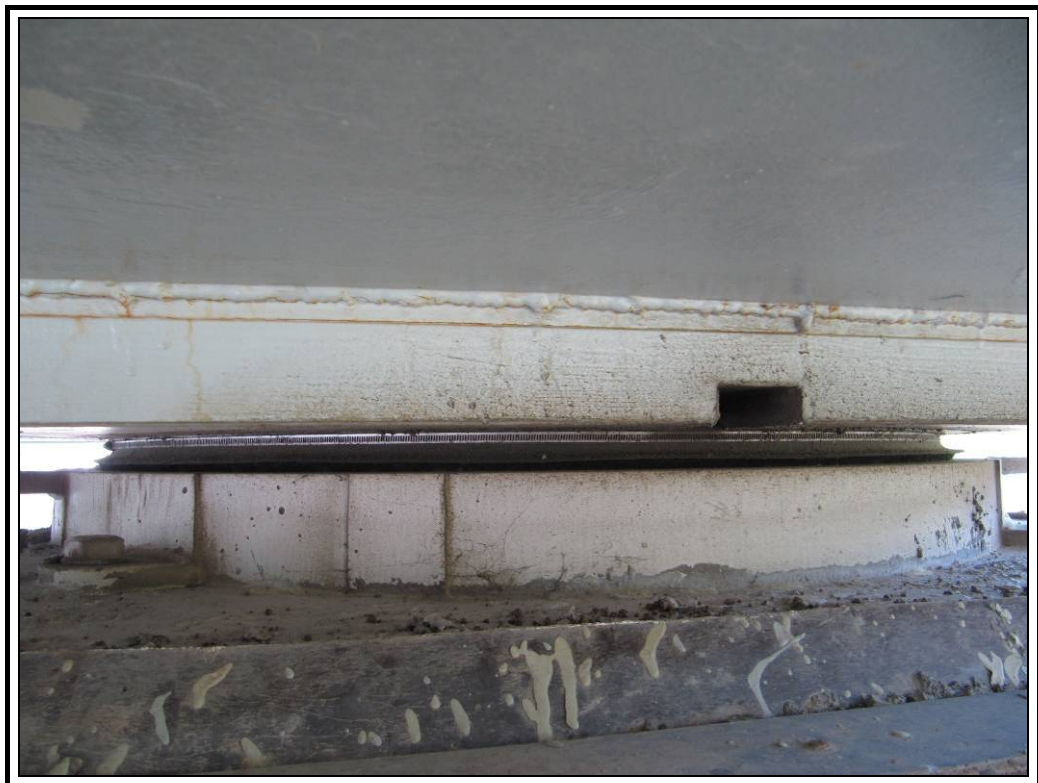
Apoyo derecho pila 1
