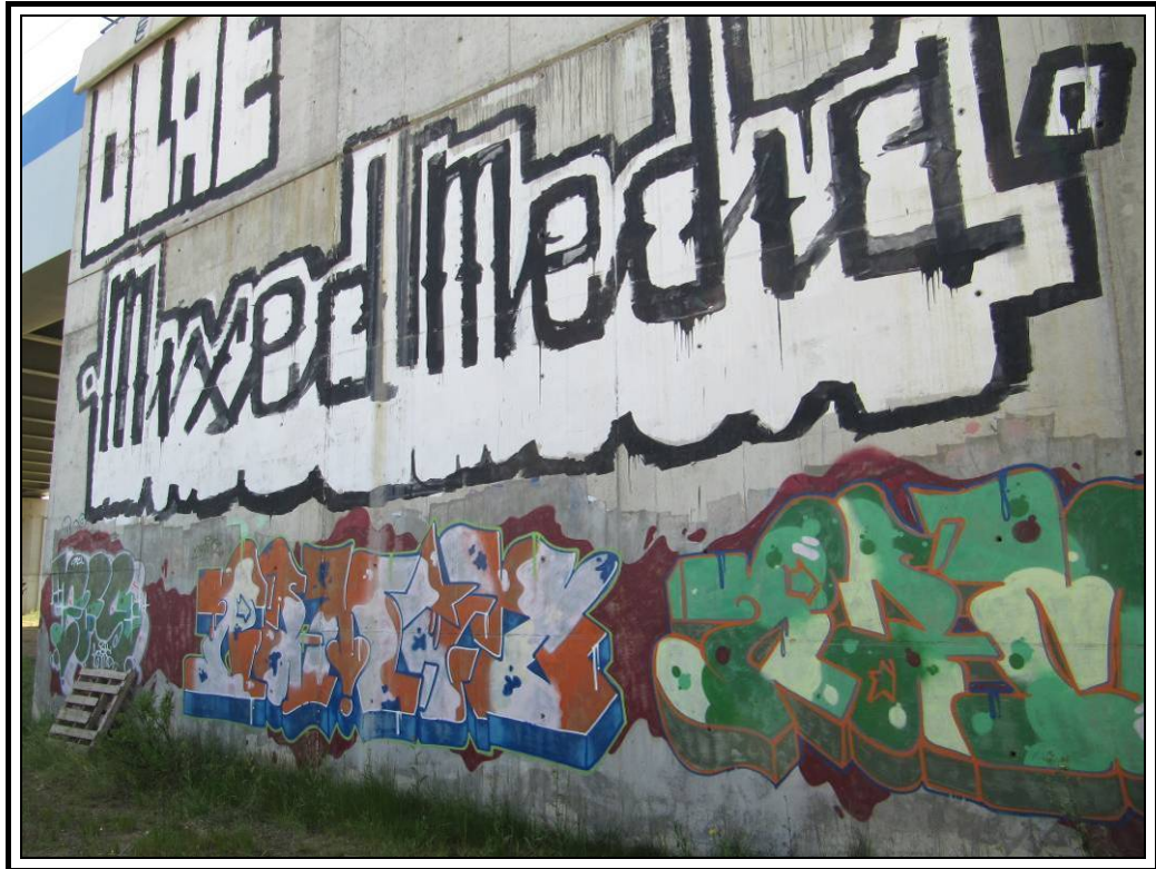
Muro lateral izquierdo
