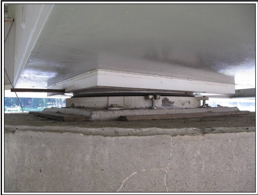
Apoyo derecho de pila 4
