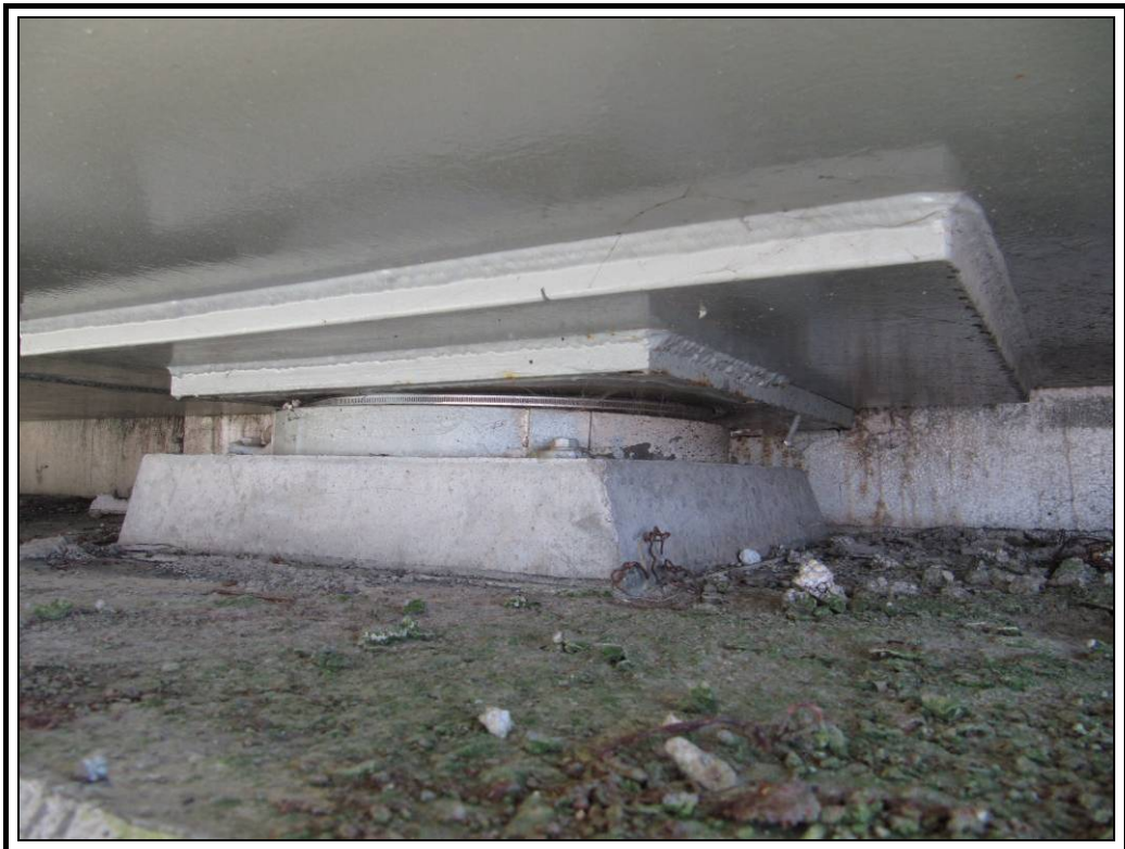
Apoyo izquierdo de estribo uno
