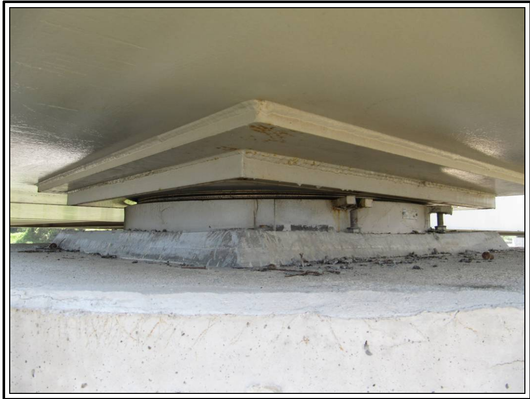
Apoyo izquierdo pila 3
