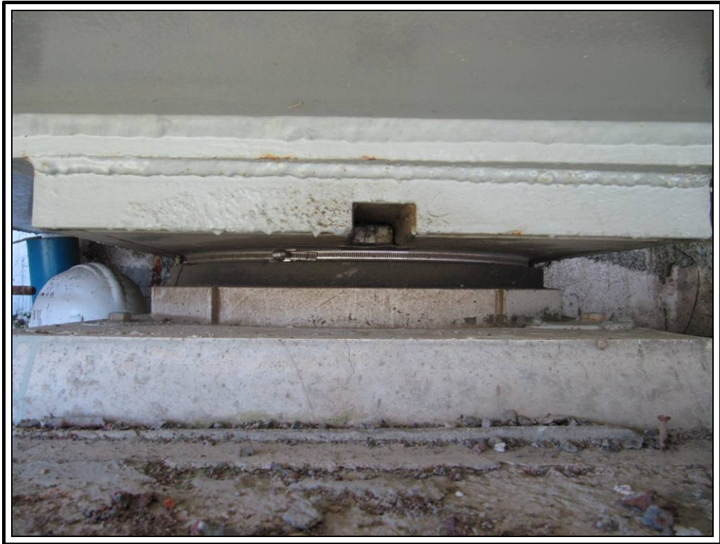
Apoyo derecho de estribo uno
