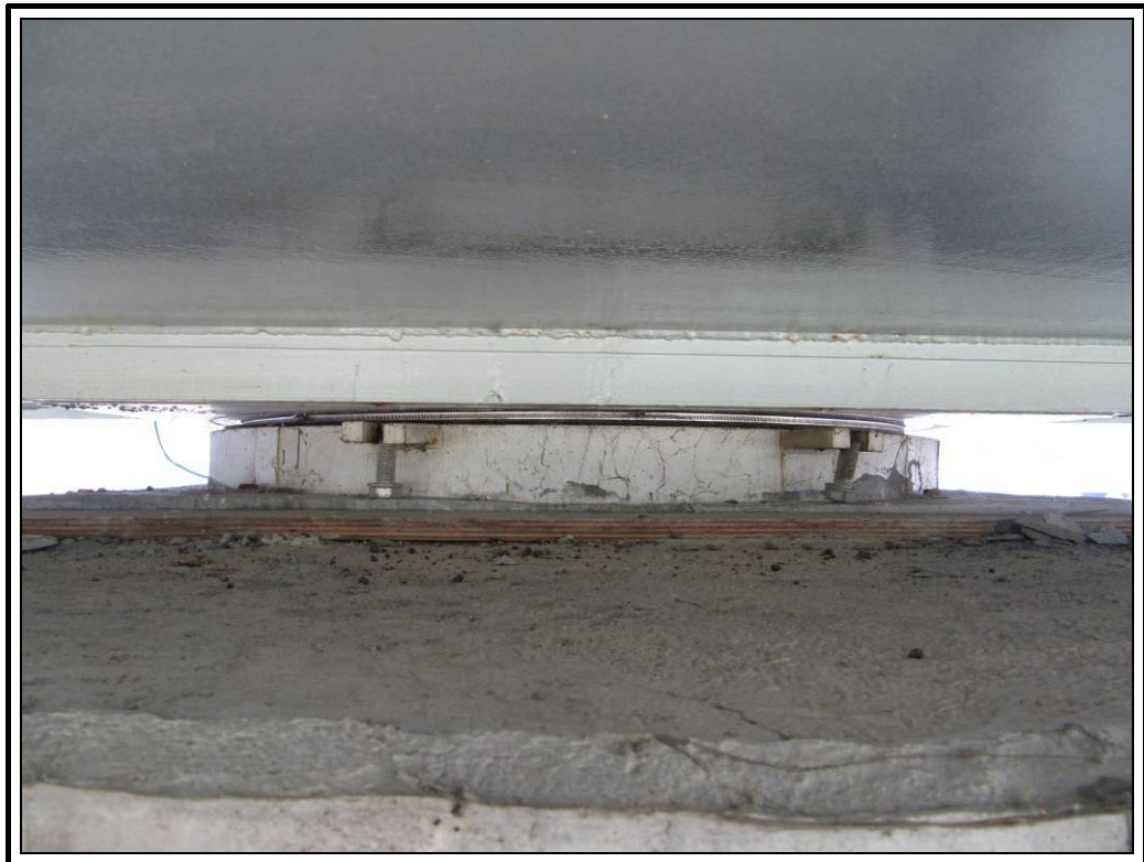
Apoyo izquierdo pila 1
