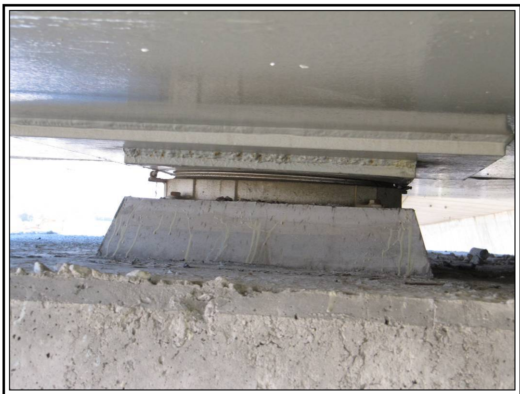
Apoyo izquierdo de pila estribo 2 (conexión con AP7 Hormigón)
