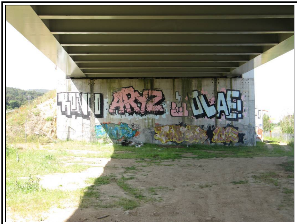
Estribo de entrada
