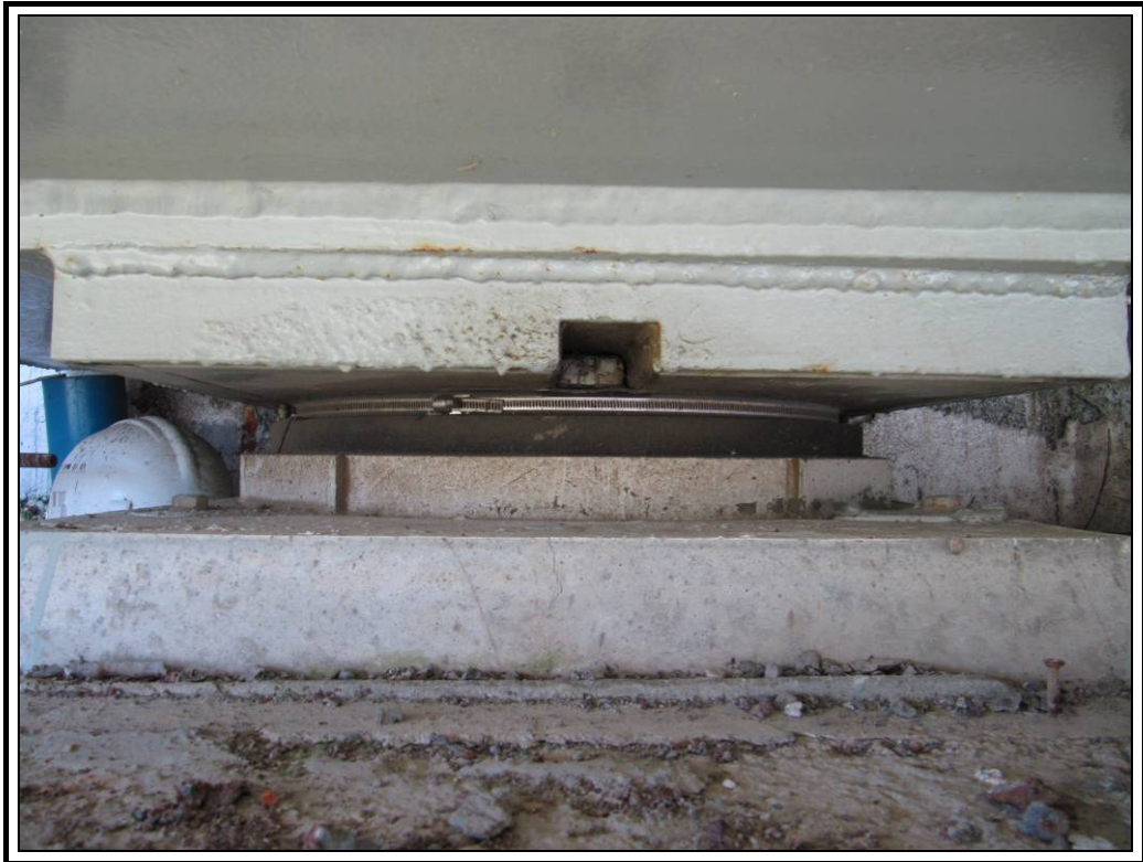
Apoyo derecho de estribo uno
