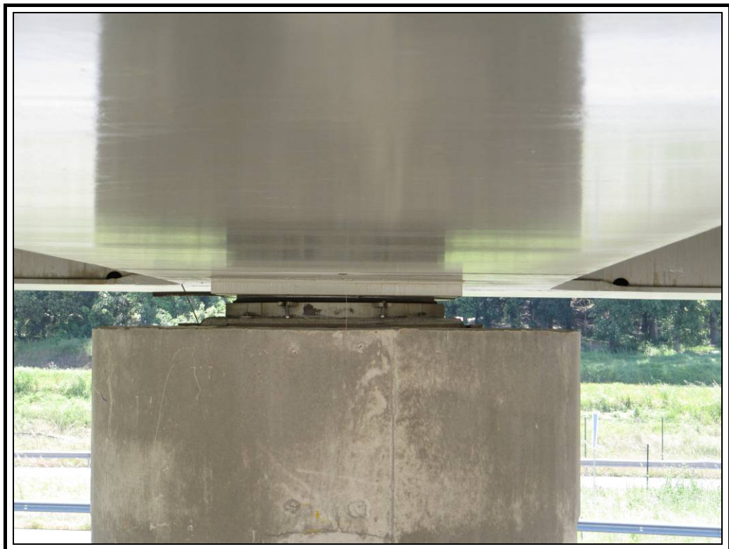
Apoyo derecho de pila 4 (vista lateral)
