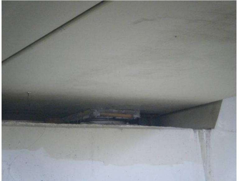
Fotografía N°13: Detalle del apoyo en el estribo 1.
