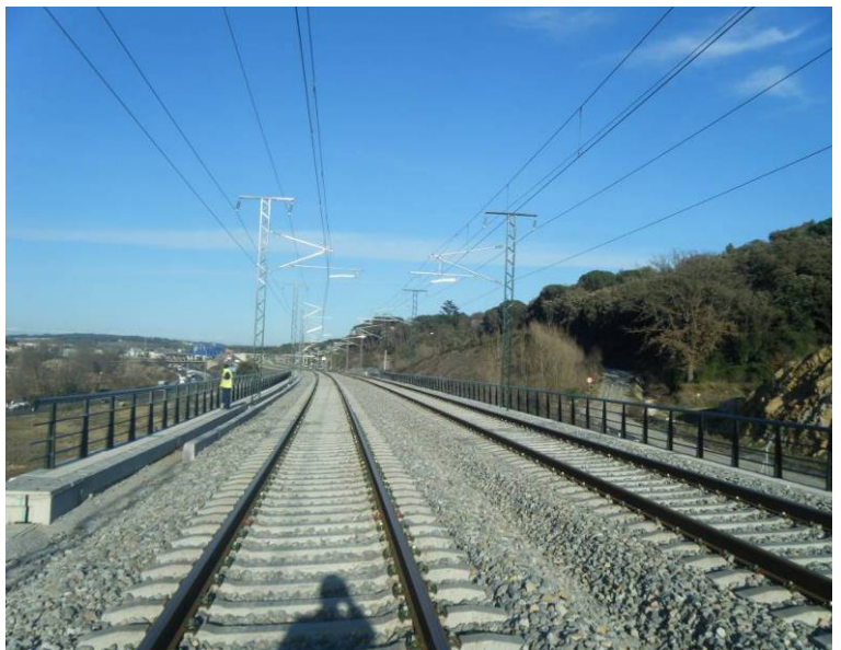
Fotografía N°6: Vista desde el estribo 1.
