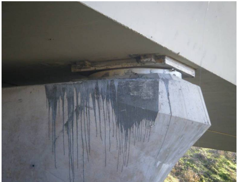
Fotografía N°14: Detalle del apoyo en la pila 2.
