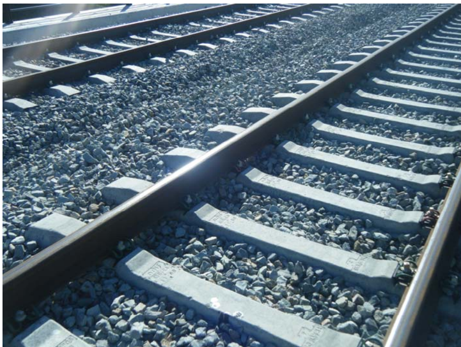
FOTOGRAFIA N° 6: Vista del material de vía
