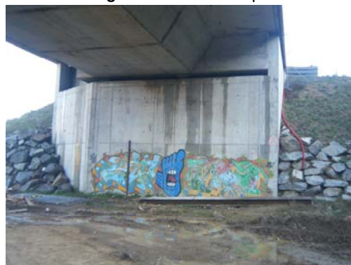
Fotografía nº 6. Estribo de salida
