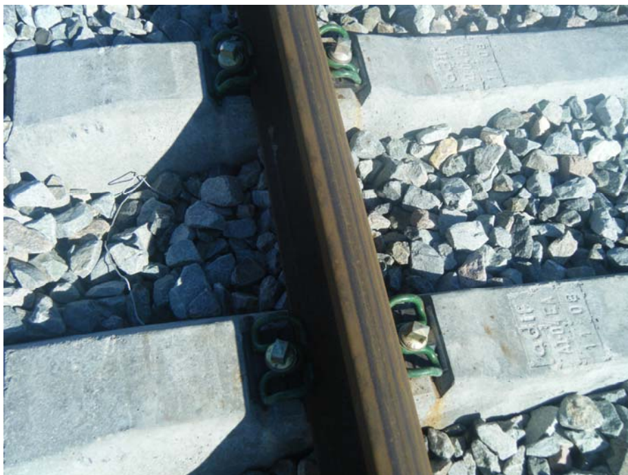
FOTOGRAFIA N° 7: Detalle de sujeción del carril
