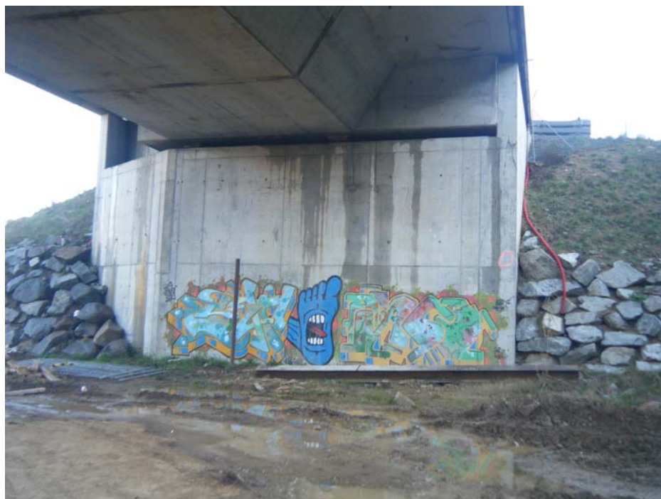
FOTOGRAFIA N° 11: Vista del estribo de salida
