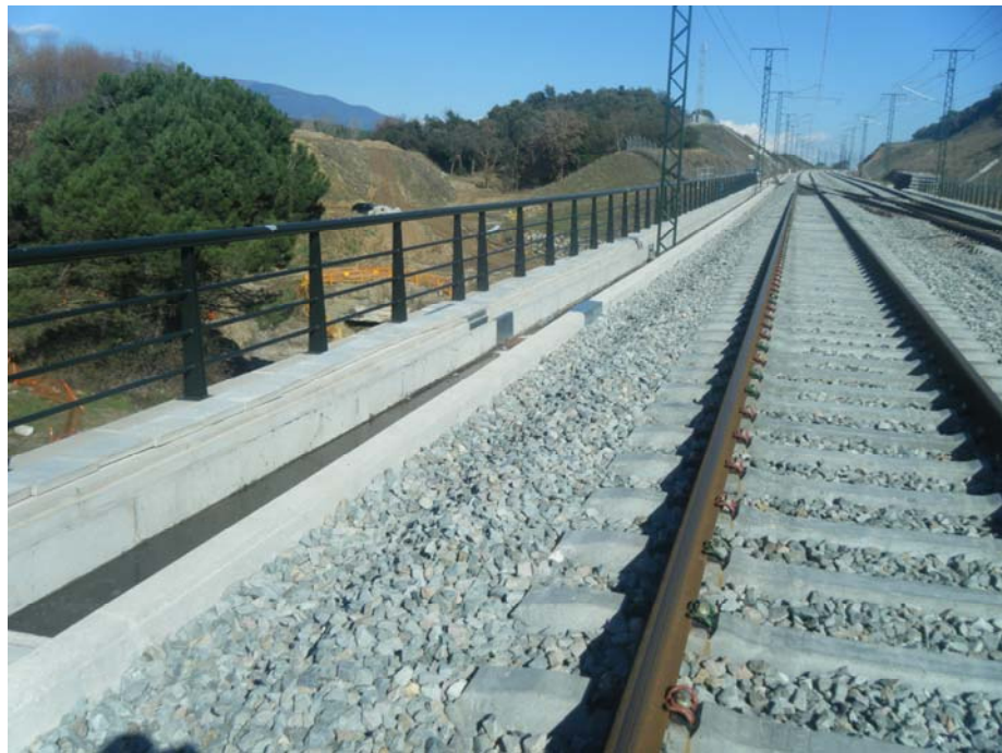
FOTOGRAFIA N° 9: Vista del lado izquierdo de la plataforma
