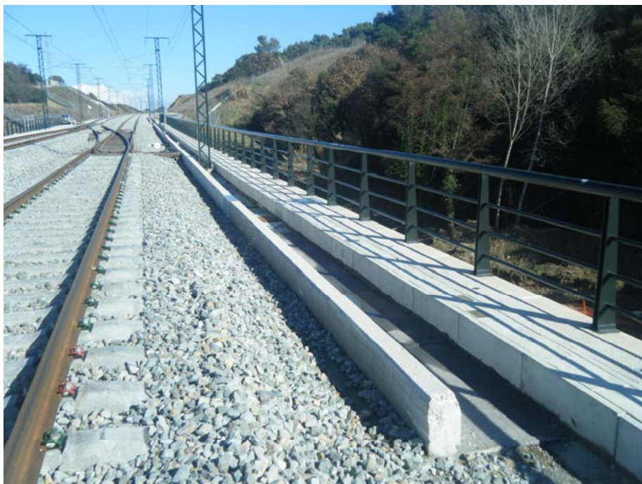
FOTOGRAFIA N° 8: Vista del lado derecho de la plataforma
