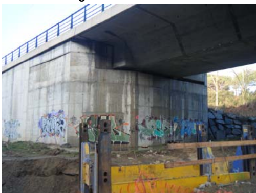
Fotografía nº 5. Estribo de entrada
