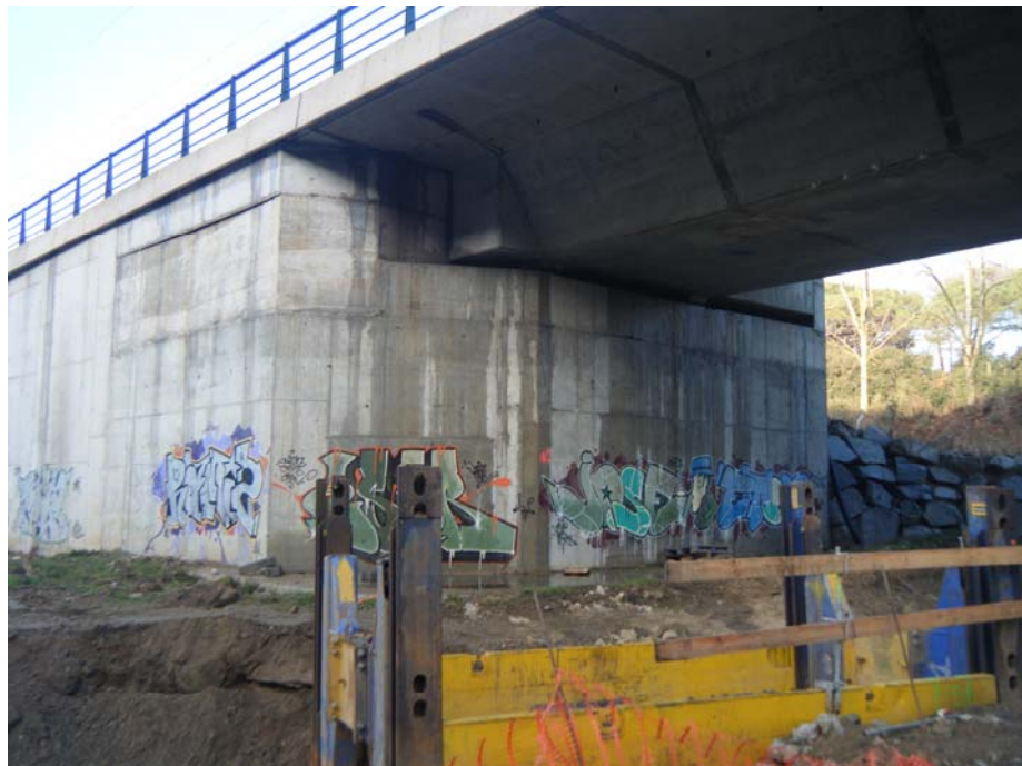
FOTOGRAFIA N° 10: Vista del estribo de entrada
