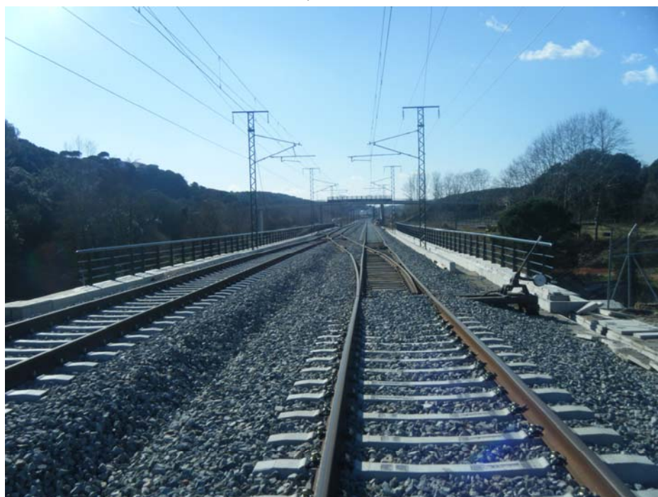
FOTOGRAFIA N° 2: Vista superior del tablero dirección Barcelona
