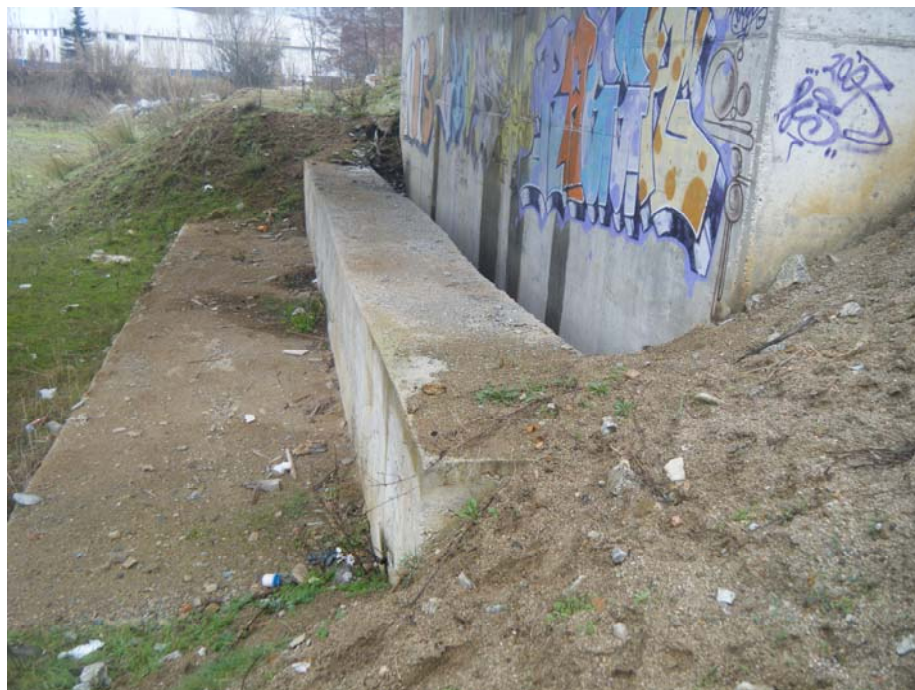
FOTOGRAFIA N° 17: Protección de hormigón
