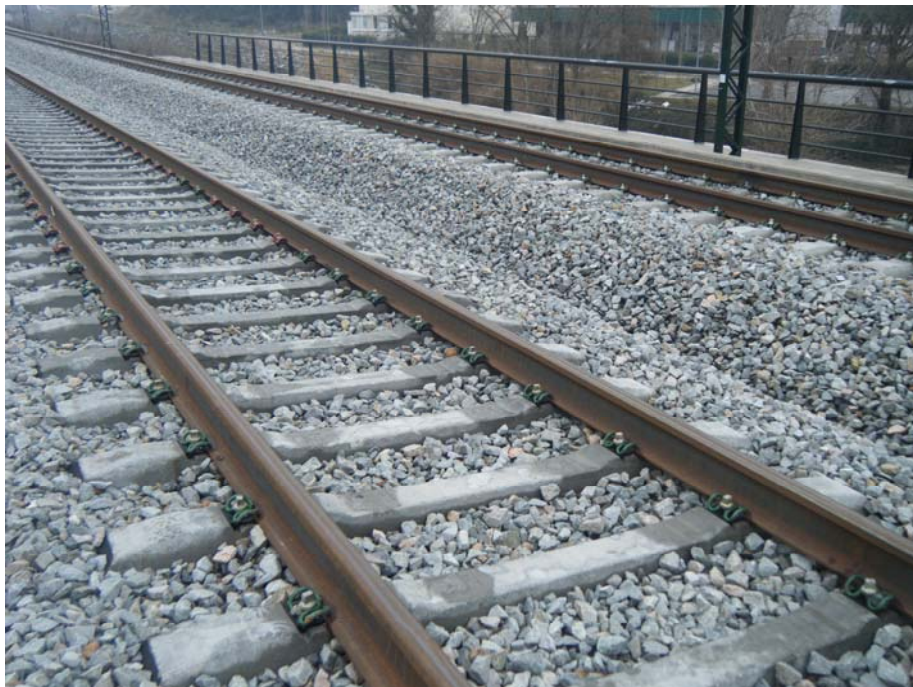
FOTOGRAFIA N° 6: Vista del material de vía
