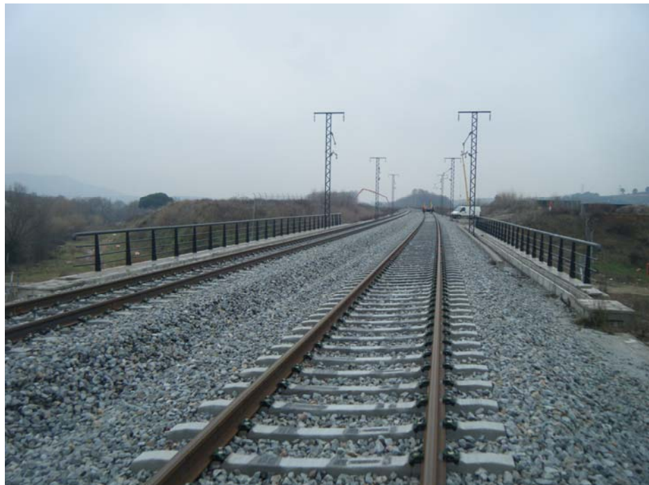
FOTOGRAFIA N° 2: Vista superior del tablero dirección Barcelona
