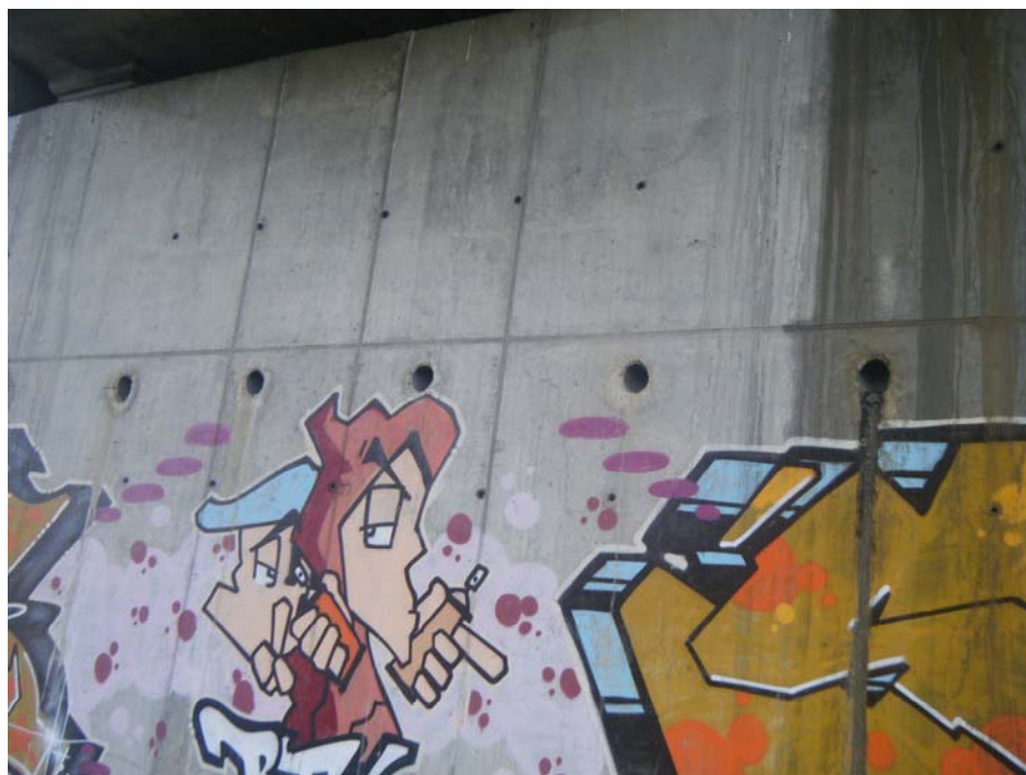
FOTOGRAFIA N° 20: Drenajes en el estribo de salida
