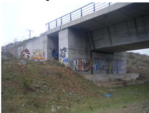
Fotografía nº 5. Estribo de entrada
