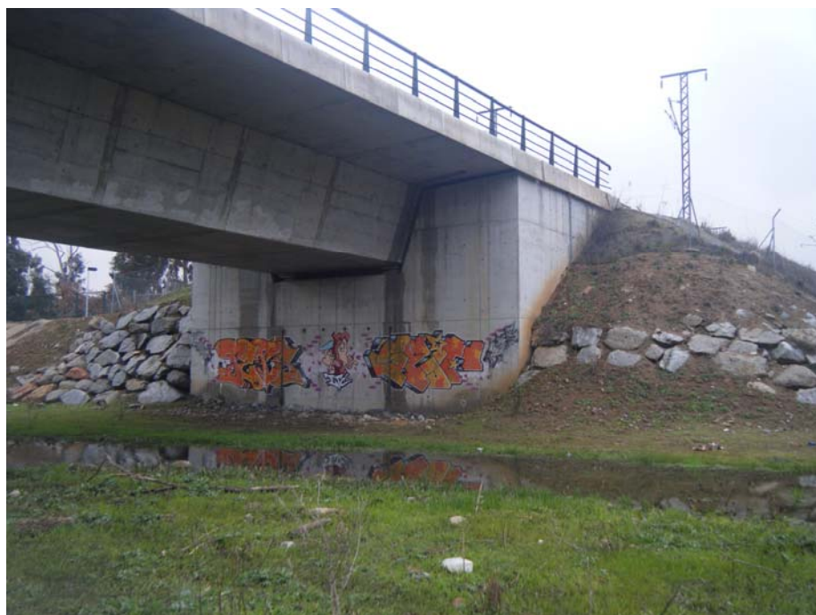
FOTOGRAFIA N° 11: Vista del lado estribo de salida
