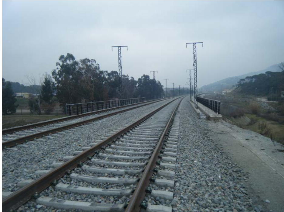
FOTOGRAFIA N° 1: Vista Superior del tablero dirección Girona
