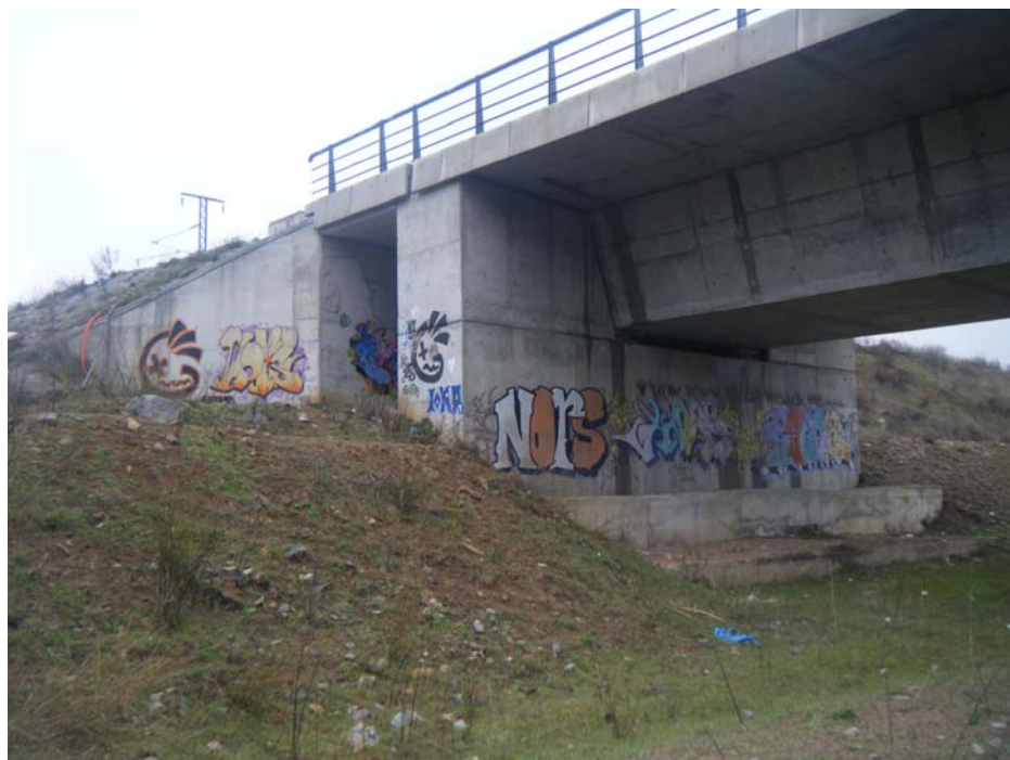
FOTOGRAFIA N° 10: Vista del estribo de entrada
