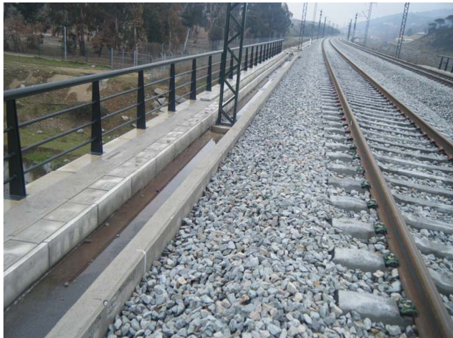
FOTOGRAFIA N° 9: Vista del lado izquierdo de la plataforma
