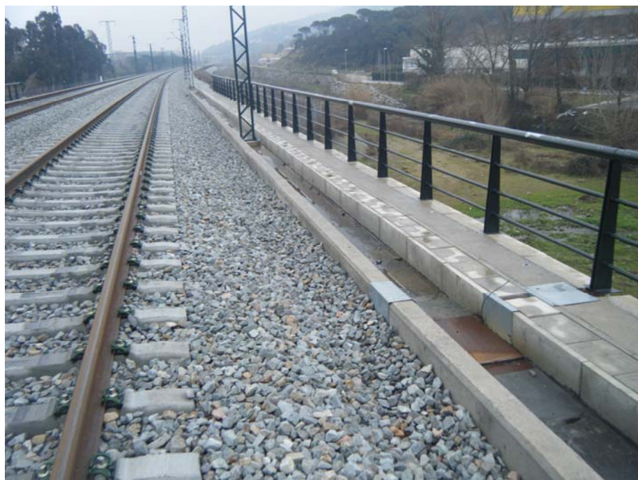
FOTOGRAFIA N° 8: Vista del lado derecho de la plataforma
