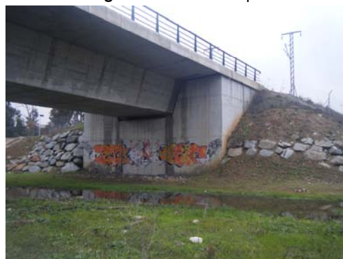
Fotografía nº 6. Estribo de salida
