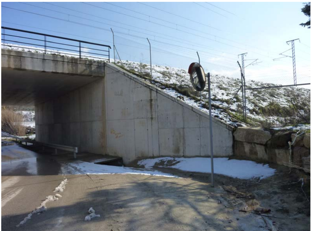
Fotografía 203: Vista del estribo de entrada
