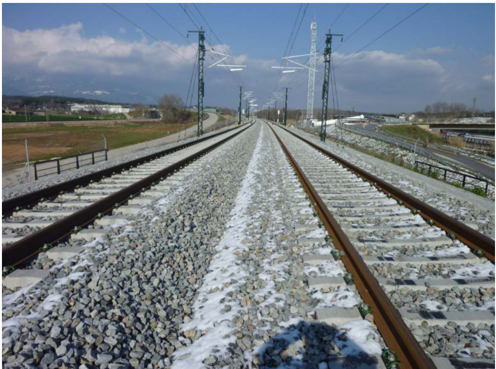
Fotografía 221: Vista desde el estribo de entrada
