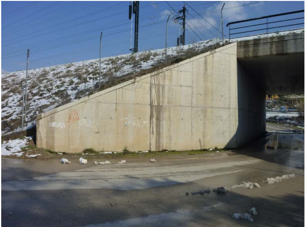
Fotografía 204: vista del estribo de salida
