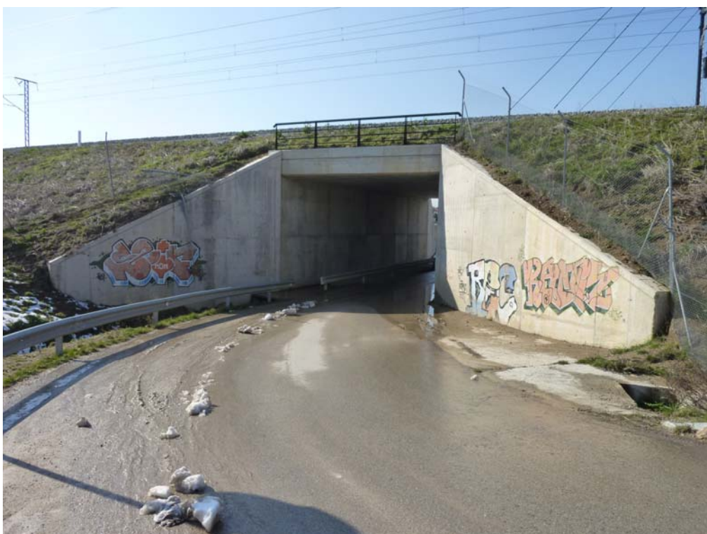
Fotografía 206: vista del alzado derecho
