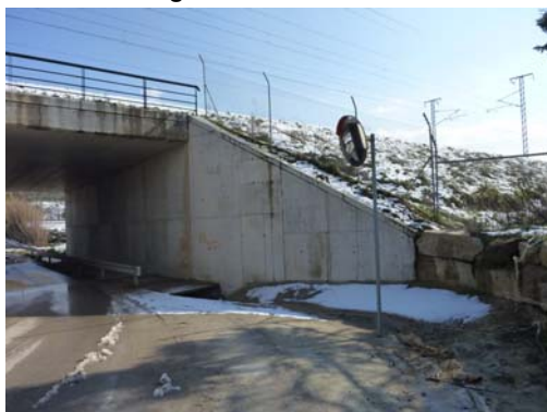
Fotografía nº 5. Estribo de entrada
