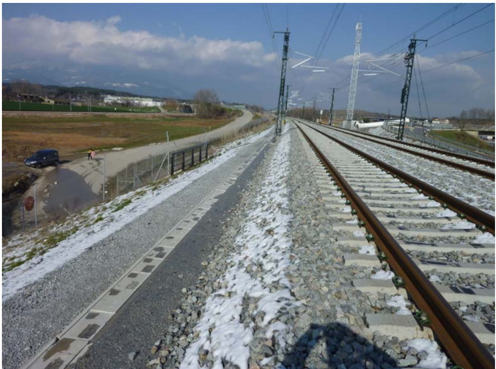
Fotografía 223: Vista del lado izquierdo de la plataforma
