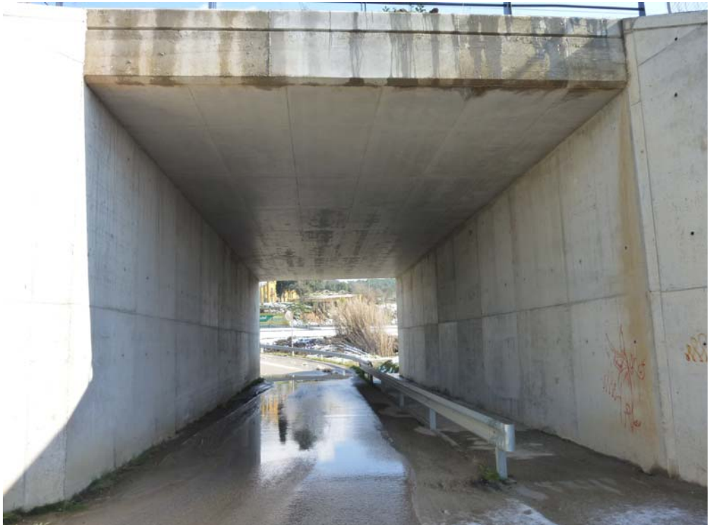
Fotografía 205: vista inferior de la losa superior
