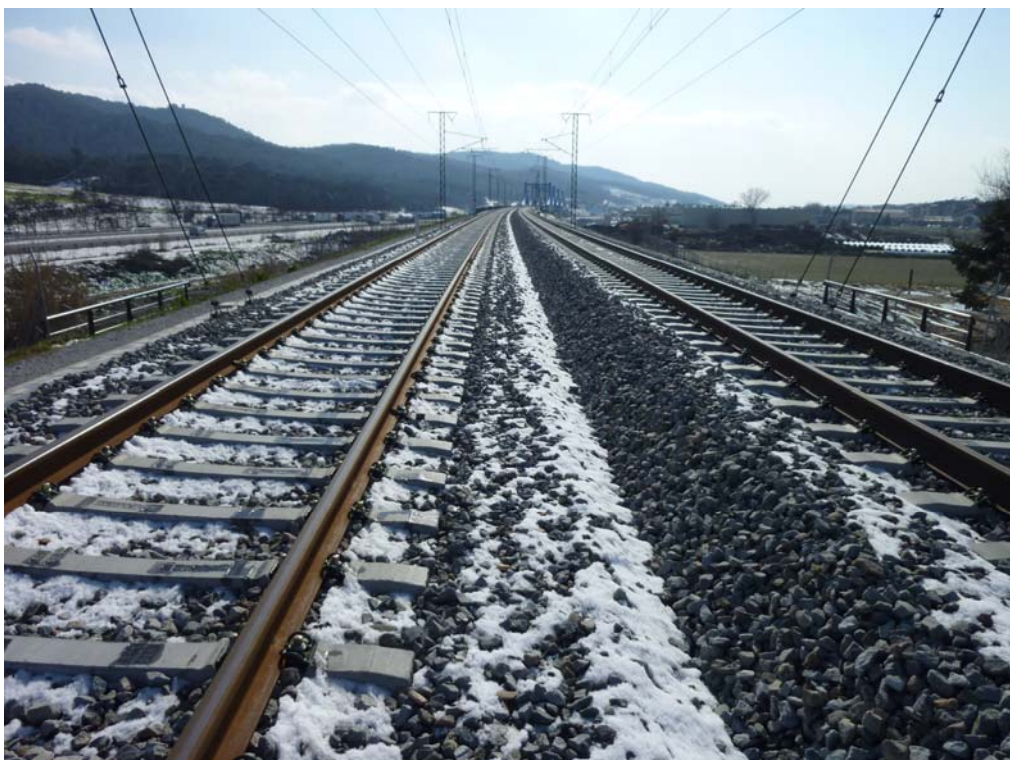
Fotografía 226: Vista del estribo de salida hacia el estribo de entrada
