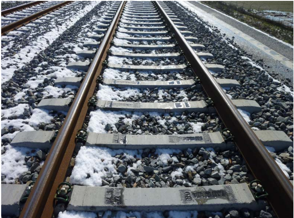
Fotografía 224: Material de vía
