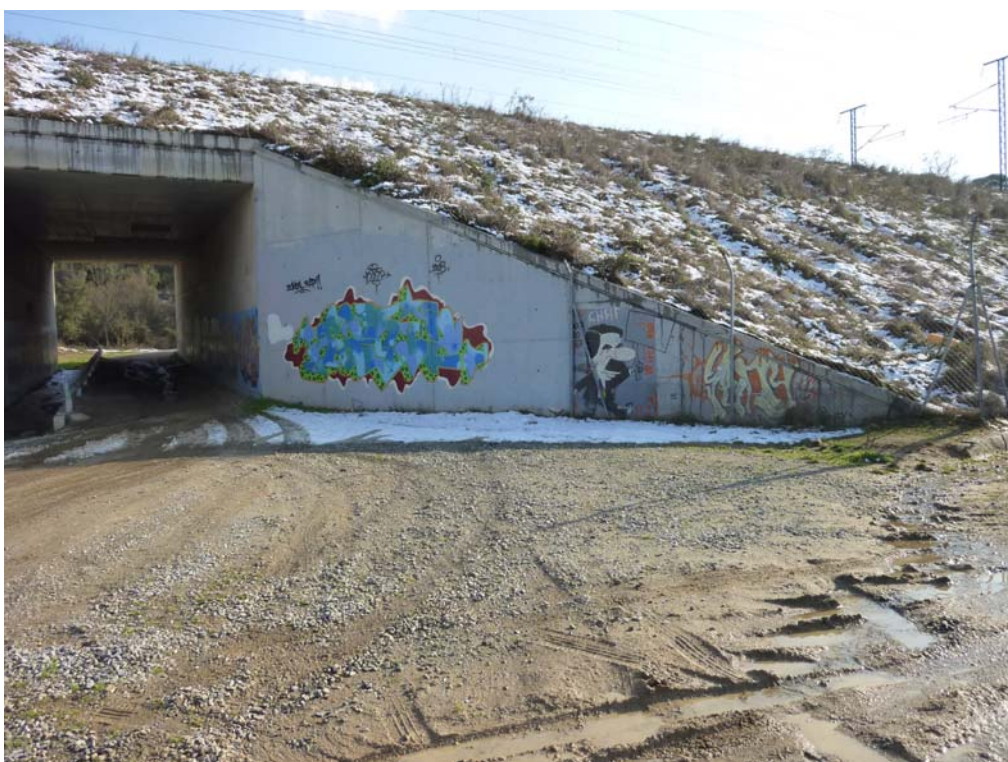
Fotografía 249: Vista del estribo de entrada
