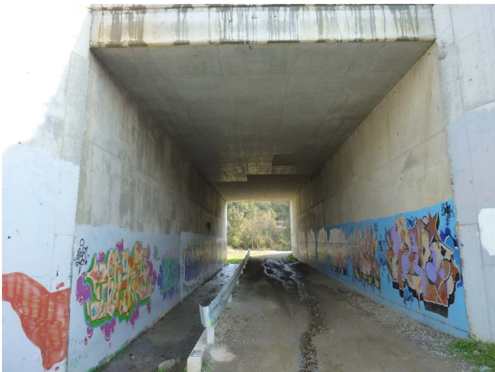
Fotografía 251: Vista inferior de la losa superior
