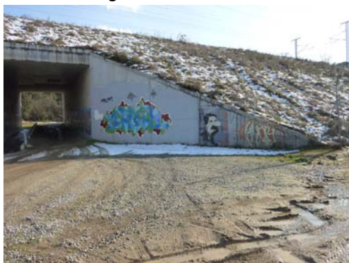
Fotografía nº 5. Estribo de entrada
