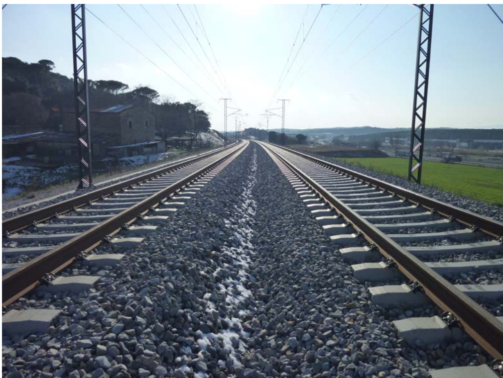
Fotografía 270: vista desde el estribo de salida hacia el estribo de entrada
