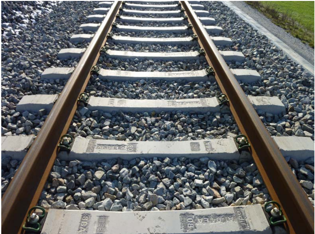
Fotografía 268: material de vía
