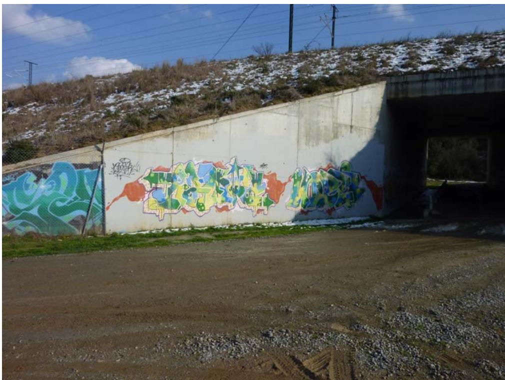
Fotografía 250: Vista del estribo de salida
