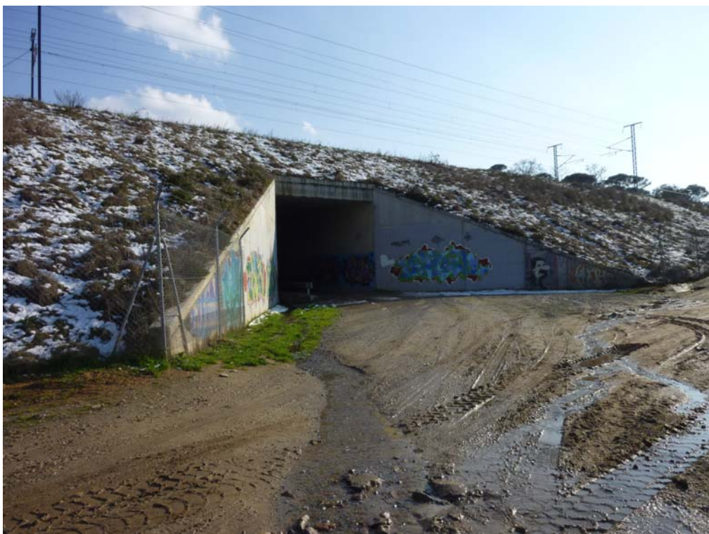
Fotografía 248: Vista del alzado izquierdo
