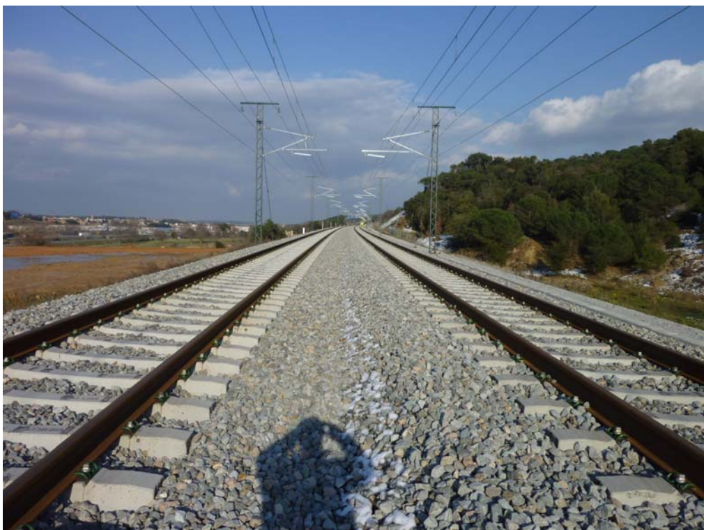
Fotografía 265: vista desde el estribo de entrada
