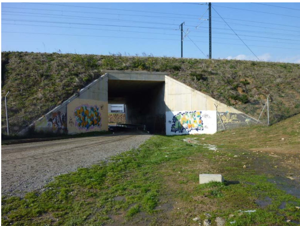
Fotografía 252: Vista del alzado derecho
