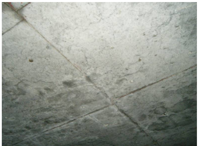
Fotografía N°18: Detalle de la cara inferior de la losa superior del tablero
