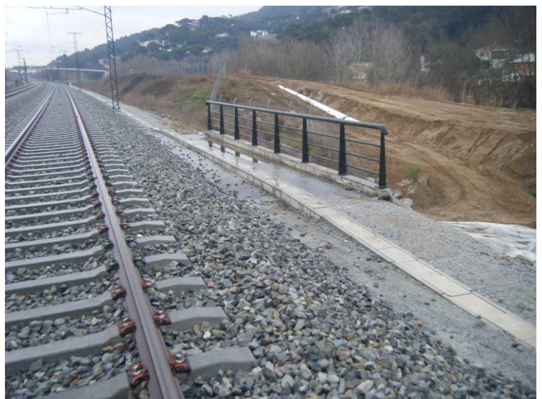
Fotografía N°9: Vista superior lado derecho
