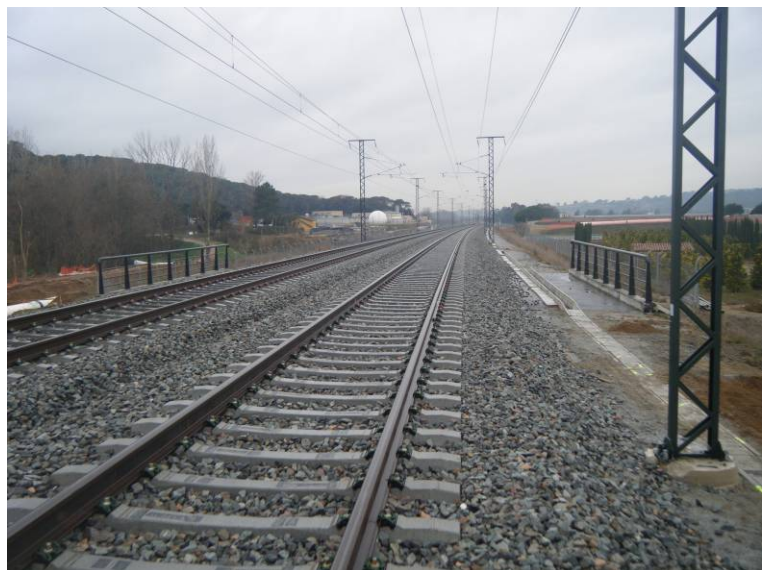
Fotografía N°8: Vista desde el estribo 2
