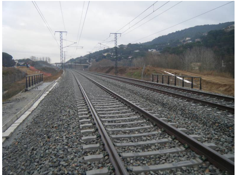
Fotografía N°7: Vista desde el estribo 1
