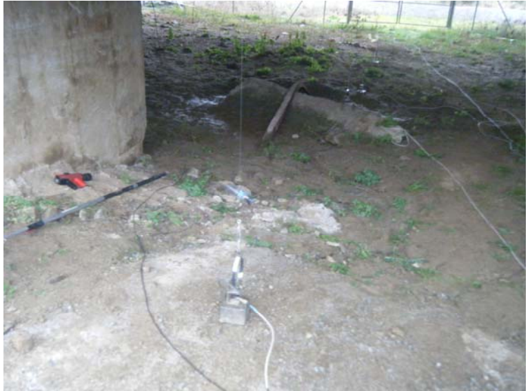
Fotografía N°1: Anillos en centro de vano
