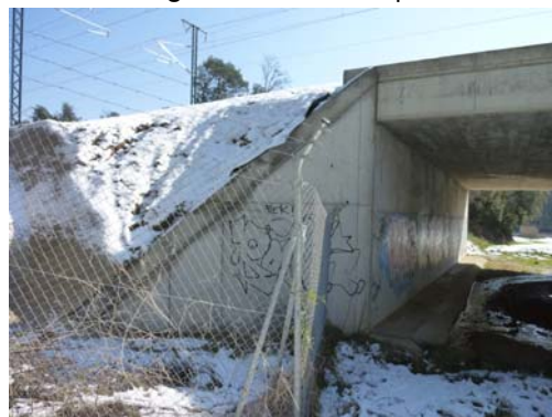
Fotografía nº 6. Estribo de salida
