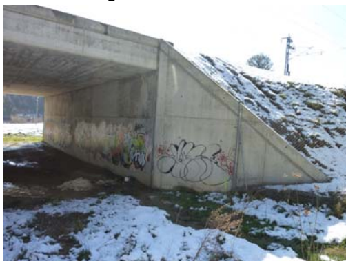
Fotografía nº 5. Estribo de entrada
