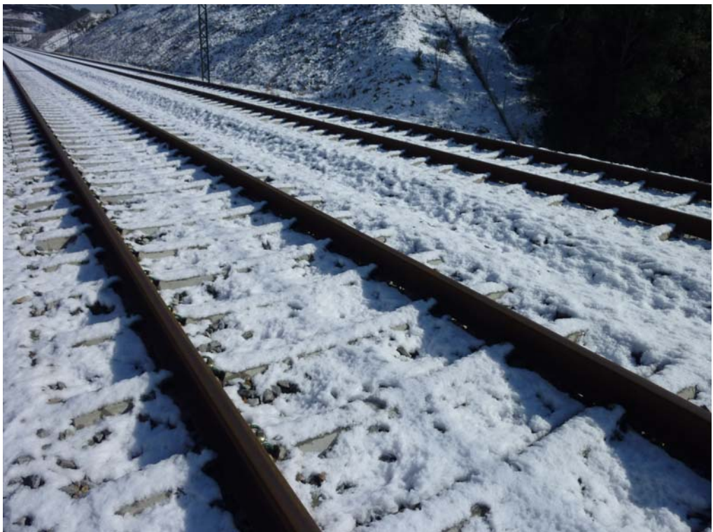
Fotografía 115: Material de vía
