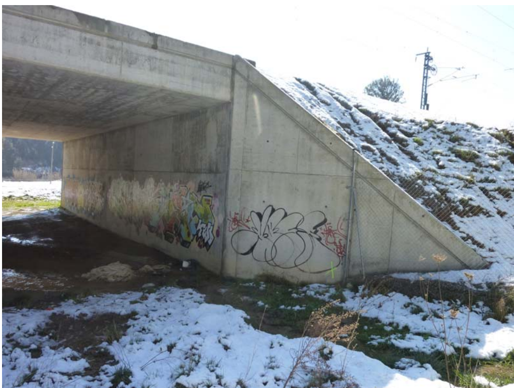
Fotografía 119: Vista estribo E1
