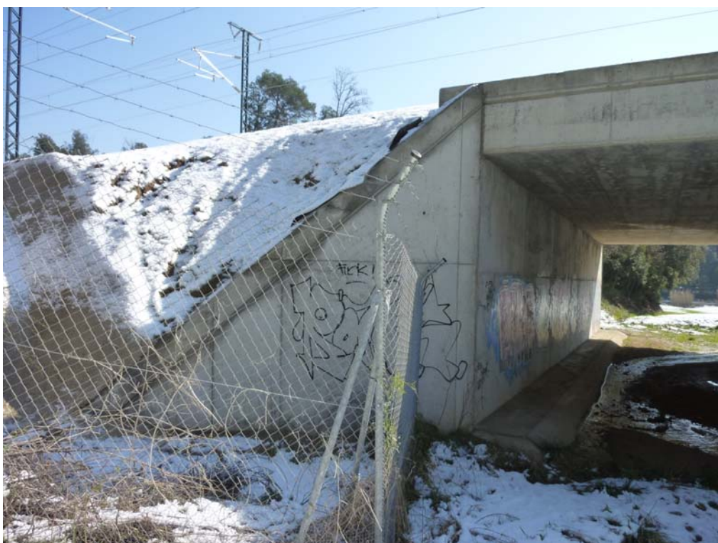
Fotografía 120: Vista estribo E2
