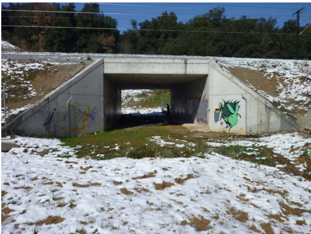
Fotografía 122: Vista alzado derecho
