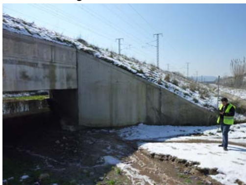
Fotografía nº 5. Estribo de entrada
