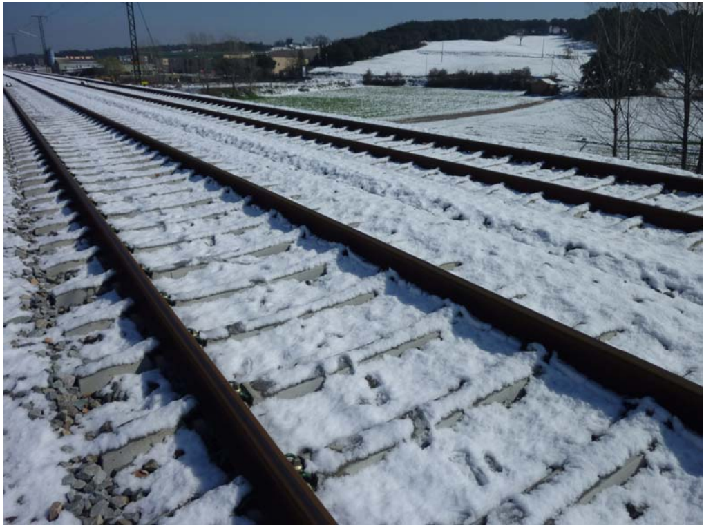
Fotografía 149: Material de vía
