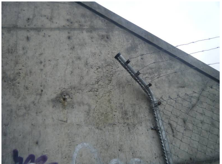
Fotografía N°15: Nido de grava en aleta iz- quierda estribo 1
