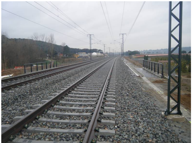
Fotografía N°8: Vista desde el estribo 2
