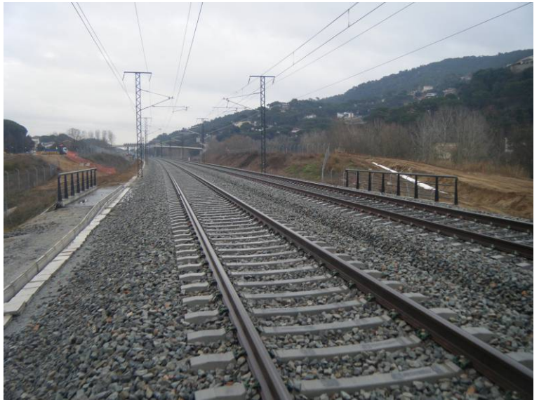
Fotografía N°7: Vista desde el estribo 1
