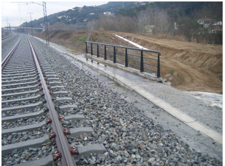
Fotografía N°9: Vista superior lado derecho
