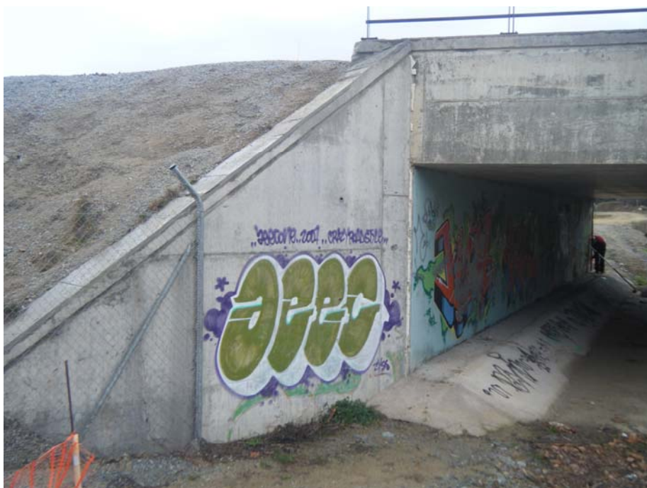
FOTOGRAFIA N° 10: Vista del estribo de entrada
