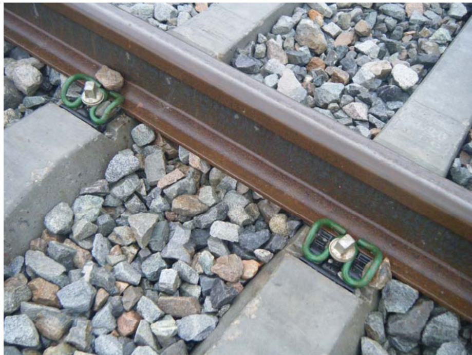
FOTOGRAFIA N° 7: Detalle de sujeción del carril
