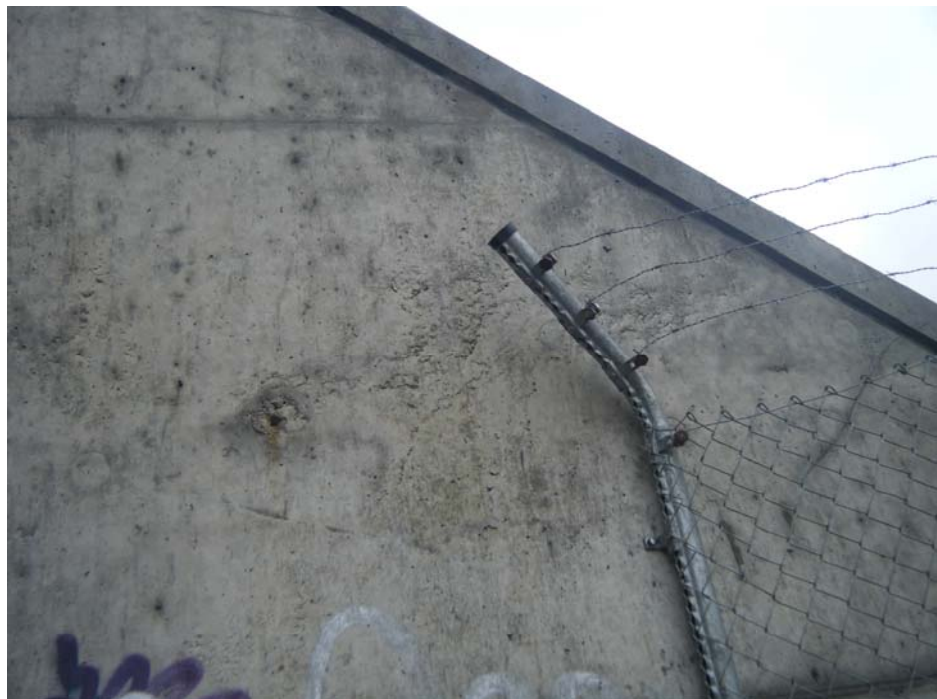
FOTOGRAFIA N° 12: Nido de grava en la aleta izquierda del estribo de salida
