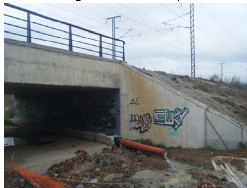
Fotografía nº 6. Estribo de salida
