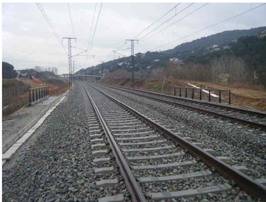
FOTOGRAFIA N° 1: Vista Superior del tablero dirección Riudellots
