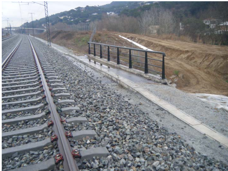
FOTOGRAFIA N° 8: Vista del lado derecho de la plataforma
