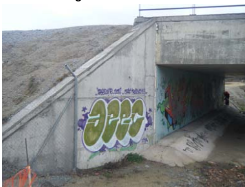
Fotografía nº 5. Estribo de entrada
