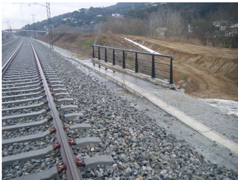
FOTOGRAFIA N° 2: Vista superior del tablero dirección Barcelona
