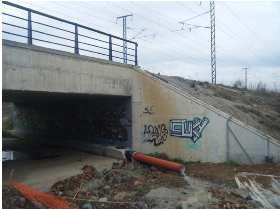
FOTOGRAFIA N° 11: Vista del estribo de salida
