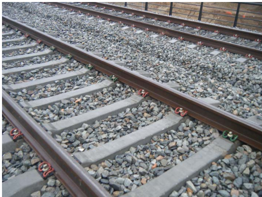
FOTOGRAFIA N° 6: Vista del material de vía
