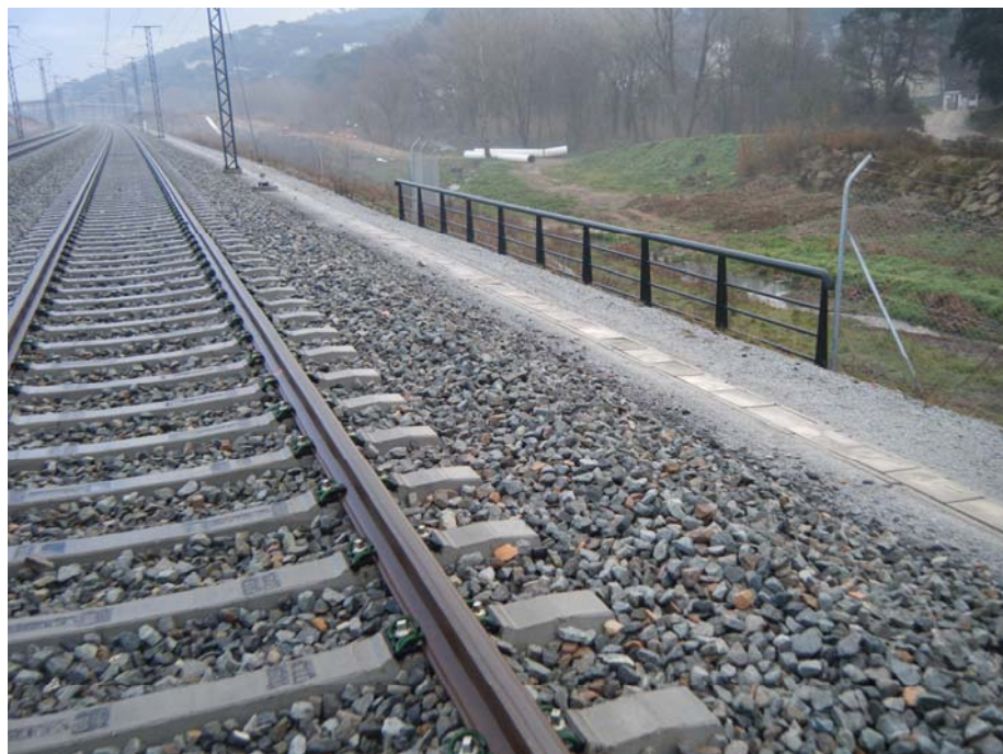
FOTOGRAFIA N° 8: Vista del lado derecho de la plataforma
