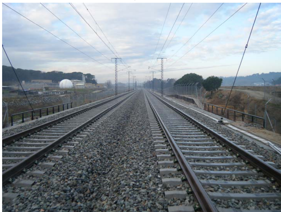
FOTOGRAFIA N° 2: Vista superior del tablero dirección Madrid
