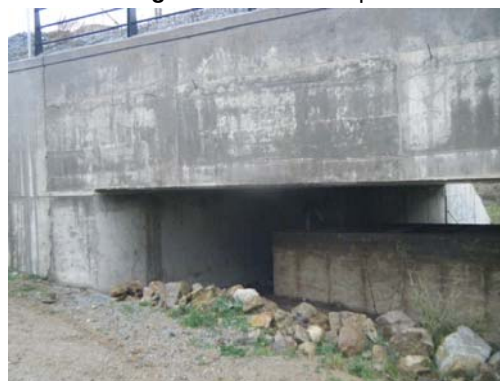
Fotografía nº 6. Estribo de salida
