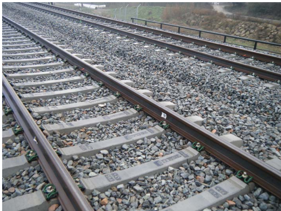
FOTOGRAFIA N° 6: Vista del material de vía
