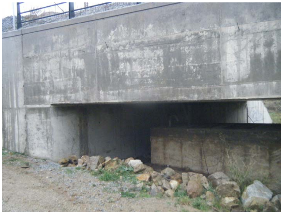
FOTOGRAFIA N° 11: Vista del estribo de salida
