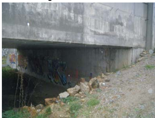
Fotografía nº 5. Estribo de entrada
