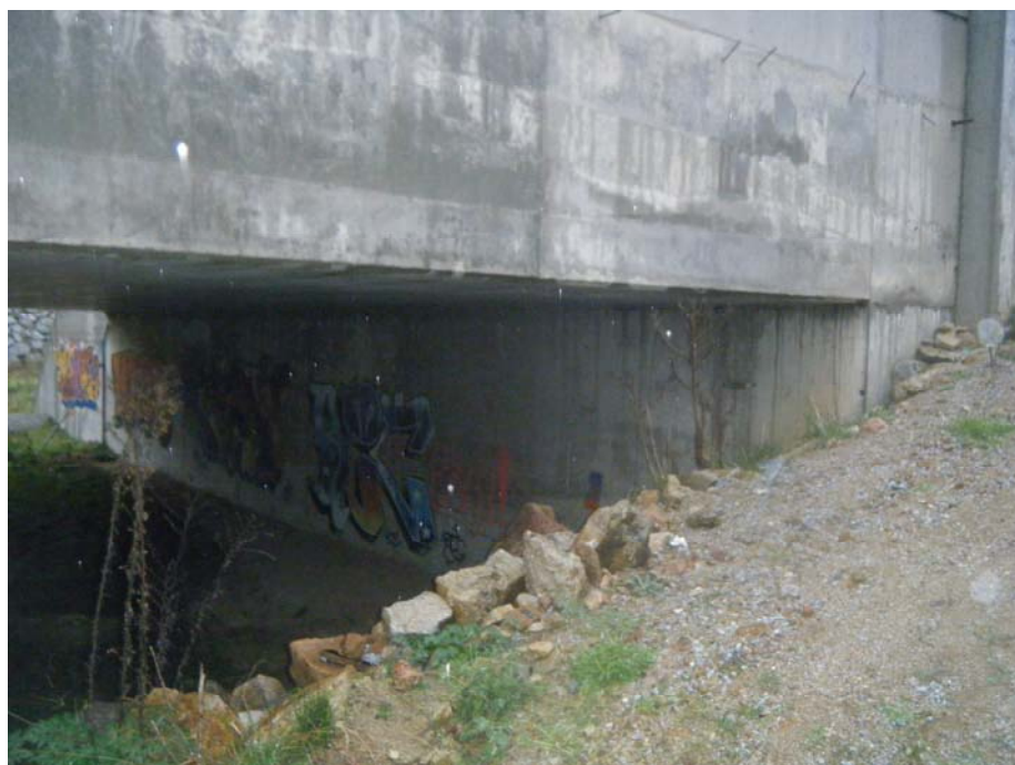
FOTOGRAFIA N° 10: Vista del estribo de entrada
