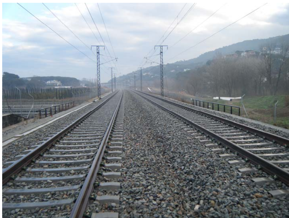
FOTOGRAFIA N° 1: Vista Superior del tablero dirección Cuenca
