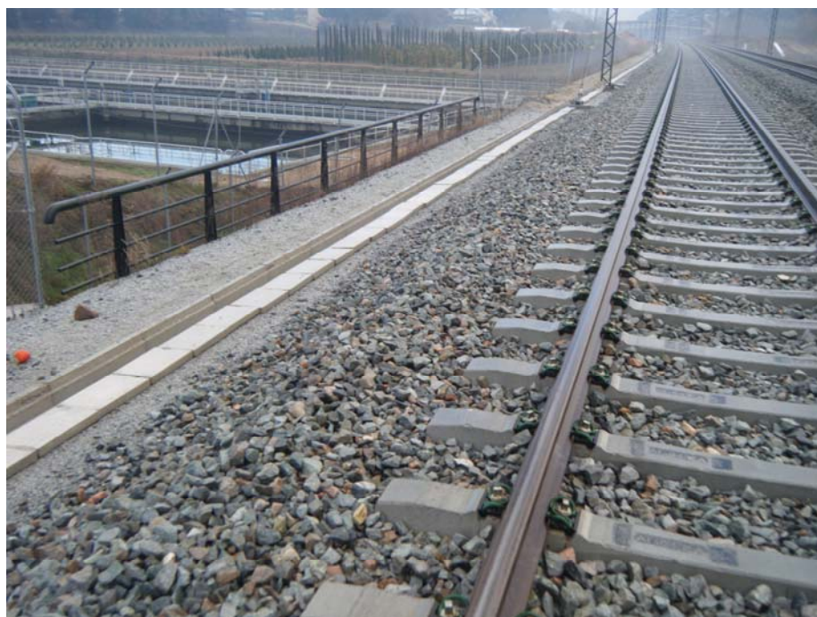
FOTOGRAFIA N° 9: Vista del lado izquierdo de la plataforma
