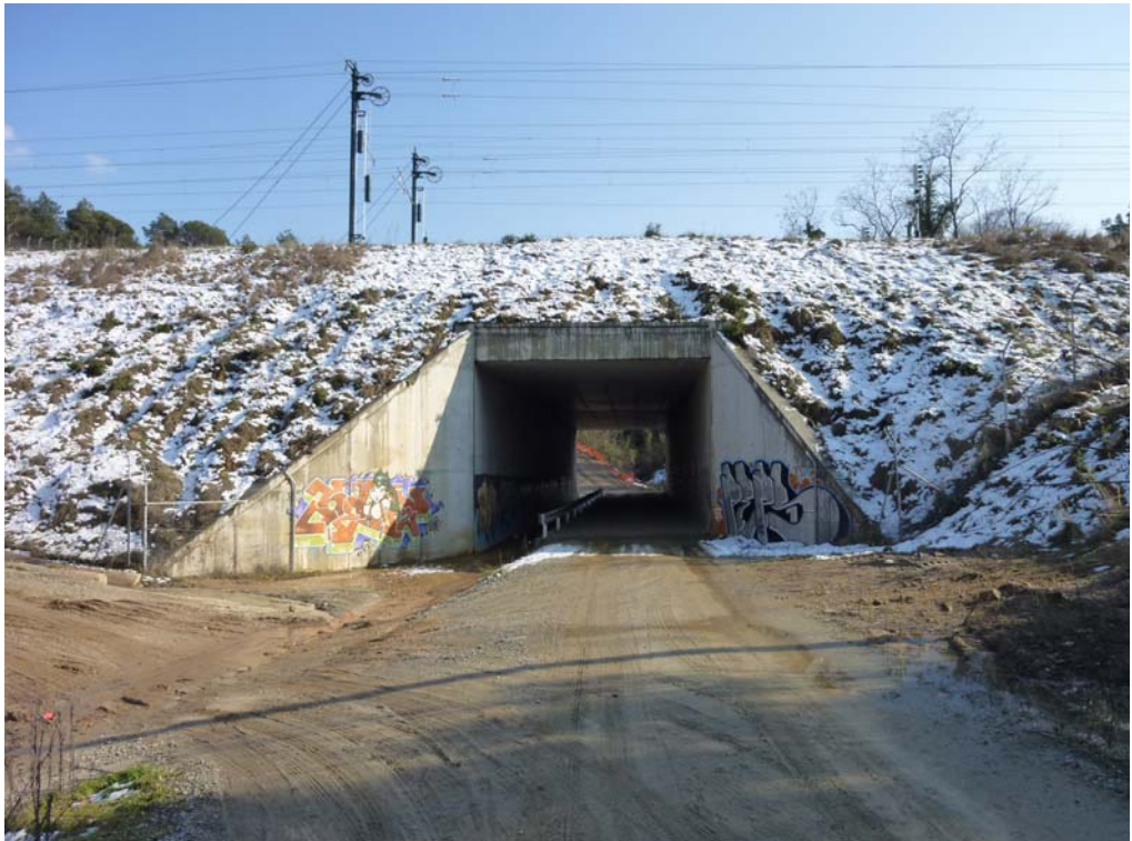
Fotografía 227: Vista del alzado derecho
