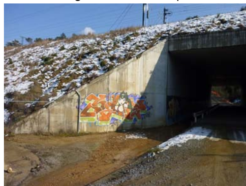
Fotografía nº 6. Estribo de salida
