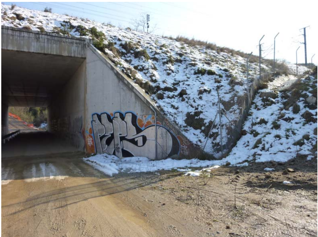
Fotografía 228: estribo de entrada
