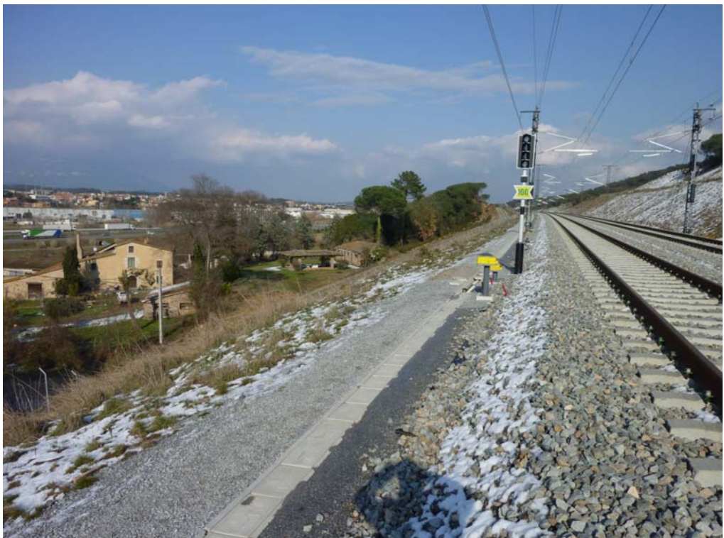
Fotografía 234: Vista del lado izquierdo de la plataforma
