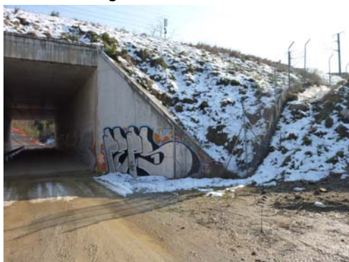
Fotografía nº 5. Estribo de entrada
