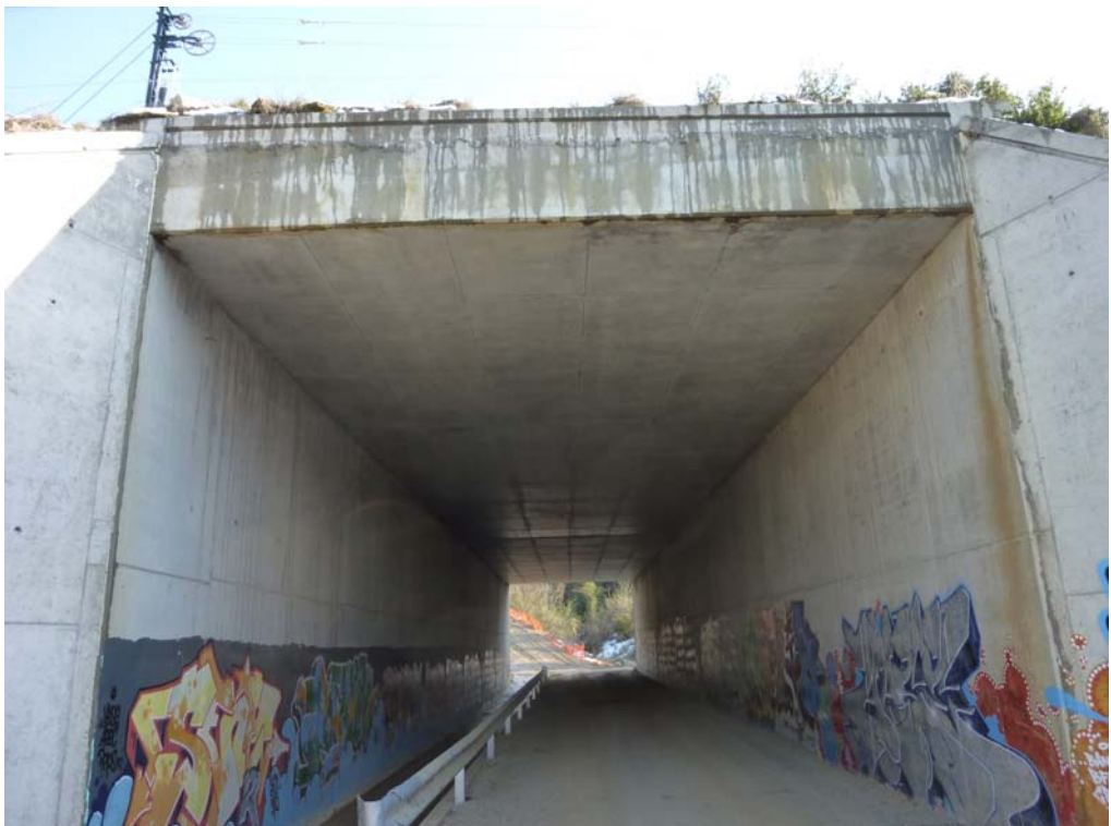
Fotografía 230: Vista inferior de la losa superior
