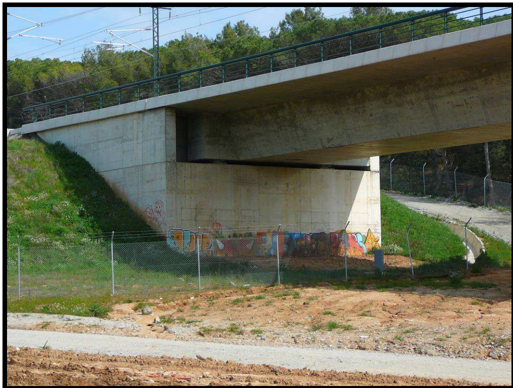
4. Estribo de salida.
