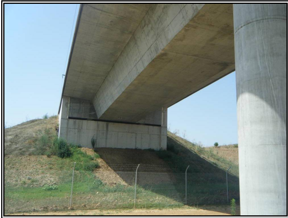
Nº 3.- Estribo de entrada.
