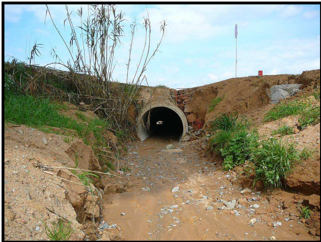
18. Boca de drenaje, aguas abajo del camino.
