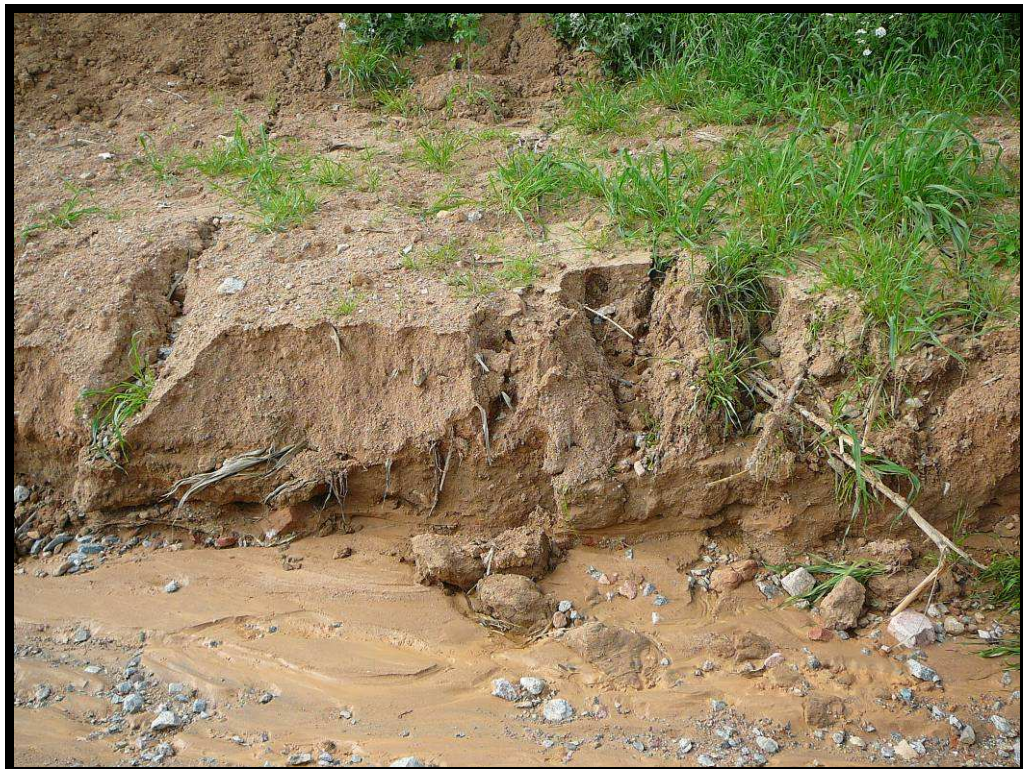
21. Erosión en margen derecha de aguas abajo, junto a pila 2.
