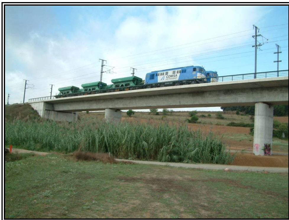
Nº 11.- Prueba estática Estado 4 (Vanos Nº 1 y Nº 2).
