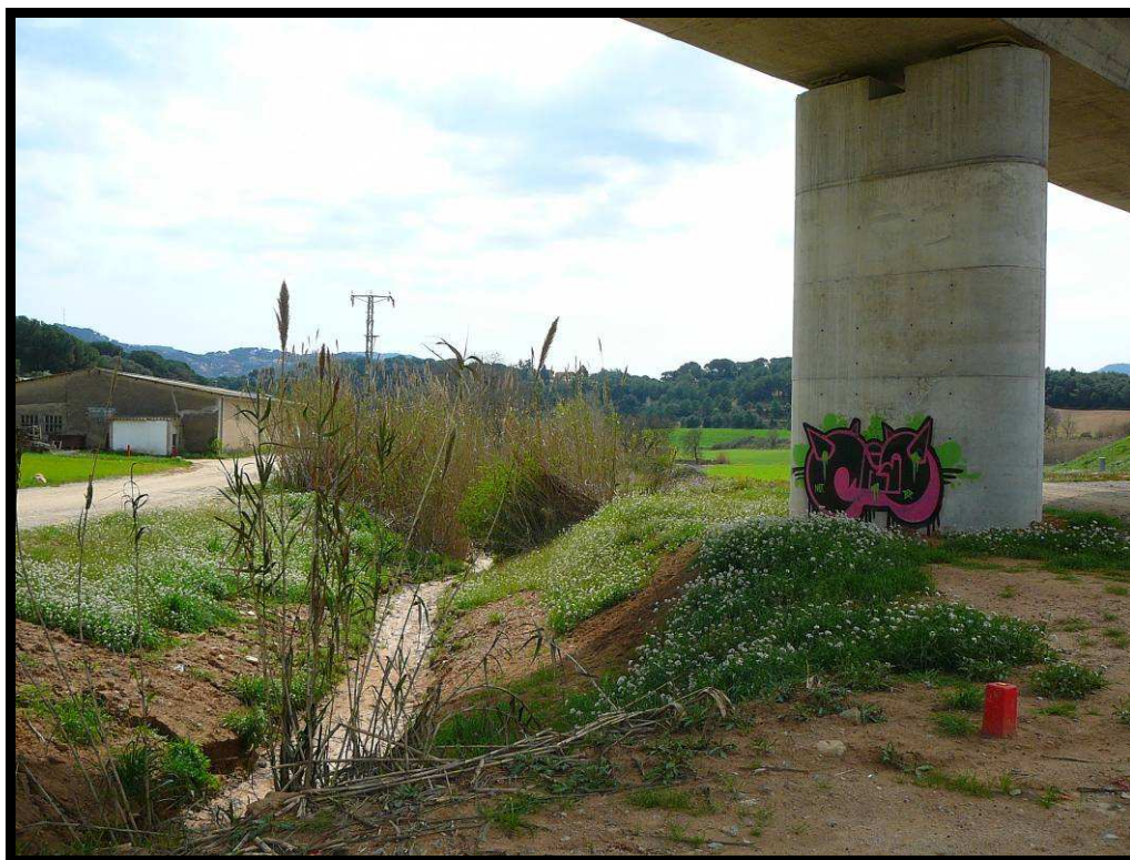
7. Cauce bajo la estructura.
