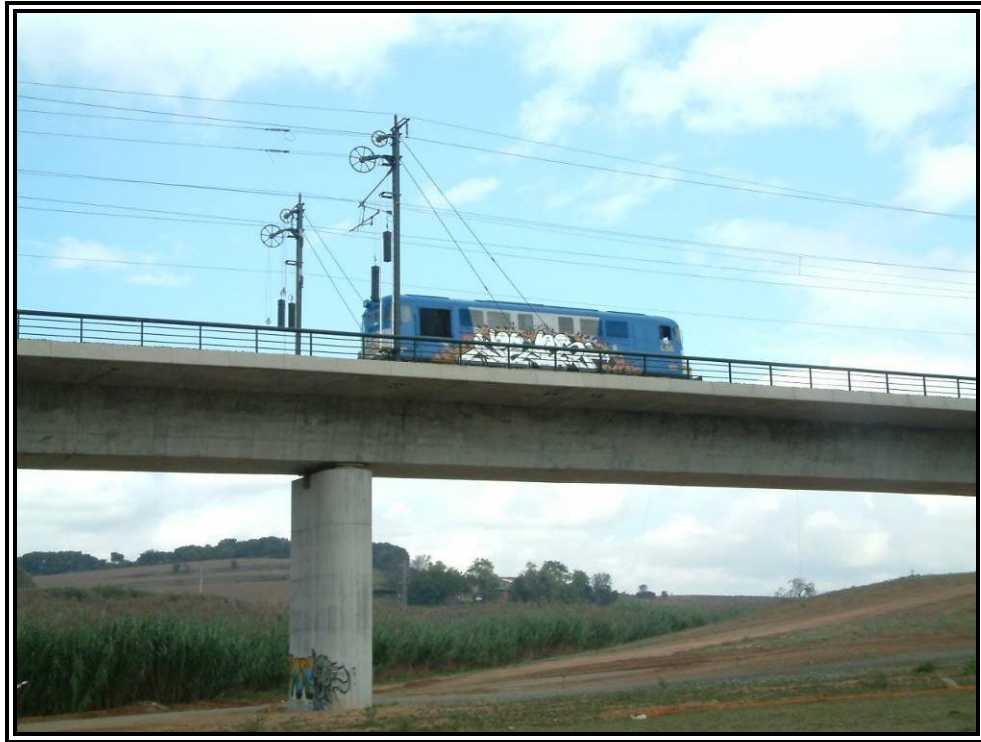
Nº 13.- Realización de prueba dinámica.
