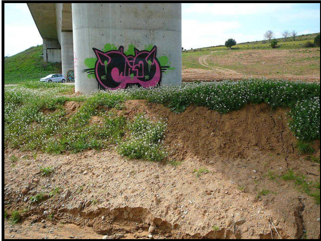
21. Erosión en margen derecha de aguas abajo, junto a pila 2.
