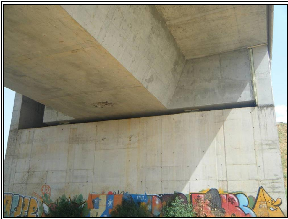
Nº 4.- Estribo de salida.
