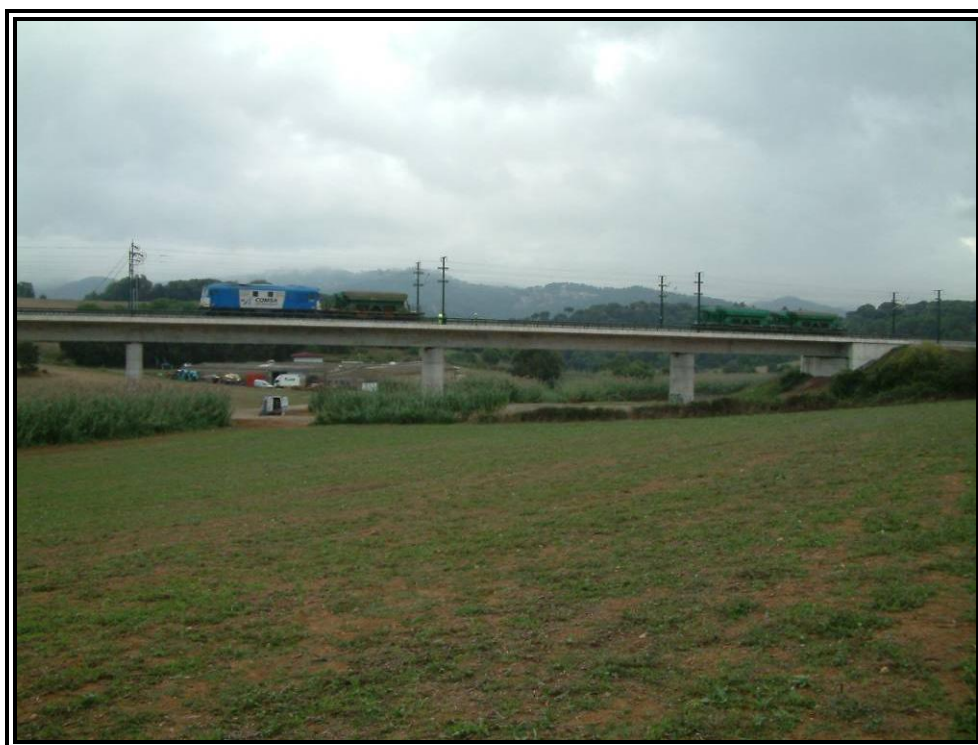
Nº 8.- Prueba estática Estado 1 (Vanos Nº 1 y Nº 3).
