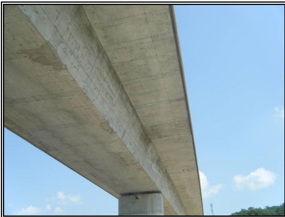
Nº 5.- Vista inferior de la estructura.
