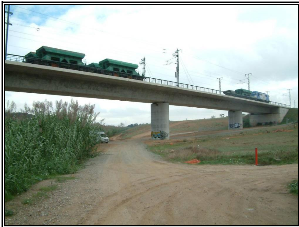
Nº 10.- Prueba estática Estado 3 (Vanos Nº 3 y Nº 5).
