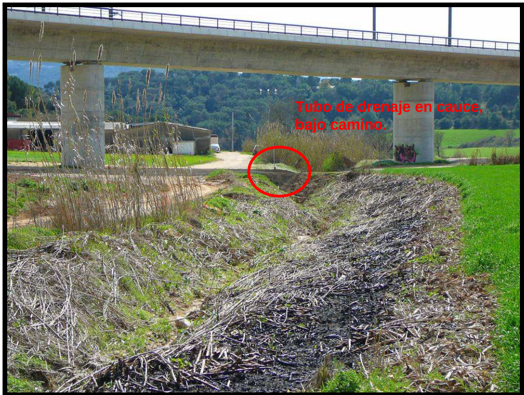
16. tubo de drenaje en cauce.
