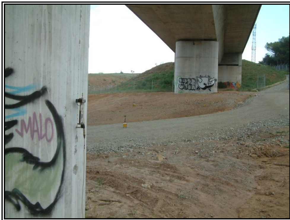
Nº 7.- LVDT's en pila y vanos.
