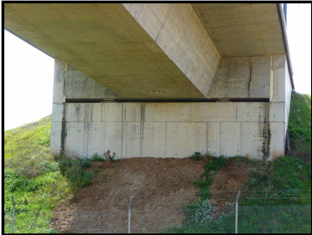
3. Estribo de entrada.
