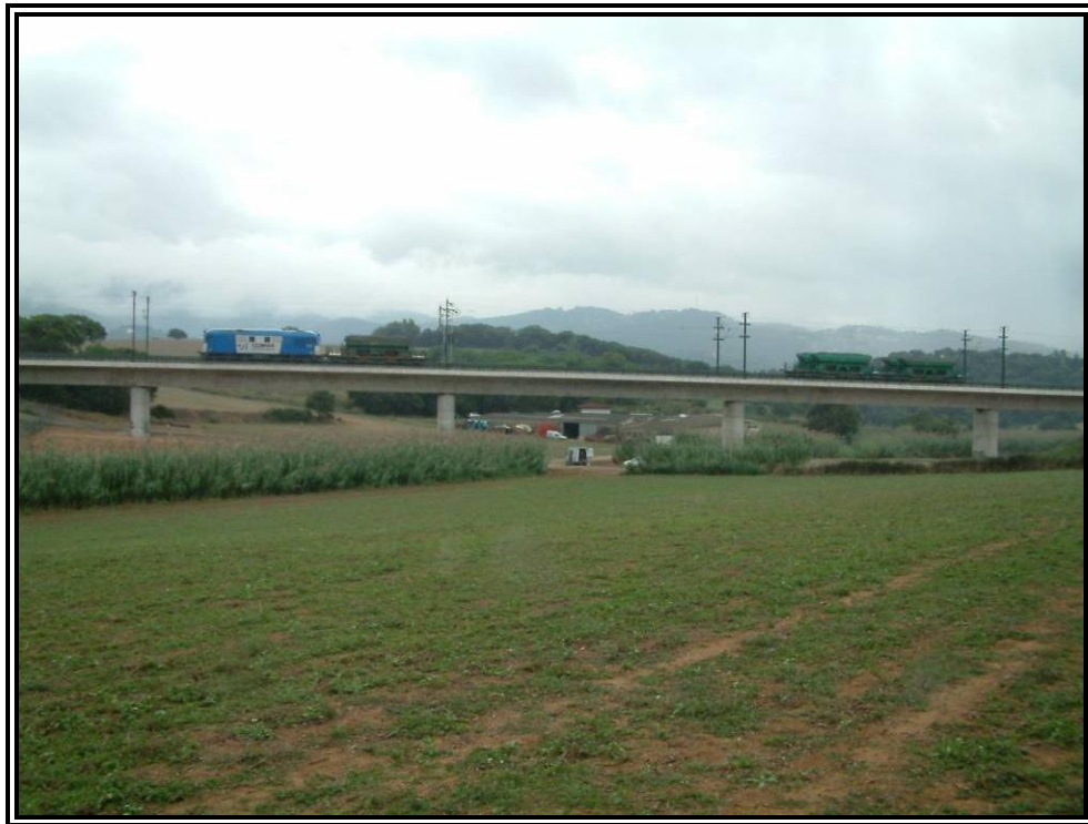
Nº 9.- Prueba estática Estado 2 (Vanos Nº 2 y Nº 4).
