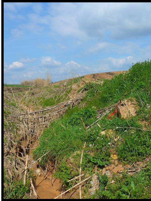
9. Margen izquierda aguas arriba.
