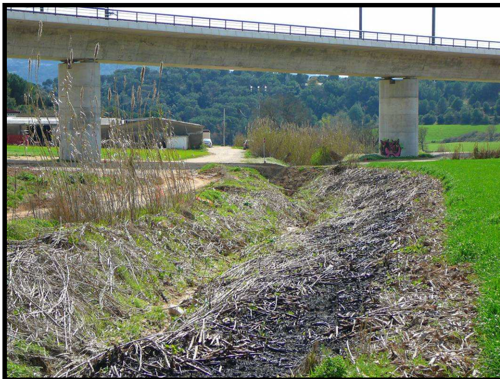
5. Cauce hacia aguas abajo.
