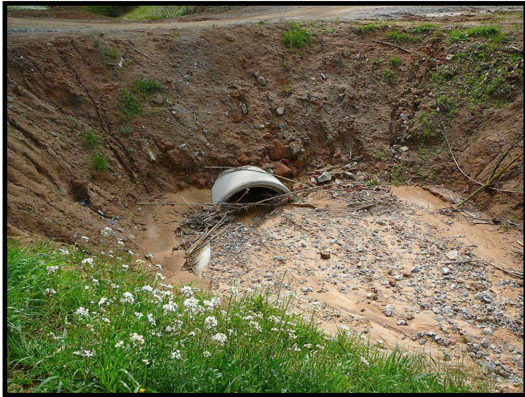
17. Aterramiento en boca de drenaje, aguas arriba del camino.
