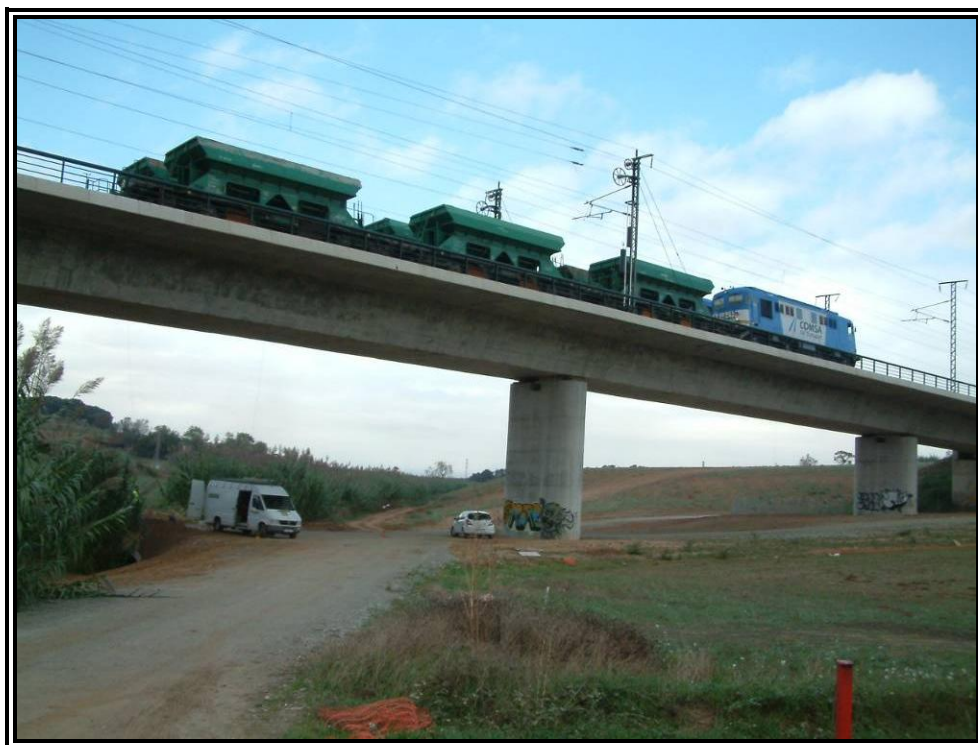
Nº 12.- Prueba estática Estado 5 (Vanos Nº 3 y Nº 4).
