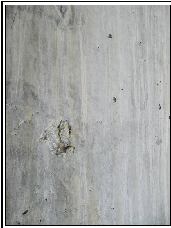
Coquera en pila 3
