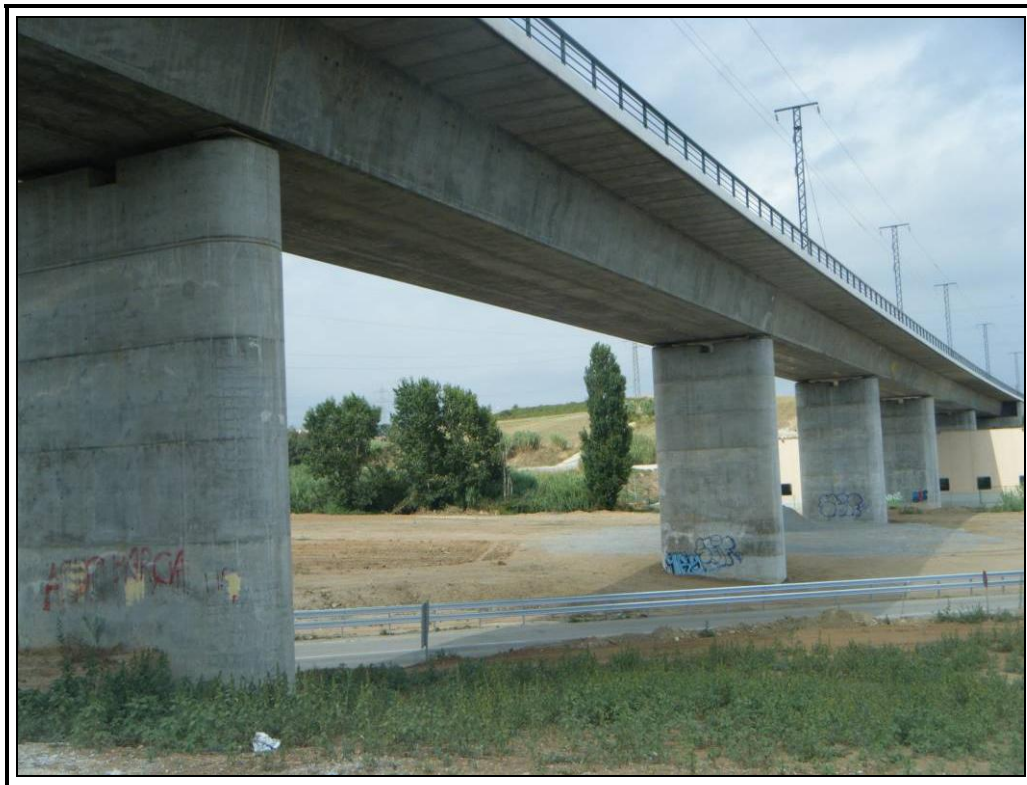
Alzado derecho, vista desde el estribo 1
