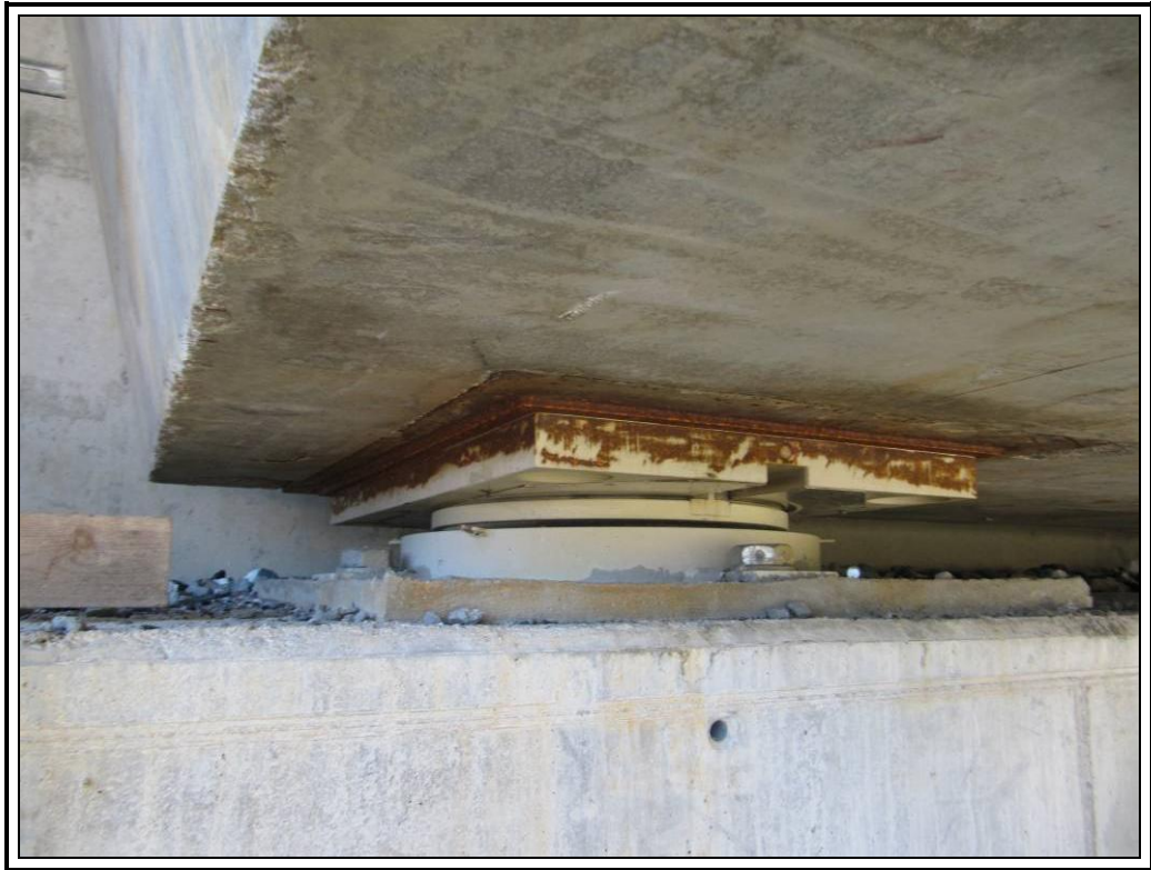
Apoyo derecho guiado de estribo uno
