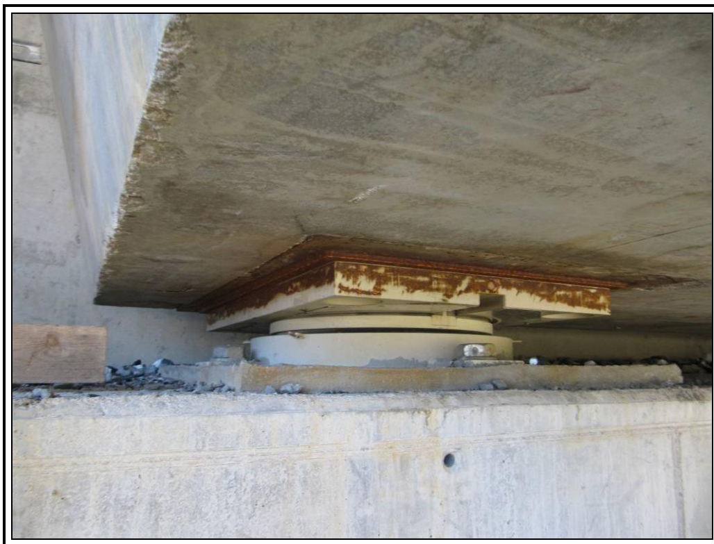
Apoyo derecho guiado de estribo uno
