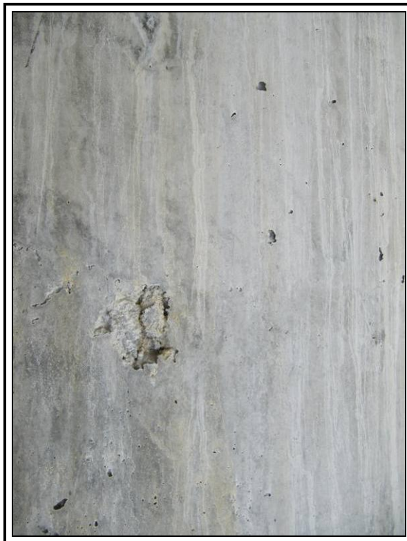
Coquera en pila 3
