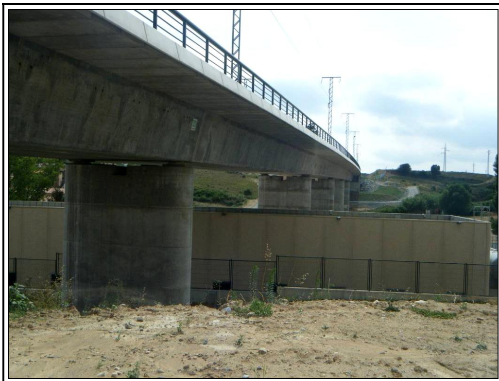
Alzado izquierdo, vista desde el estribo 2
