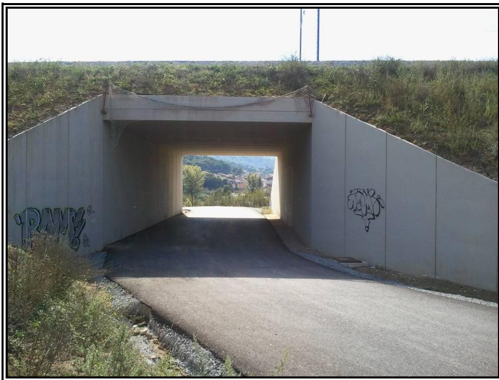
Nº 2.- Alzado izquierdo de la estructura.
