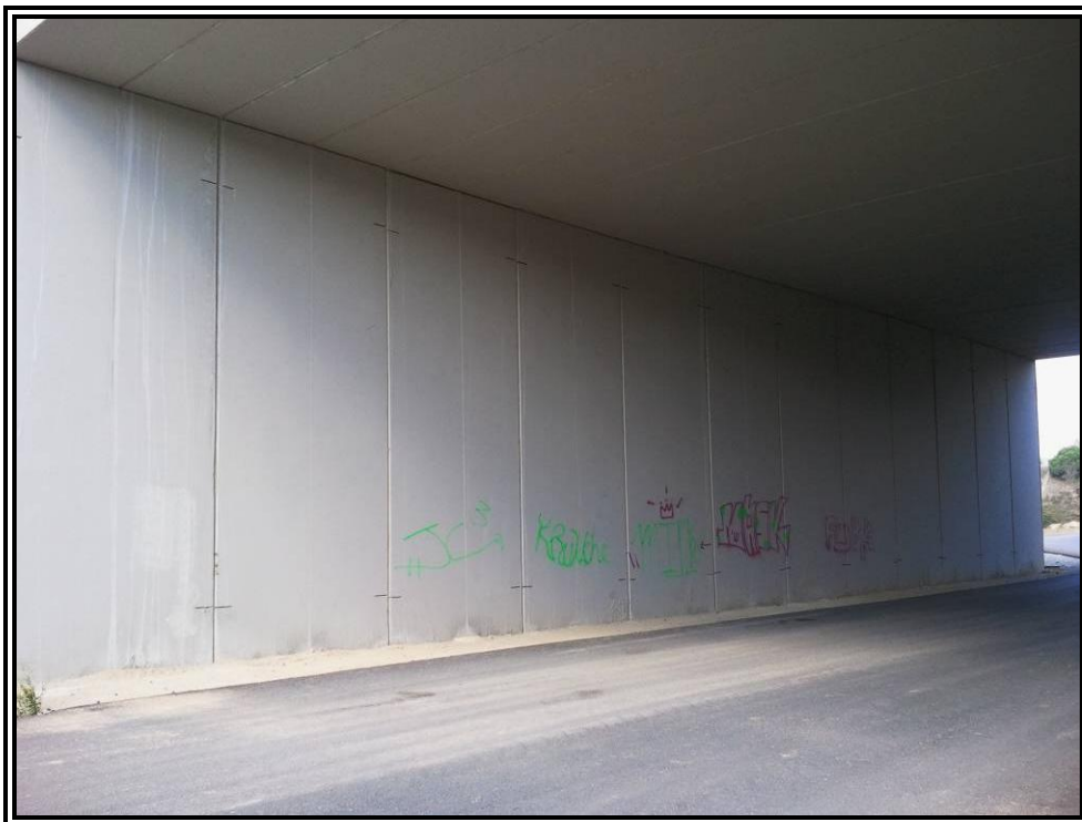
Nº 3.-Hastial izquierdo de la estructura.
