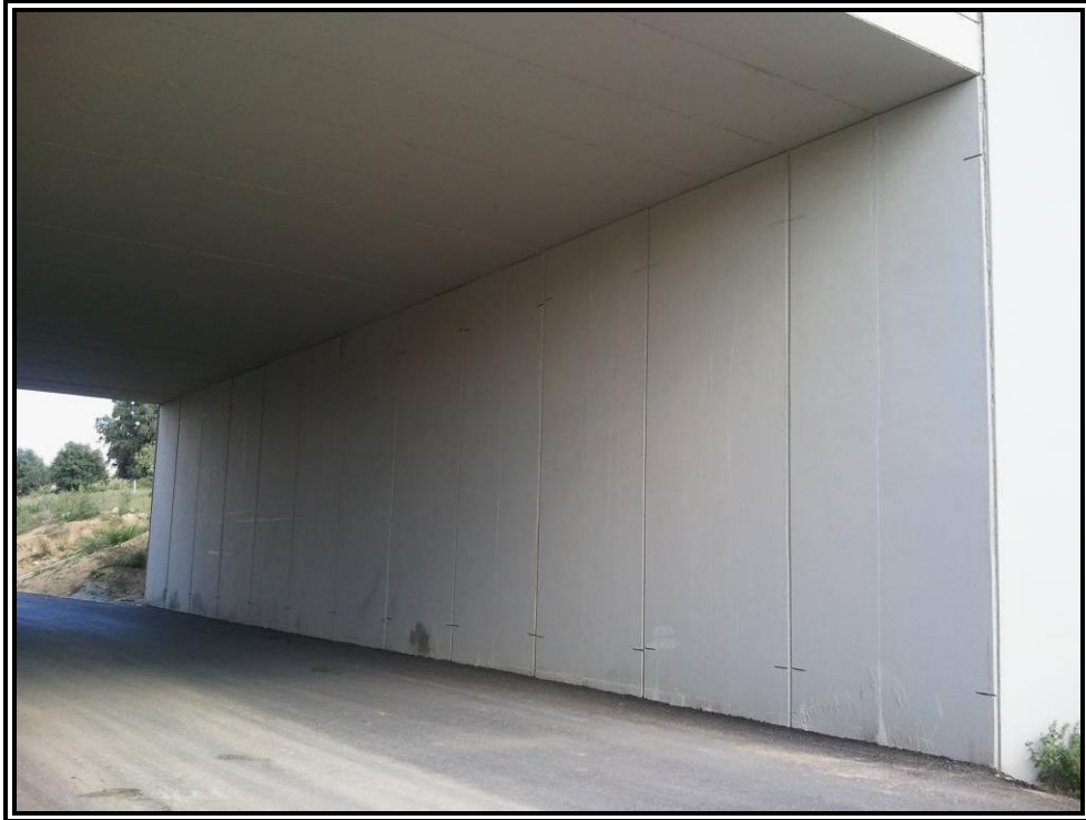
Nº 4.- Hastial derecho de la estructura.
