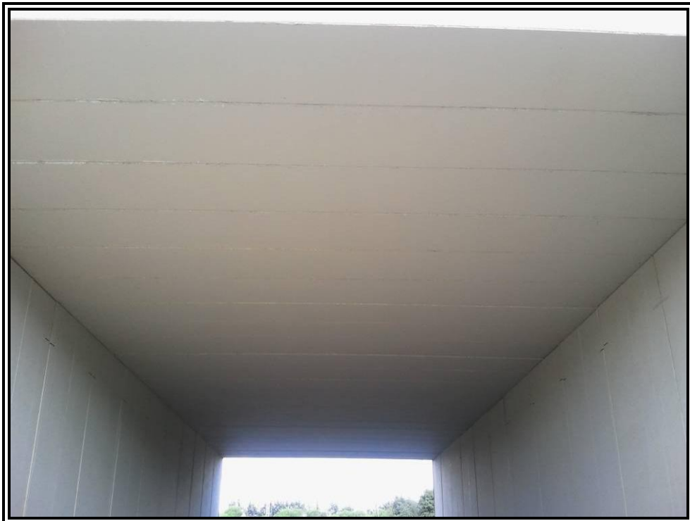
Nº 5.- Vista inferior de la losa mixta.
