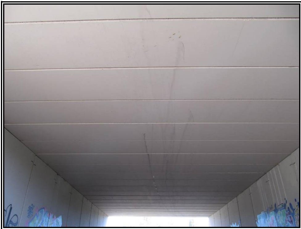
Nº 6.- Vista inferior de la losa mixta.
