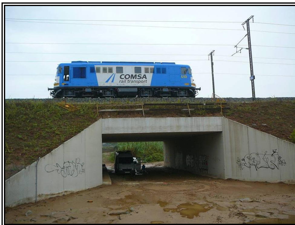
Nº 10.- Realización de prueba dinámica.
