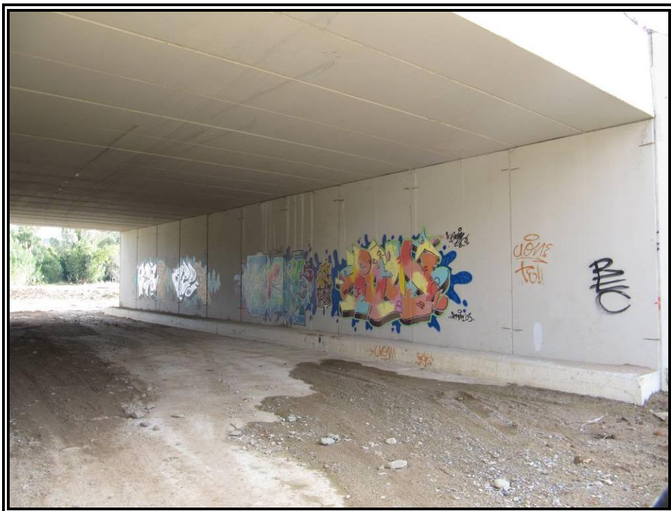
Nº 4.-Hastial derecho de la estructura.
