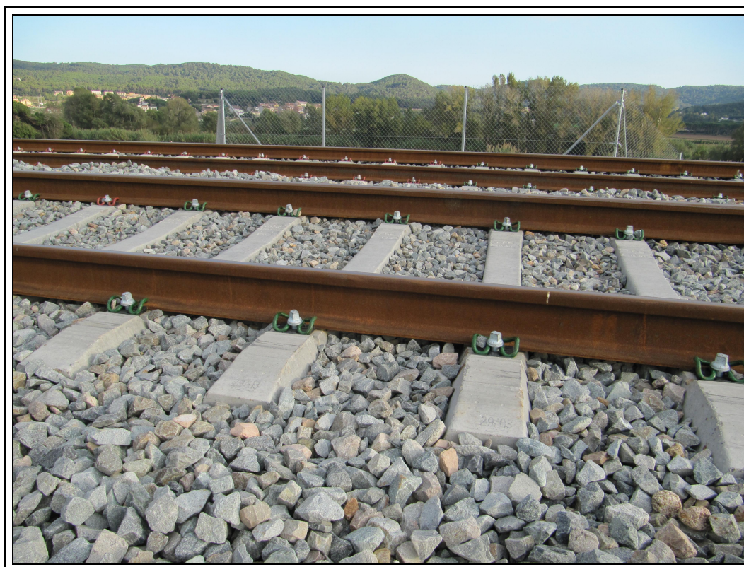
Material de vía
