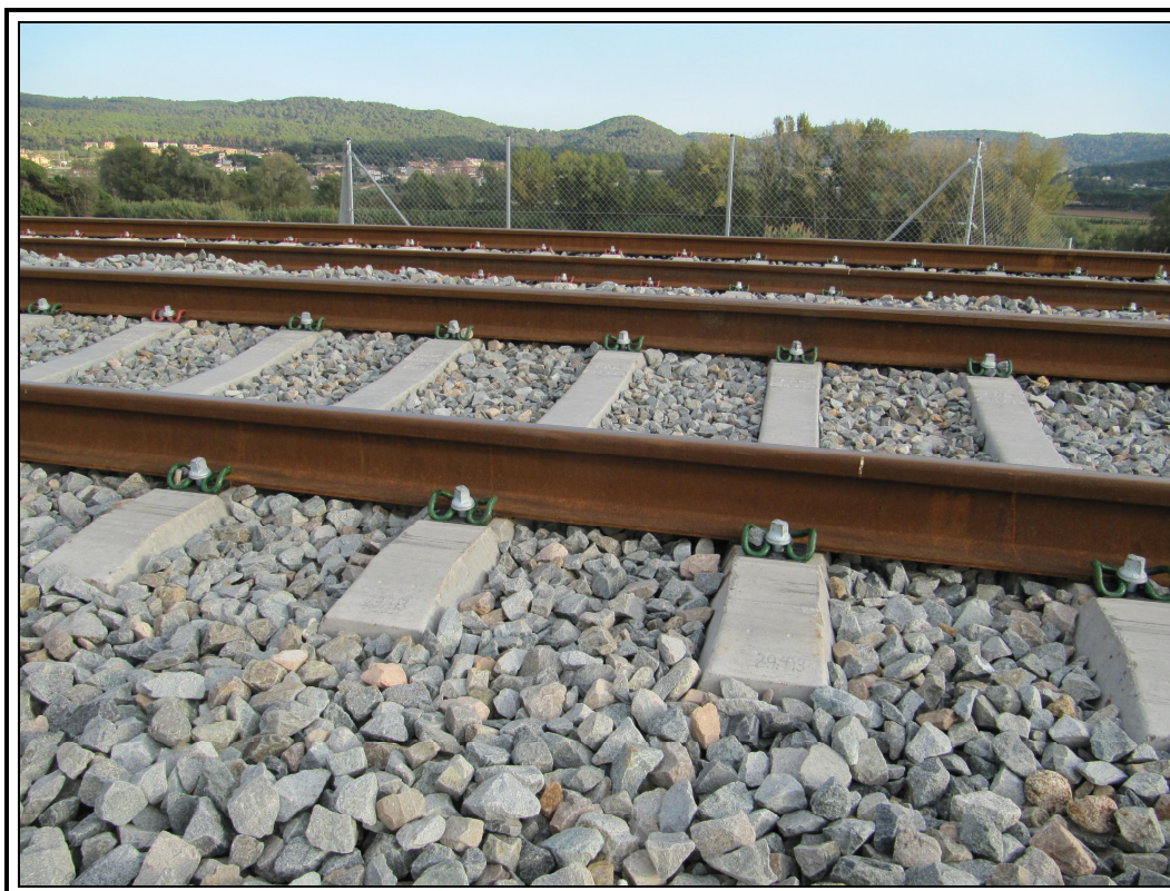
Material de vía
