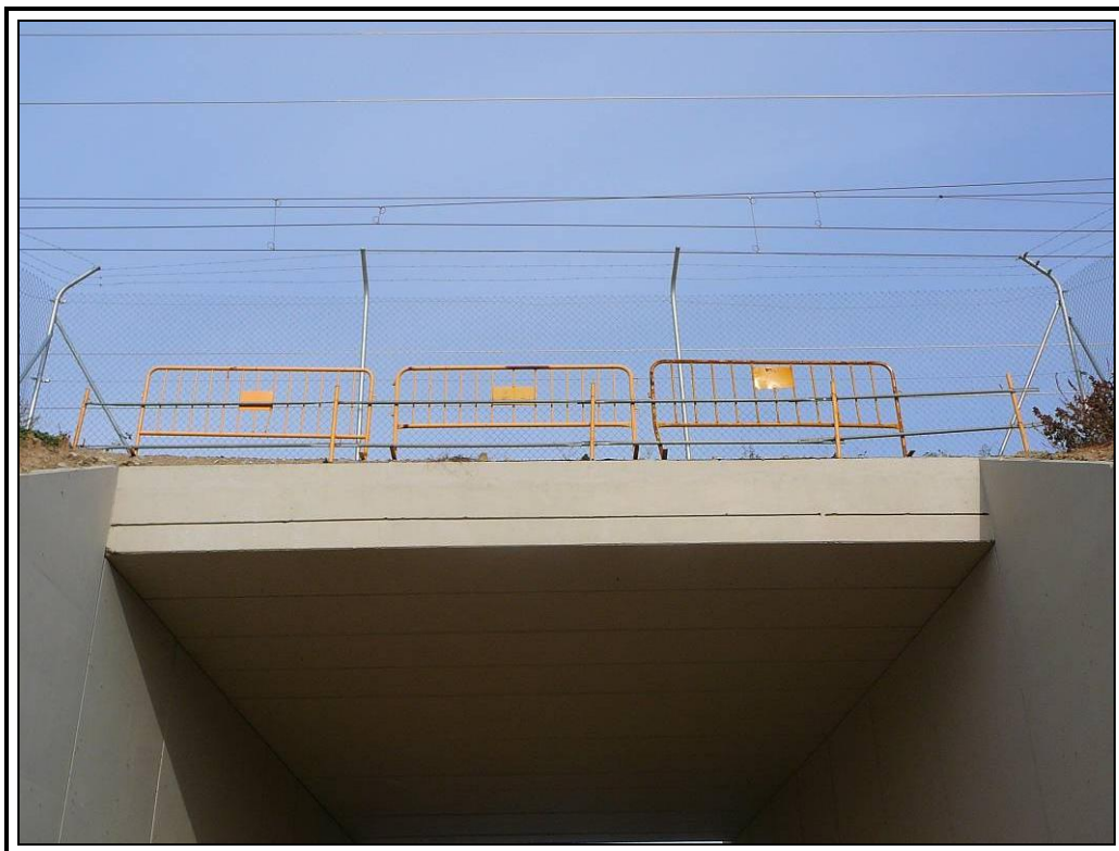
Vallas provisionales sin retirar
