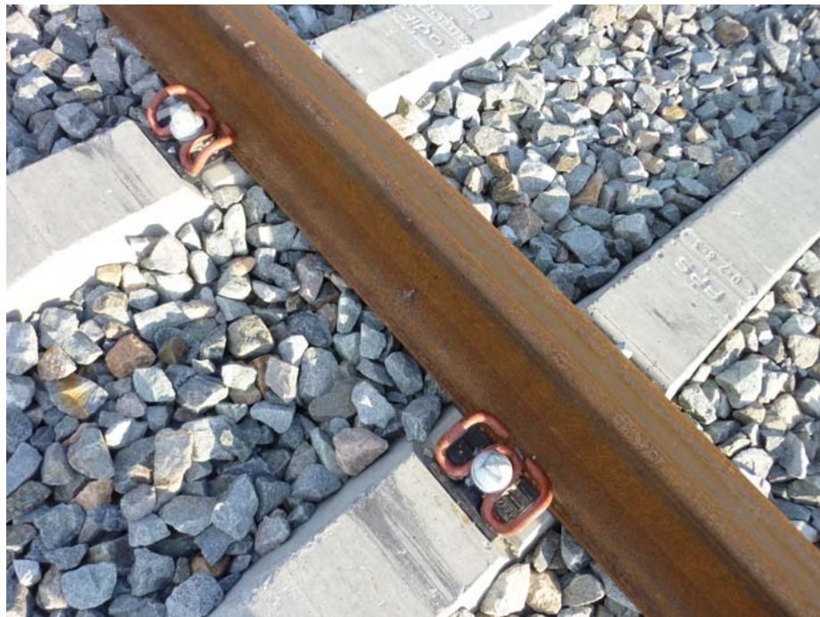
FOTOGRAFIA N° 7: Detalle de sujeción del carril
