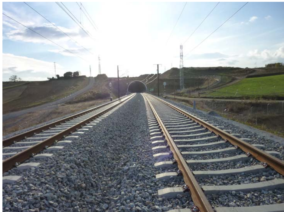
FOTOGRAFIA Nº 2: Vista superior del tablero dirección Barcelona
