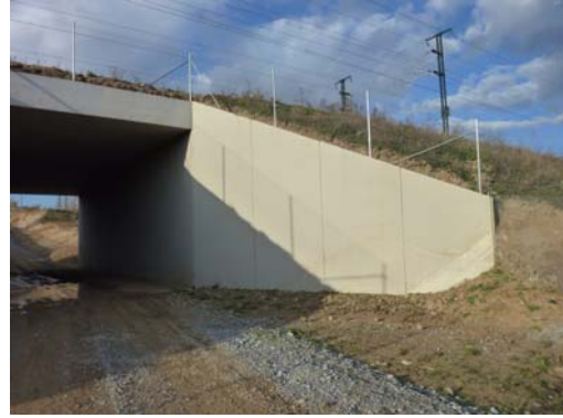
Fotografía nº 6. Estribo de salida
