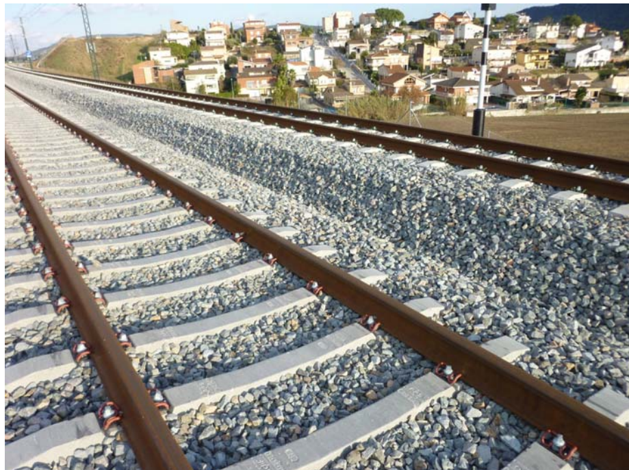
FOTOGRAFIA N° 6: Vista del material de vía
