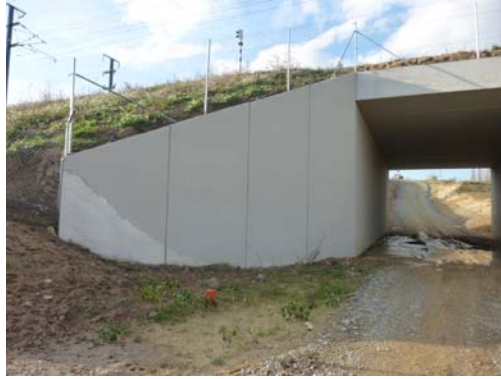
Fotografía nº 5. Estribo de entrada
