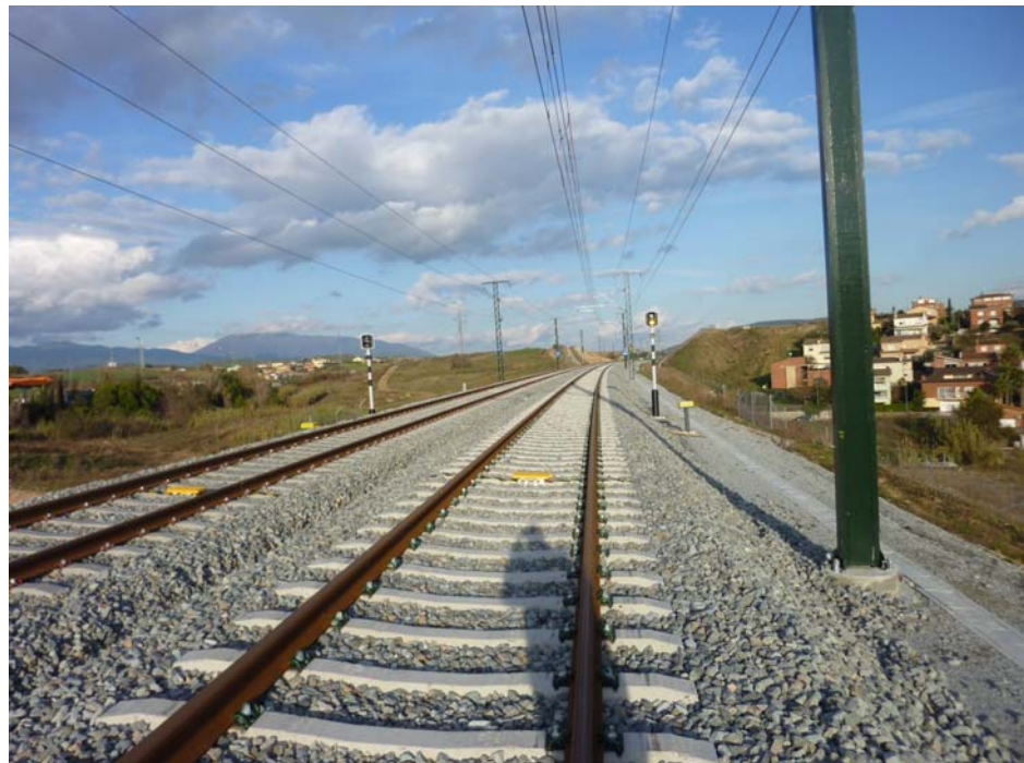
FOTOGRAFIA Nº 1: Vista Superior del tablero dirección Figueres
