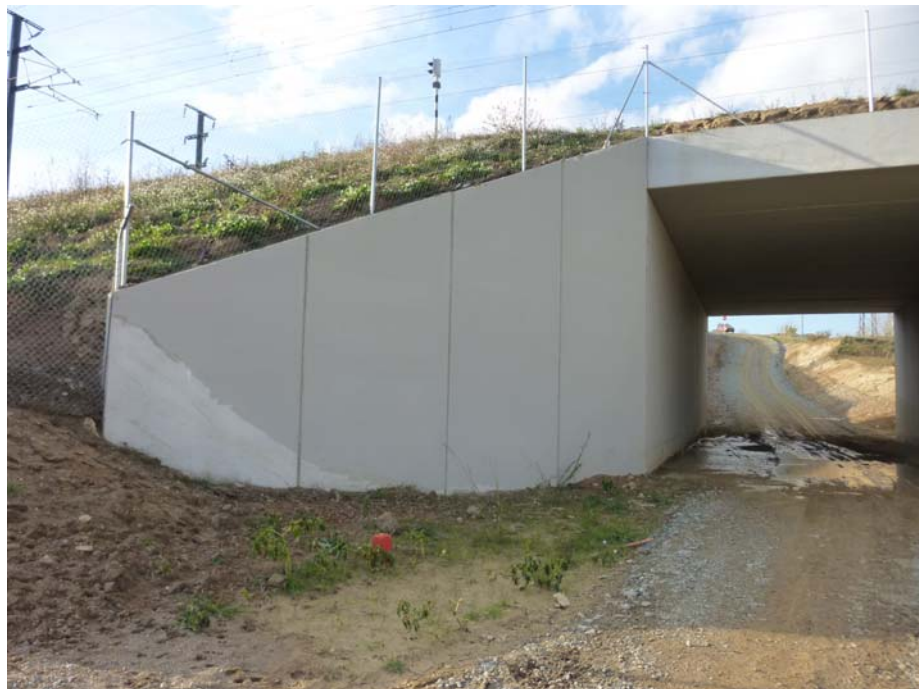
FOTOGRAFIA N° 10: Vista del estribo de entrada
