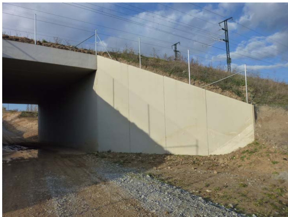
FOTOGRAFIA N° 11: Vista del estribo de salida
