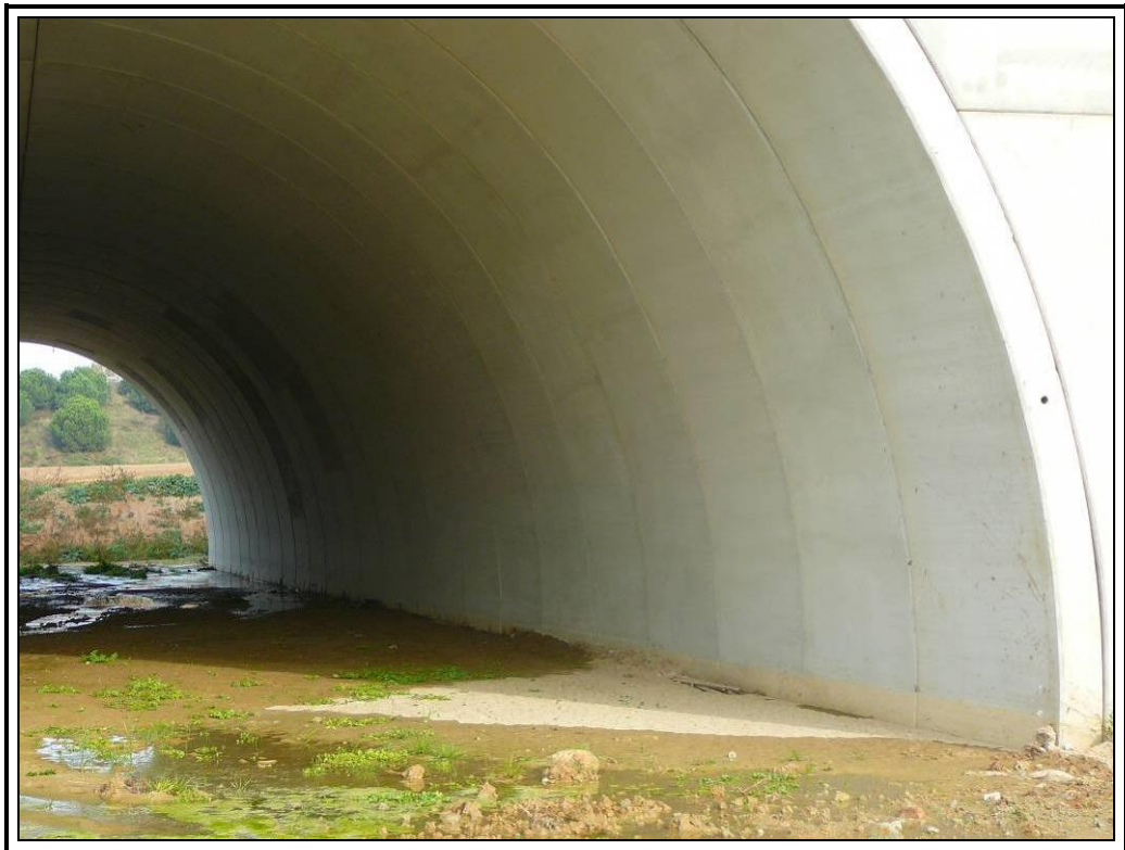
Semi-bóveda de salida
