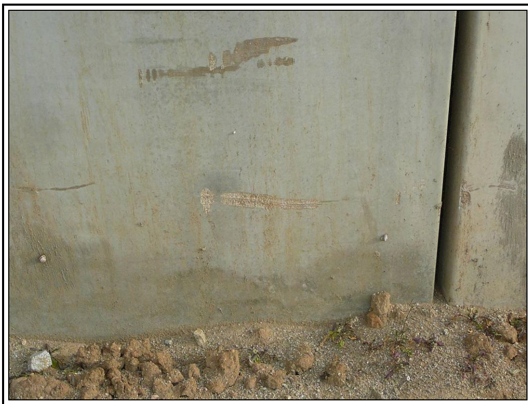
Desconchón en aleta derecha de hastial de salida
