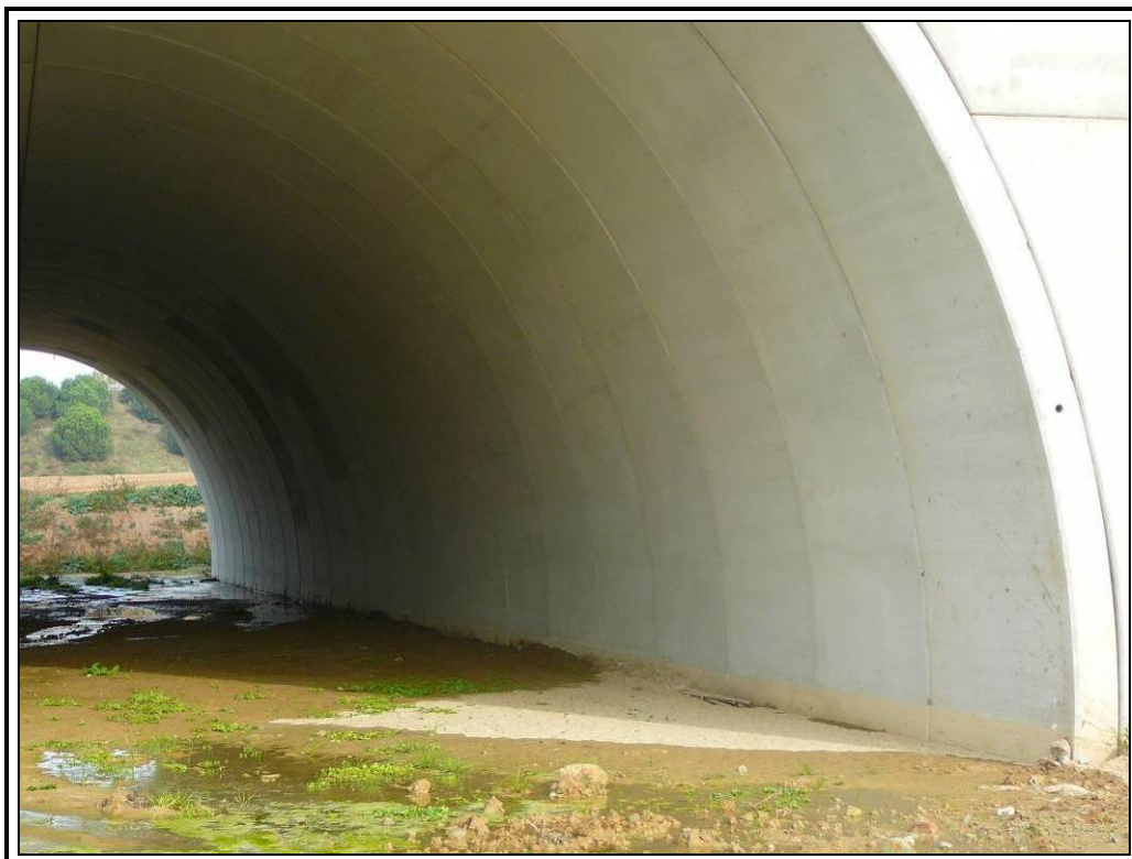
Semi-bóveda de salida
