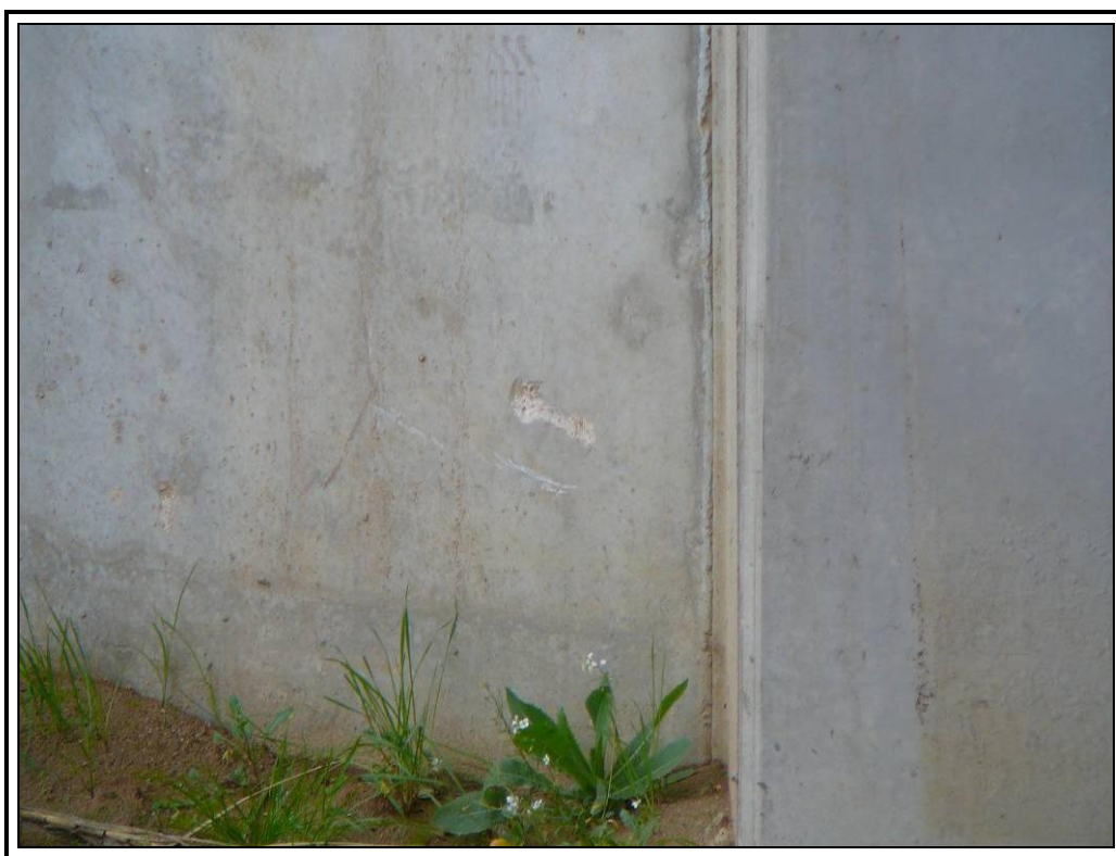
Desconchón en aleta izquierda de hastial de salida
