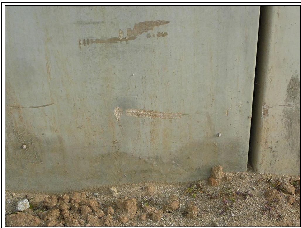
Desconchón en aleta derecha de hastial de salida
