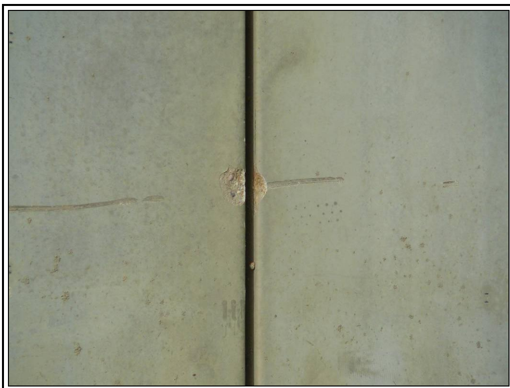
Desconchón en aleta derecha de hastial de entrada.
