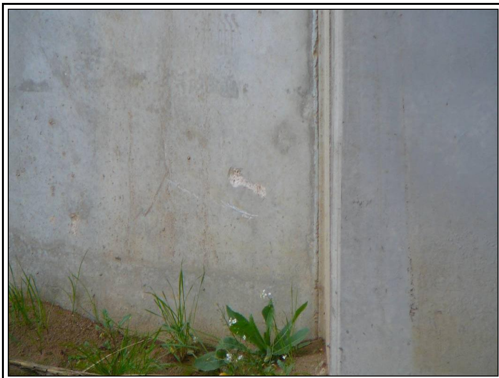
Desconchón en aleta izquierda de hastial de salida
